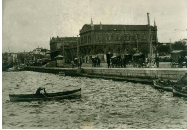
Şekil 2.25. Kadıköy Hal Binası
