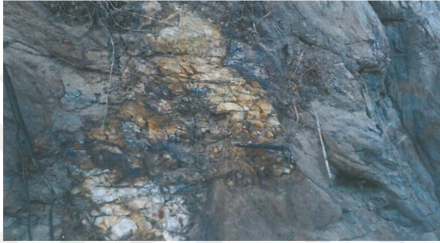
Şekil 4.6. İnceleme alanında ayrışma seviyelerinden görünüm
