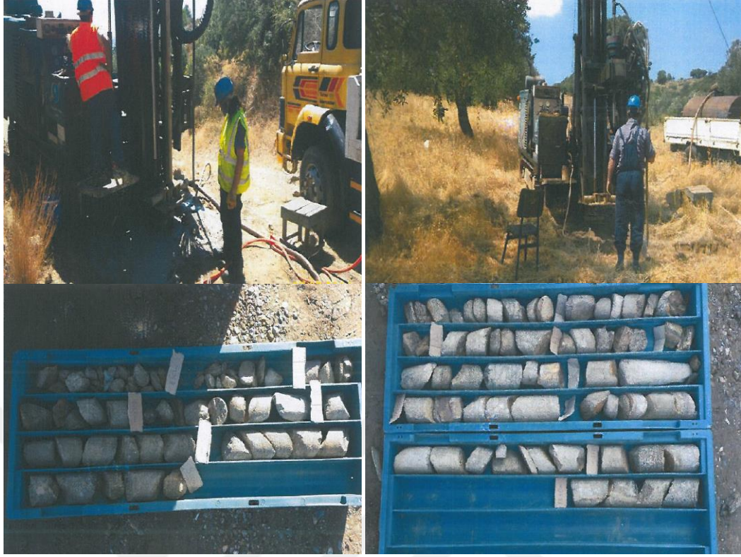
Şekil 4.8. İnceleme alanındaki sondaj çalışmalarından görünüm
