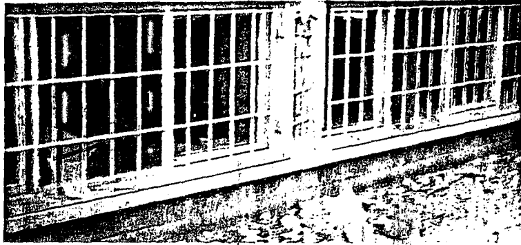
RESİM 4.12 Kısa Kolon örneği (Dinar Lisesi).
