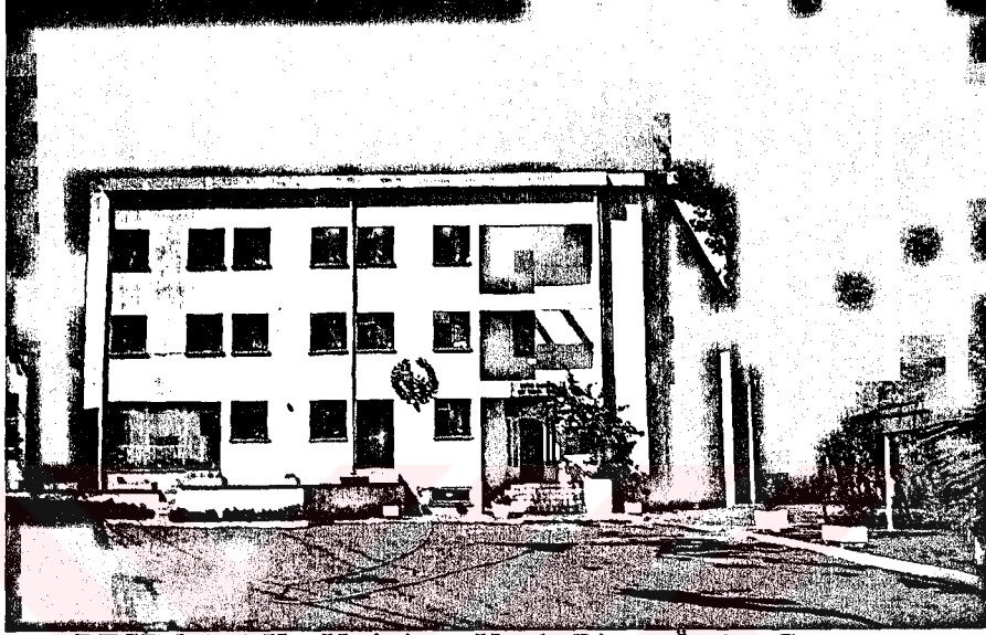
RESİM 7.10 Kız Yetiştirme Yurdu Binası Önden Görünüşü.
