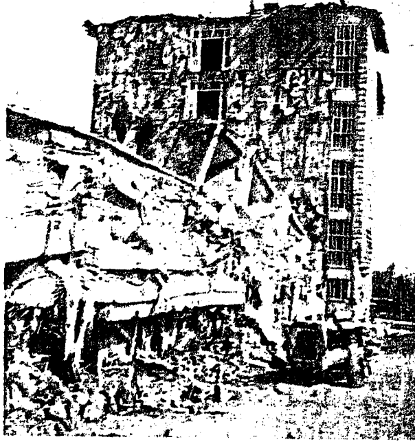
RESİM 4.7 Sağlık Meslek lisesinin yıkılan batı ucunun arkadan görünüşü.
