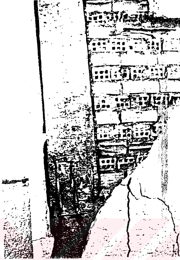
RESİM 4.10 Askeri Hastanede mafsallaşmış kolon.
