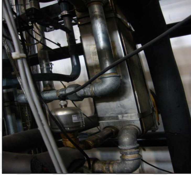
řekil 5.3: Su Isıtmalı Evaporatör.
