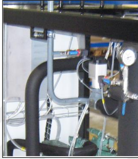
Şekil 5.12: Yüksek Basınç Kontrol Valfi (ICMT).
