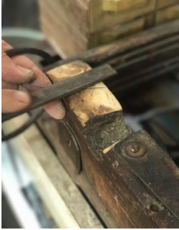
Resim 4.59. Gümüş telin uçlarını eğe ile inceltilmesi
