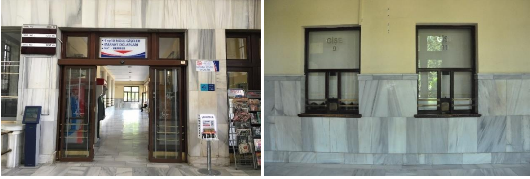
Görsel 54. Ana salondan bagaj bölümüne açılan koridor girişi, solda market başlangıcı (solda), Bagaj bölümüne giden koridordaki artık kullanılmayan gişeler (Yazarın arşivinden)
