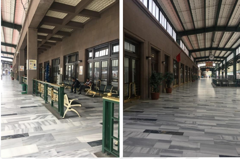
Görsel 73. Peron alanının Zemin döşemesi, tavan kaplaması ve duvar yüzeylerine ait genel görünüm (Yazarın arşivinden)
