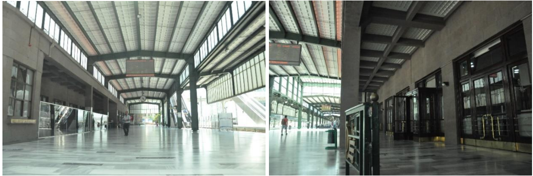
Görsel 68. Peron alanının sol kanadından genel görünüm (Yazarın arşivinden)
