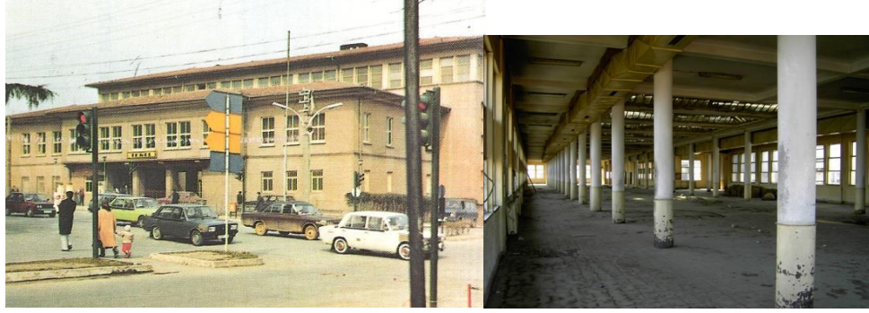
Şekil 4.44 : Trabzon Tekel Binası ana giriş kısmı (sol) ve iç mekânda yer alan yuvarlak kolonlar (sağ) (M.R. Sümerkan kişisel arşivinden alınmış görsellere Gürkan Topaloğlu'nun tezinden ulaşılmıştır).
