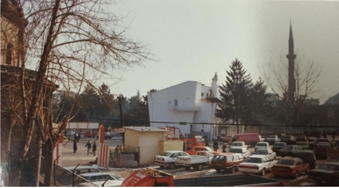
  kil 4.52 : Zeynel Abidin ve Hunat K  lliyesi arasındaki Turizm Binası (Kayseri K  lt  r ve Tabiat Varlıkları Koruma Kurulu Ar  ivi).
