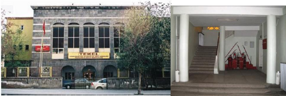
Şekil 4.45 : Diyarbakır Eski Tekel Binası (sol) ve 2008 yılına ait iç mekân fotoğrafı (sağ) (Url-17) (Url-18).
