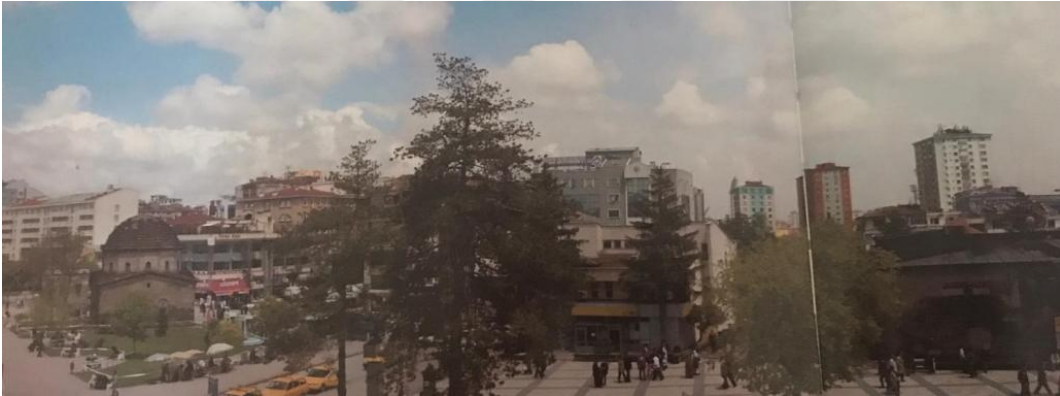
  kil 4.53 : Zeynel Abidin ve Hunat K  lliyesi arasındaki Turizm Binası 2006 (Kayseri K  lt  r ve Tabiat Varlıkları Koruma Kurulu Ar  ivi).
