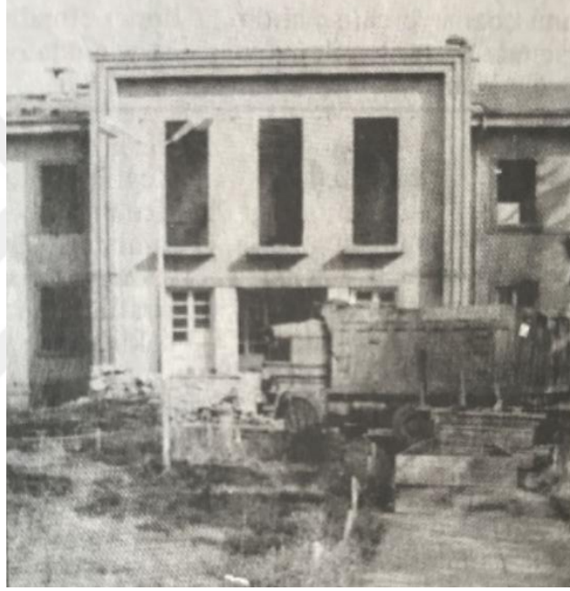
Şekil 5.40 : Hükümet Konağı yıkım çalışmaları (15 Ocak 1996 Kayseri Gündem Gazetesi).
