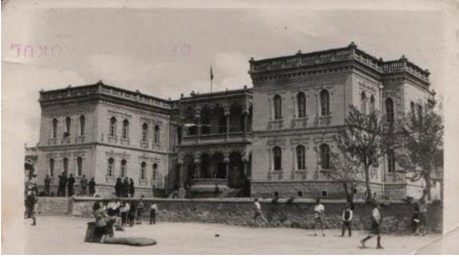
Şekil 2.3 : Kayseri Develi Lisesi (Url-5).
