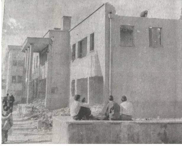
Şekil 4.38 : Tekel Binası yıkılırken (29 Şubat 1996 Kayseri Gündem Gazetesi).
