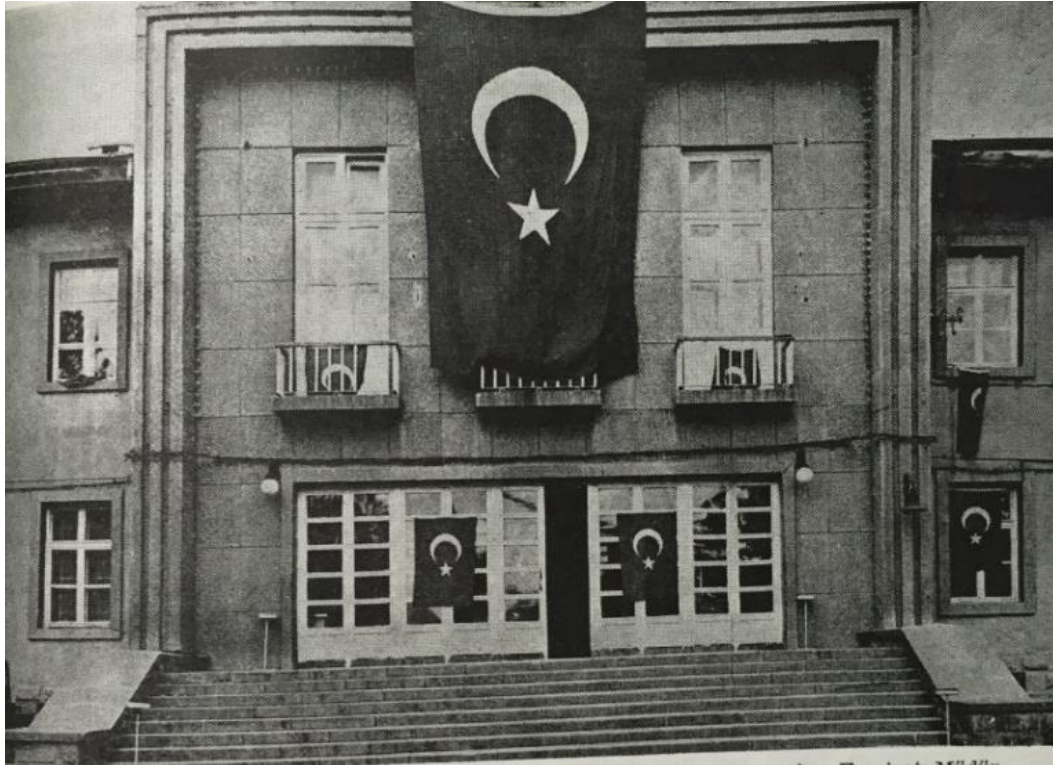
Şekil 5.37 : Hükümet Konağı Giriş Kapısı (Kayseri İl Yıllığı, 1973).
