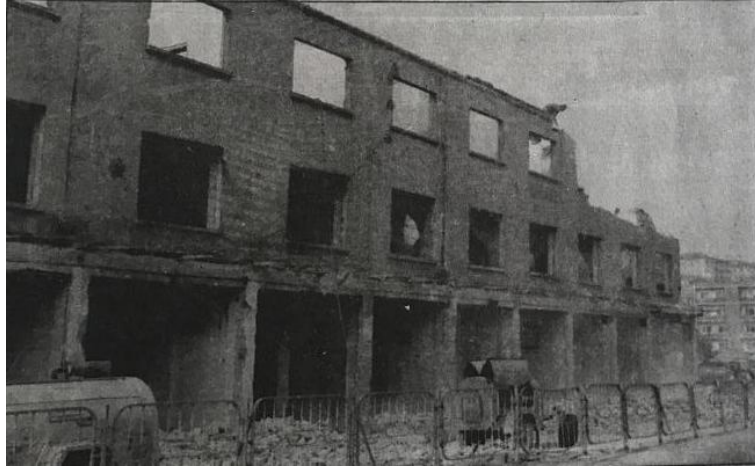
Şekil 4.51: Fevzioğlu İşhanı yıkım çalışmaları (25 Eylül 1995 Yeni Kayseri Gazetesi).
