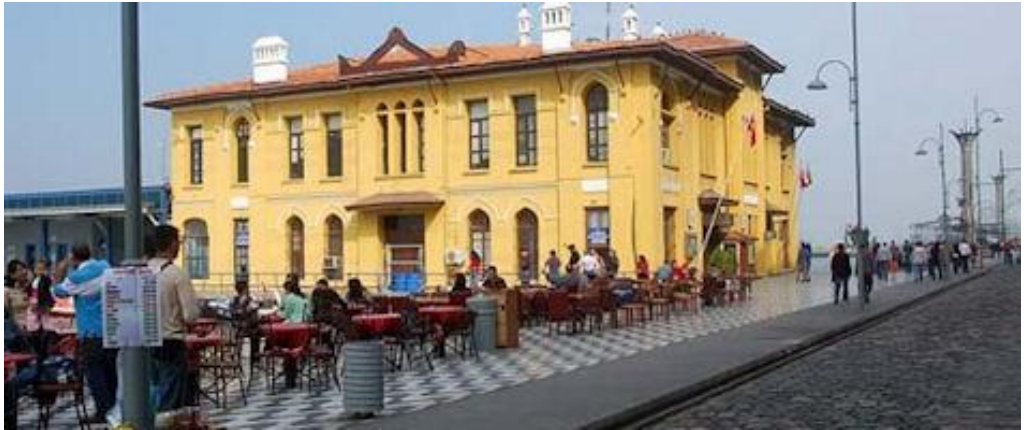
řekil 4.41 : İzmir Tekel Binası (Url-15).
