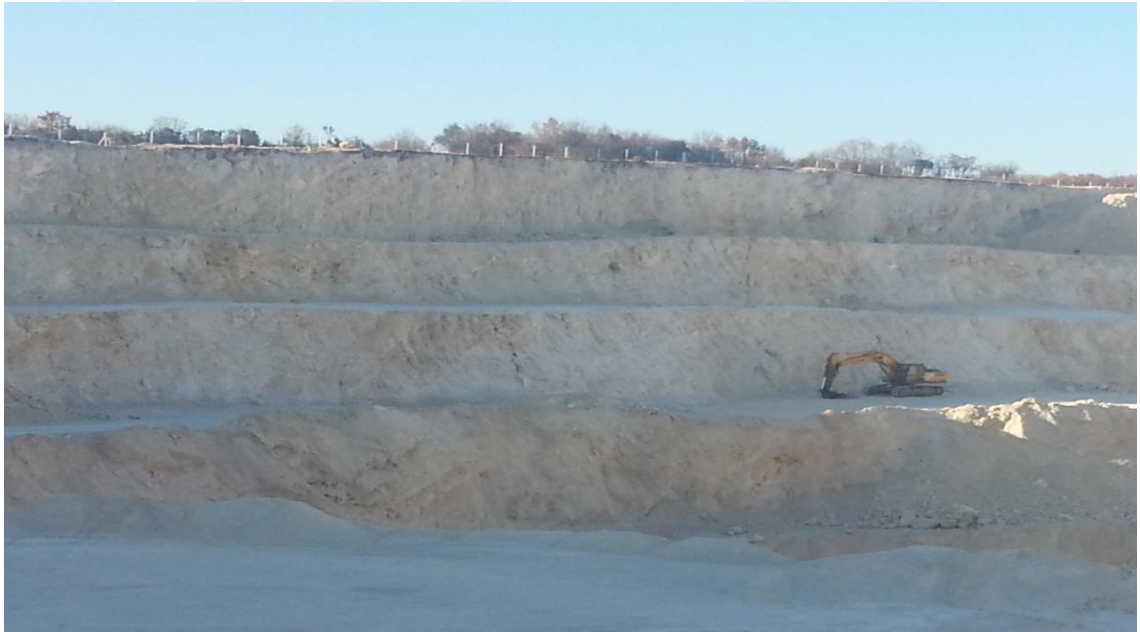
Şekil 4.1. Patlatma çalışmaları yapılan ocağın görünümü
