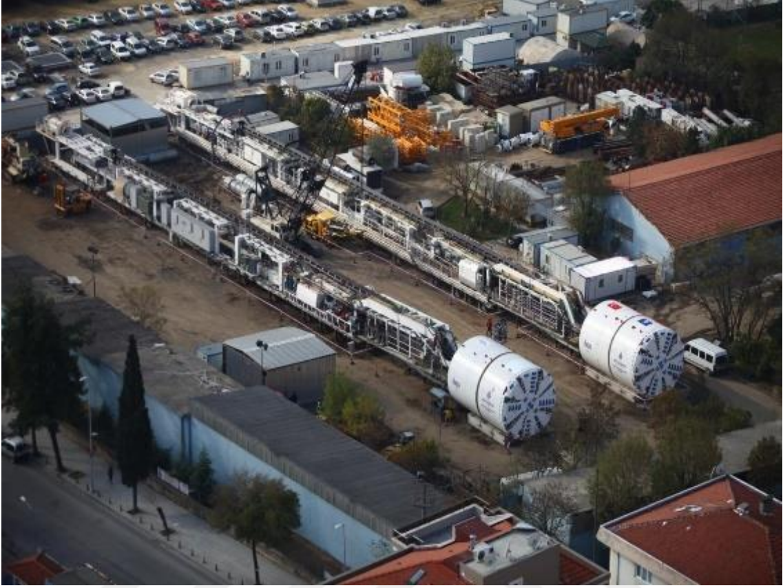
Şekil 2.5: TBM'in Yüzeydeki Görüntüsü
