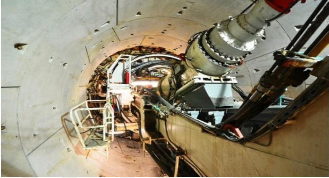
Şekil 2.6: TBM'in Tüneldeki Görüntüsü
