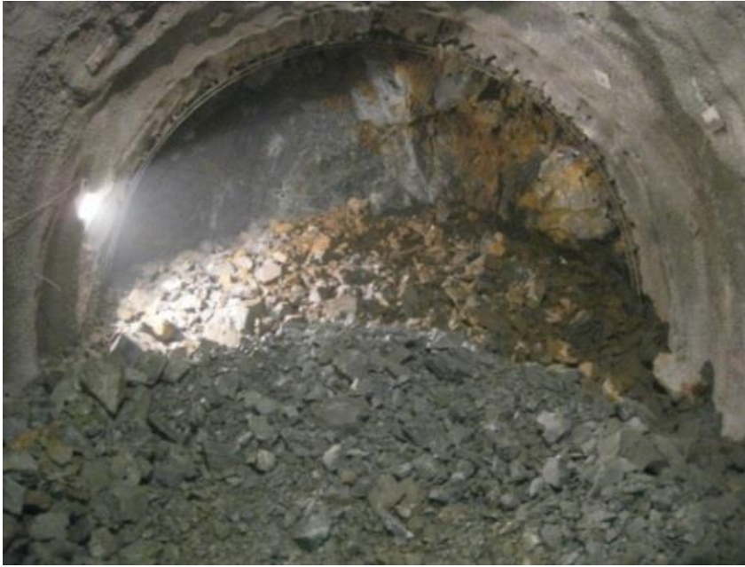
Şekil 2.3: Delme-Patlatma Sonrası Tünel Aynasının Görünümü
