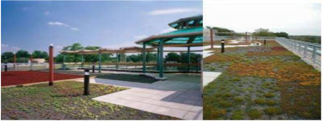
Şekil 2.17. Seyrek bitkilendirilmiş (intensif) yeşil çatı örneği; Eastern Village, Lila Fendrick, SilverSpring, Maryland [57].
