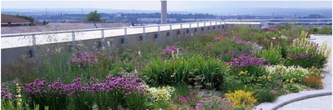
Şekil 2.23. Moorgate Crofts İş Merkezi yeşil çatısı [78].
