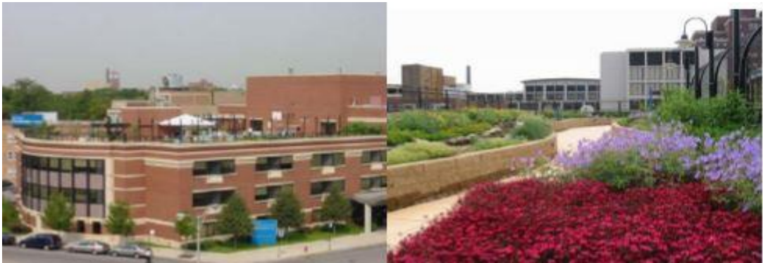
Şekil 2.18. Yoğun bitkilendirilmiş (ekstensif) yeşil çatı örneği; Schwab Rehabilitasyon Hastanesi, Stephen Rankin, Chicago, Illinois [57].
