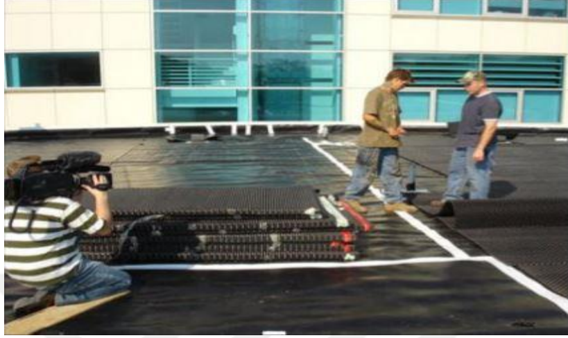
Şekil 2.14. Kök tutucu tabaka ve drenaj tabakası [66].
