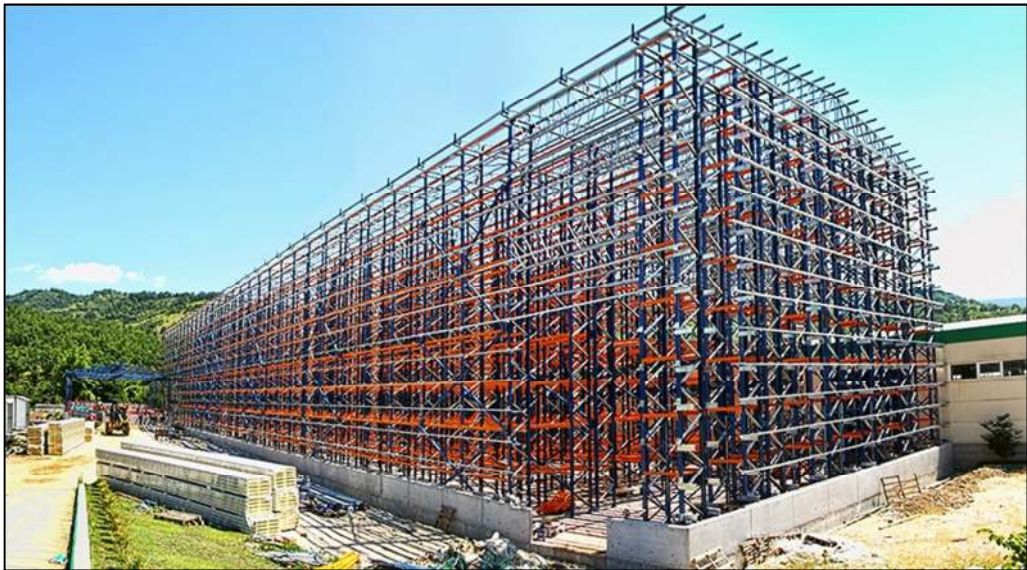
Şekil 1.6. Dış Giydirme raf sistemleri genel görünüm
