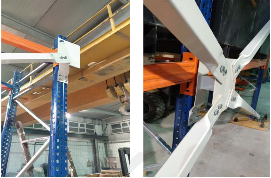
b) Deprem çaprazı genel görünümü
