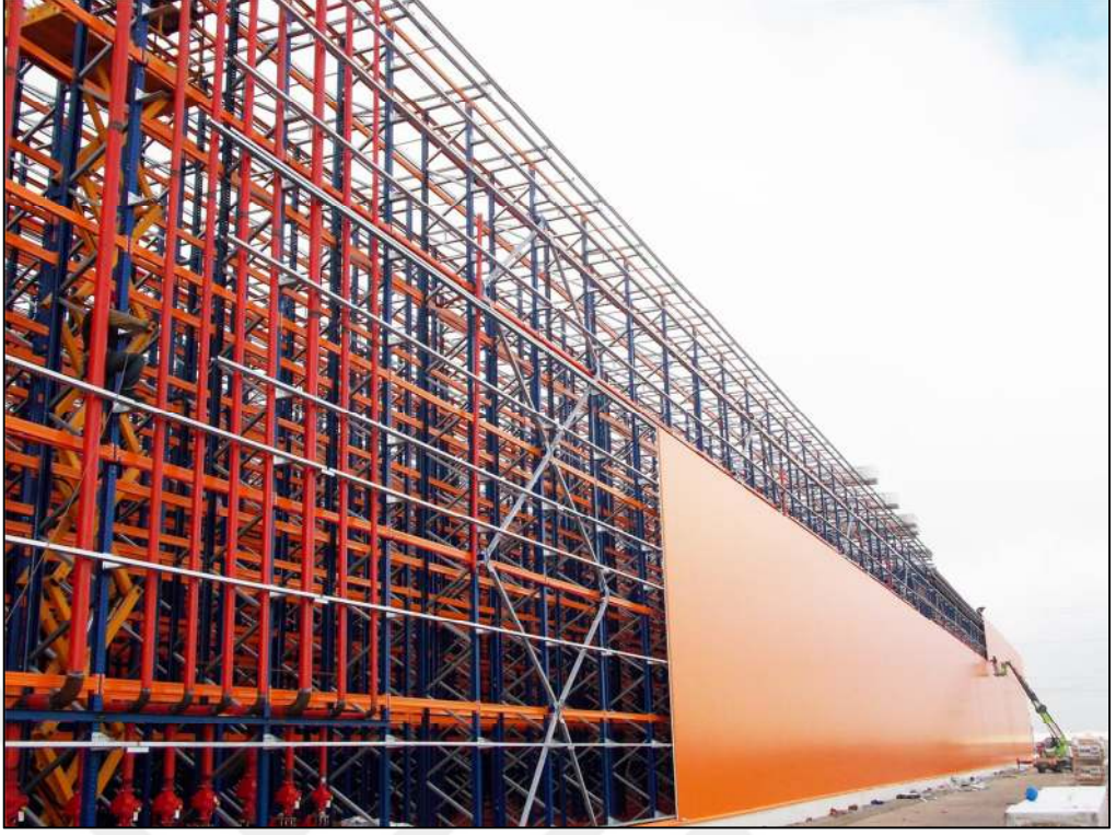
Şekil 1.7. Dış Giydirme raf sistemleri genel görünüm
