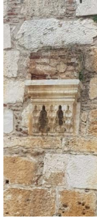
Şekil 20. Avlu Duvarında Bulunan Taşıyıcı Konsol
