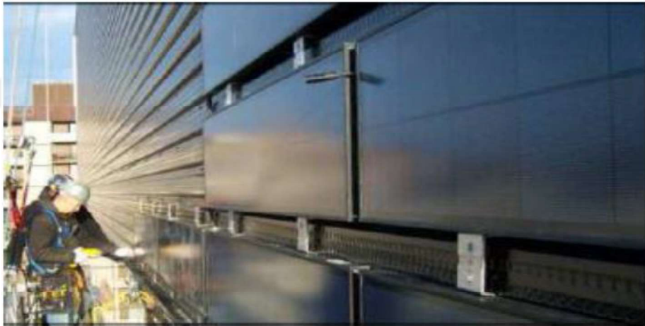
Şekil 4.28. Concordia Üniversitesi güneş duvarı uygulaması (Solarwall, 2013)
