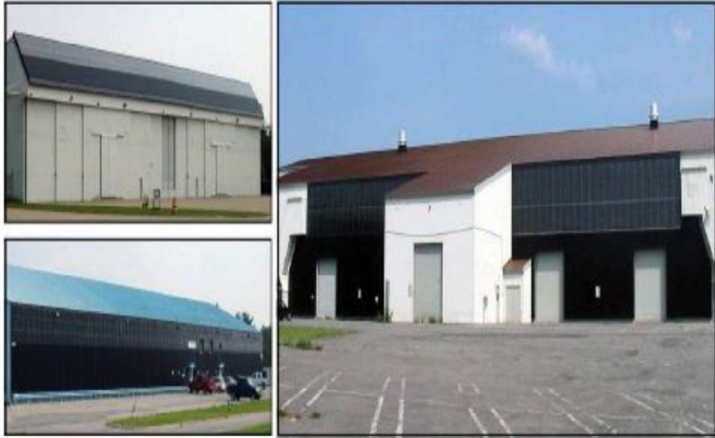
Şekil 4.27. Uluslararası Plattsburgh Havalimanında iki aşamalı güneş duvarının hangar ve tesis uygulaması (Solarwall, 2013)
