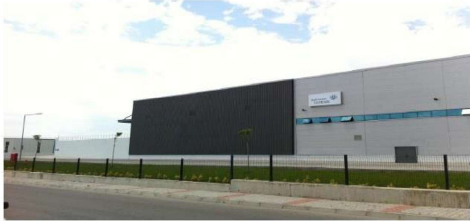
Şekil 4.30. CRH Grup tesislerinde camsız ve transparan güneş duvarı uygulaması (Solarwall, 2013)
