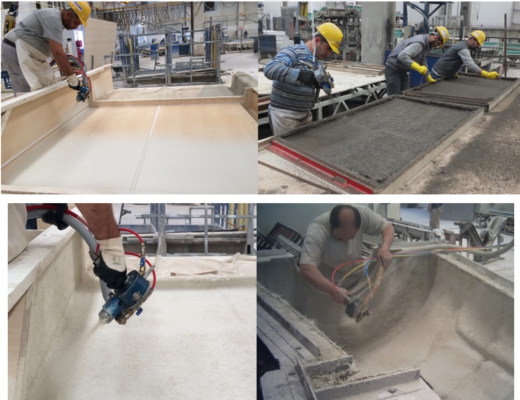
Şekil 2.20. Buğu tabakası, püskürtme döküm işlemi ve rulolama ile sıkıştırma.
