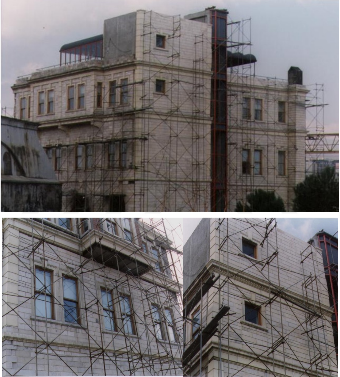
Şekil 7.1. GRC-CTB restorasyon uygulaması.
