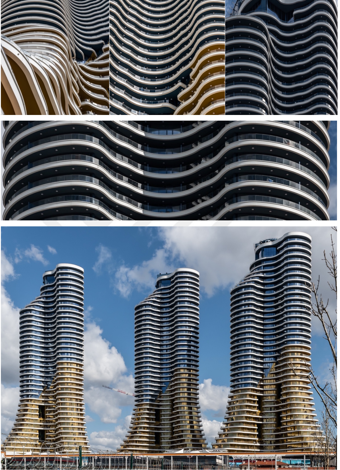
Şekil 7.14. GRC-CTB özel geometrili ve eğrisel parapet kaplamaları (Fotoğraf Hacer Bozkurt).
