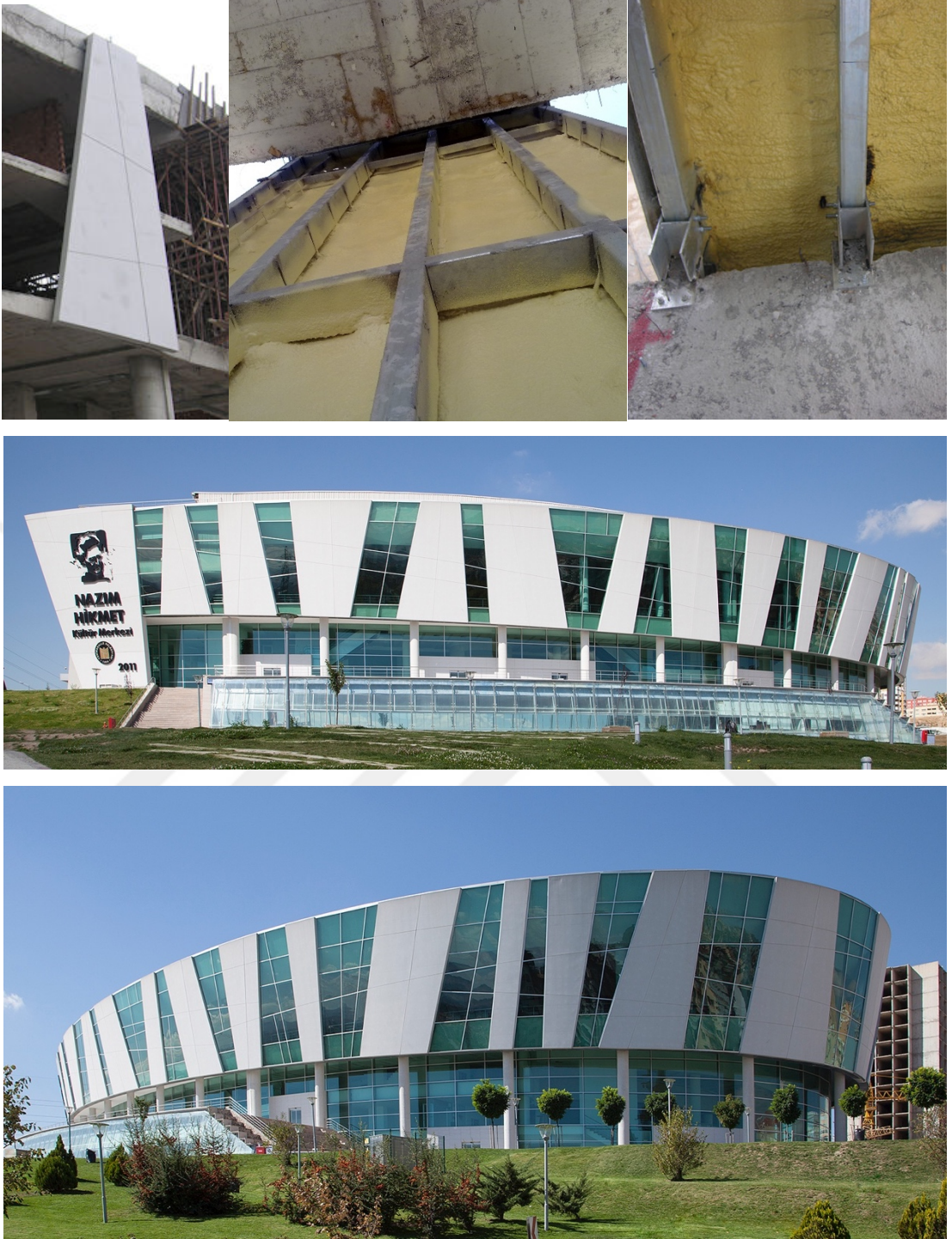
 ekil 7.5. GRC-CTB  elik karkaslı b y k boyutlu panel uygulaması.
