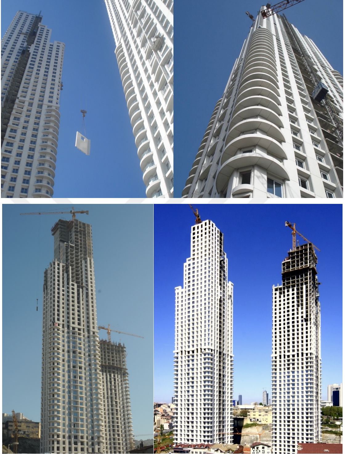
Şekil 7.8. GRC-CTB kendinden yalıtımlı panel kaplama uygulaması.
