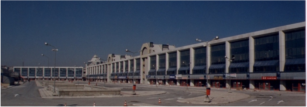
Şekil 7.2. GRC-CTB cephe kaplama uygulaması.
