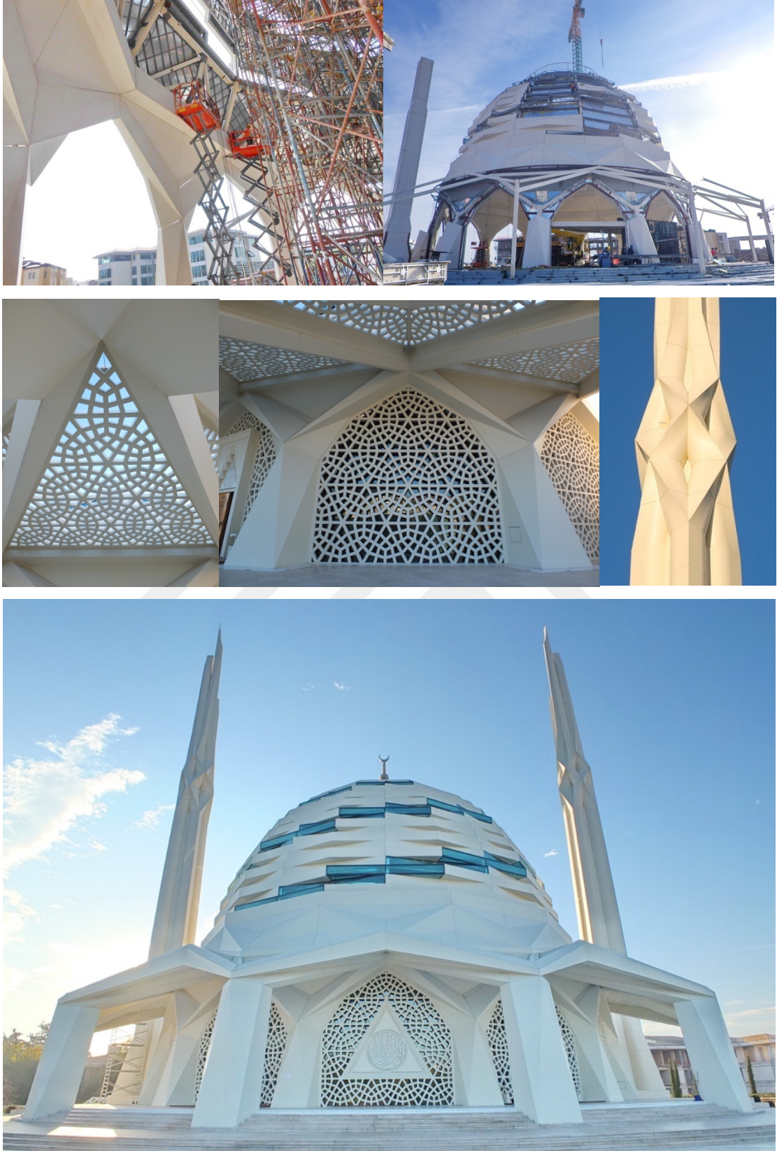
Şekil 7.13. GRC-CTB çelik taşıyıcı sisteme monte edilen kaplamalar.
