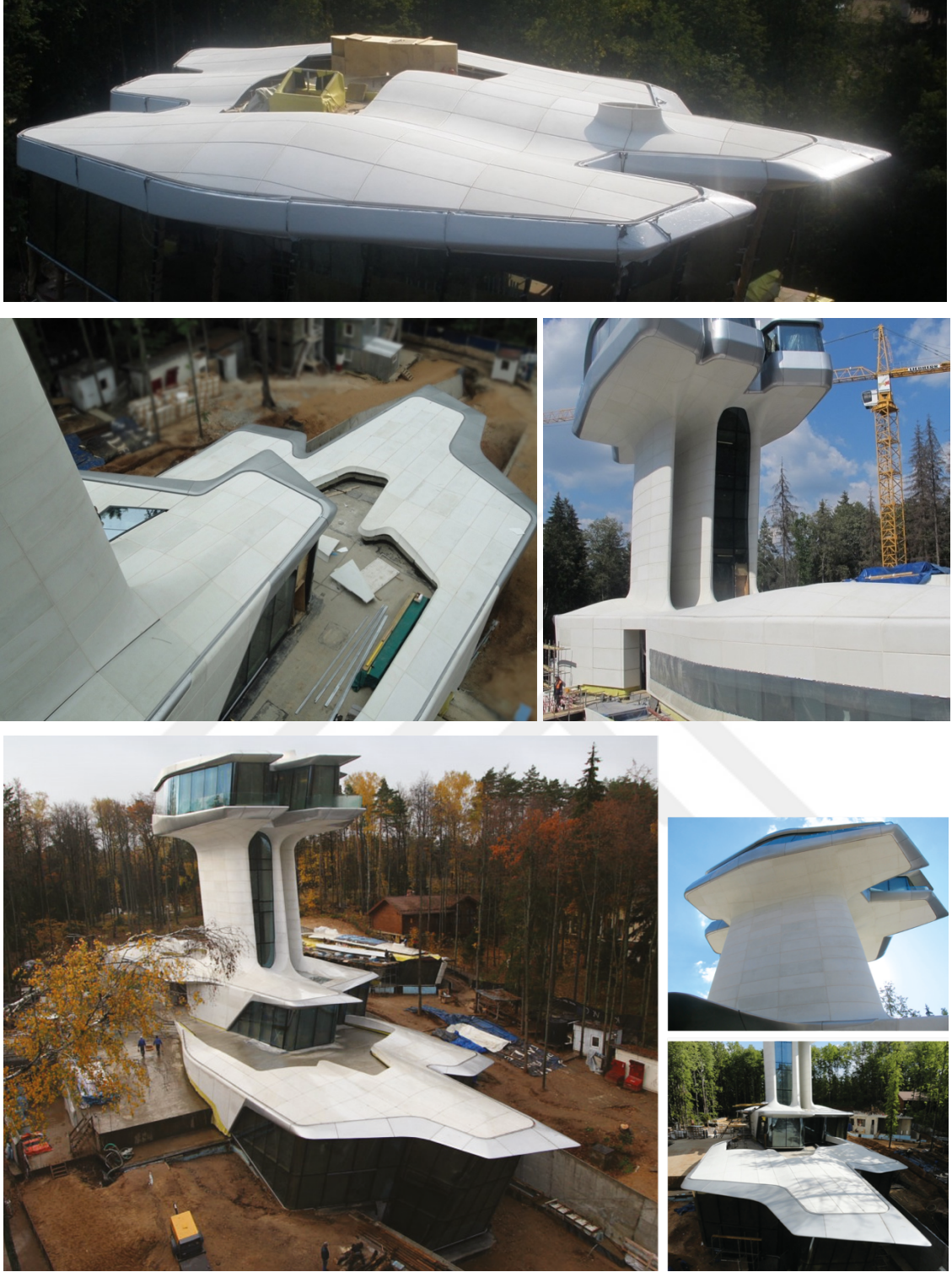
Şekil 7.9. GRC-CTB organik formlu kaplama uygulaması.
