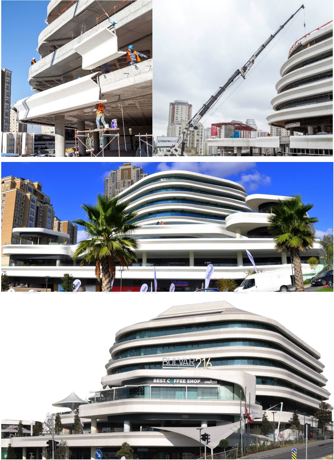
Şekil 7.11. GRC-CTB eğrisel ve çift eğrilikli yüzey kaplamaları.
