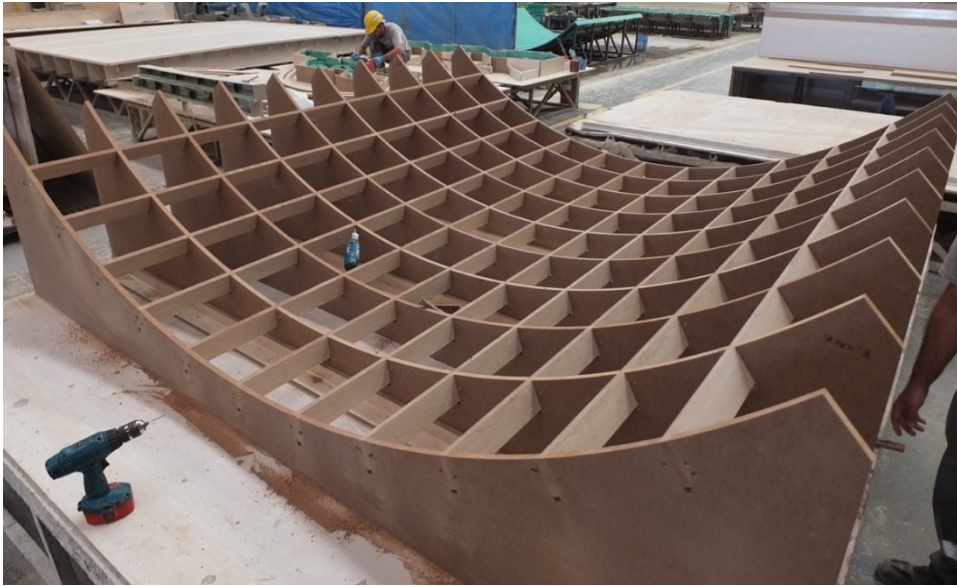
Şekil 2.17. Ahşap eğrisel kalıp yapımı.
