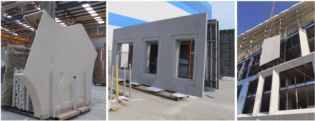
Şekil 2.34. GRC-CTB Cephe panelleri ve uygulaması.
