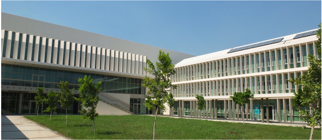
Şekil 7.10. GRC-CTB kendinden renkli narin lamel uygulaması.
