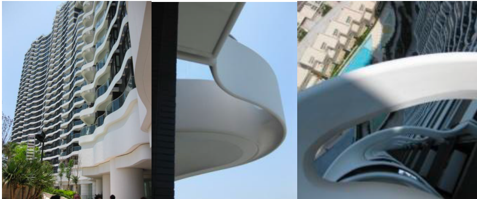
Şekil 2.39. GRC-CTB Kalıcı kalıp olarak kullanımı (Hong Kong) [67].
