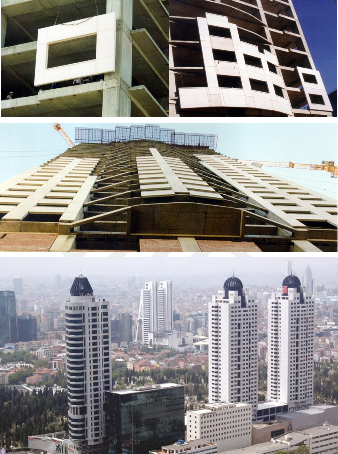
Şekil 7.3. GRC-CTB kendinden yalıtımlı panel kaplama uygulaması.
