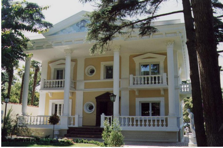
Şekil 2.35. GRC-CTB Dekoratif cephe elemanları kullanılmış bir yapı.
