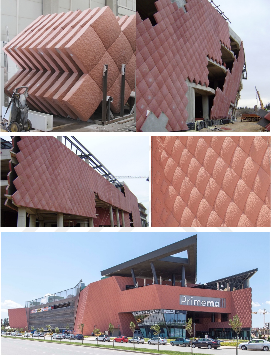
Şekil 7.12. GRC-CTB kendinden yalıtımlı tekstürlü panel uygulaması (Fotoğraf Cemal Emden).
