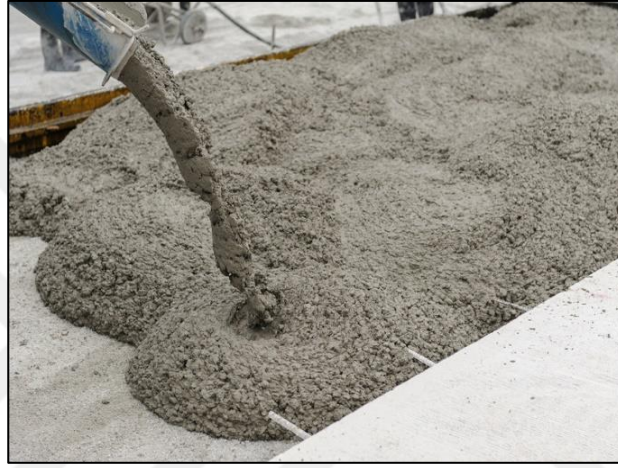
Şekil 2.11: Taze betonun dökülmesi [Web 3]
