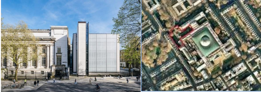
Şekil 1.17: British Museum World Conservation and Exhibitions Centre _ Müze modern ek binası (Sağda kırmızı ile işaretlenen alan).
