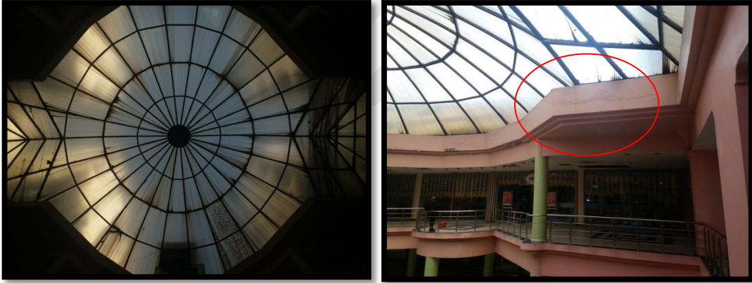
Şekil 4.25. Diyar Galeria AVM çatısı
