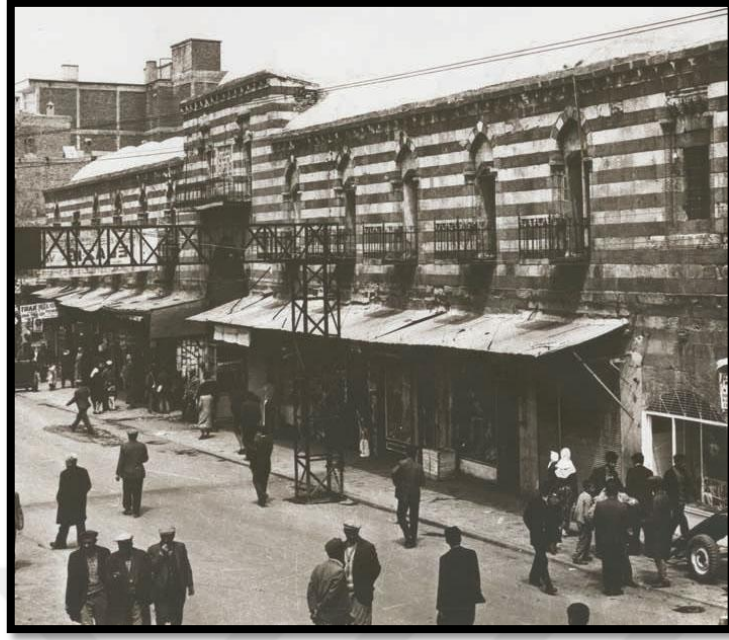
Şekil 4.3. Hasan Paşa Hanı (www.diyarbakir.bel.tr)
