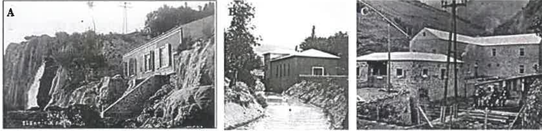
Şekil 4. 19. (a) Antalya Elektrik Fabrikası, (b) Malatya Elektrik Fabrikası, (c) Trabzon Elektrik Fabrikası (Büyükyıldırım 2017, Anonim 2)
