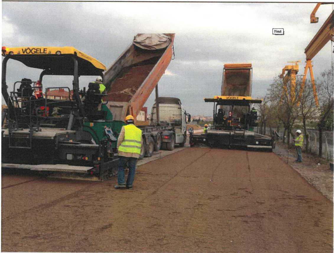
Şekil 2.3. Attemel yapım aşaması ( http://www.osmancamci.com.tr/faaliyetler/kara )
