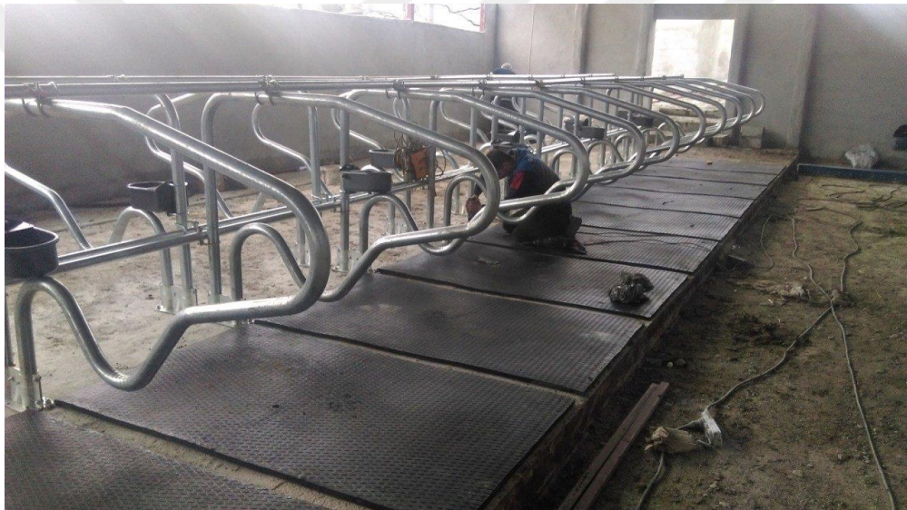
Şekil 2.9. Barınak tabanında lastik kaplama hayvan yatağı kullanımı
