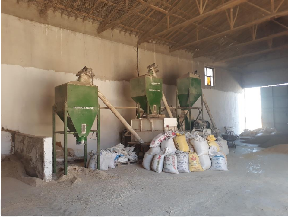
Şekil 4.15. Kesif yemini kendi üreten işletmeye ait yem deposu
