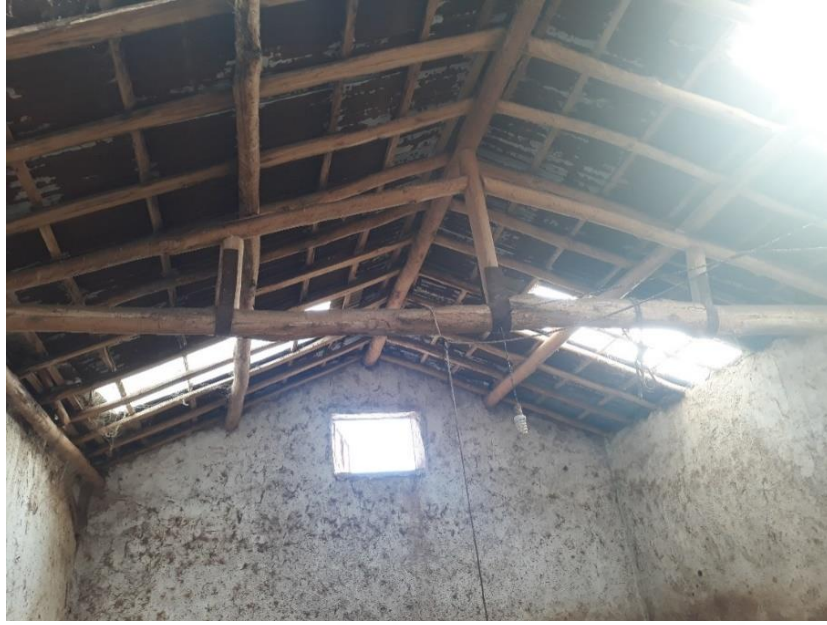
Şekil 4.29. Doğal aydınlatmanın yeterli olduğu bir işletme
