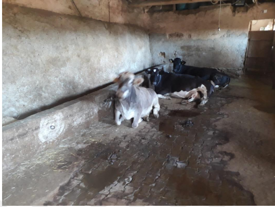
Şekil 4.22. Barınak tabanından parke taşı kullanan bir işletme
