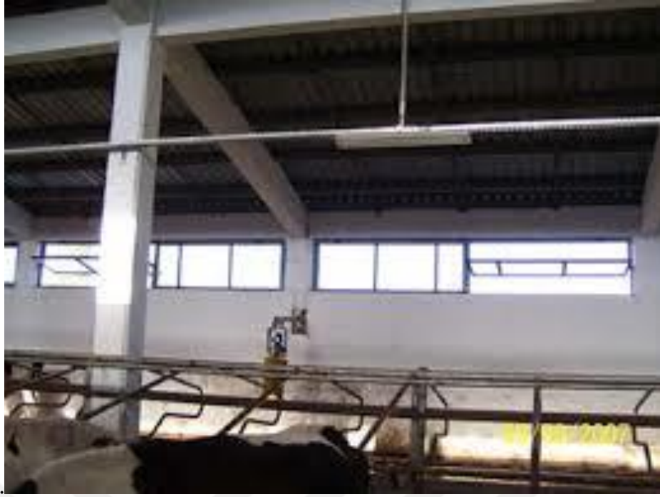
Şekil 2.12. Yan duvarlara, saçak altına yapılmış pencereler yapılmış pencereler (Anonim, 2019e)
