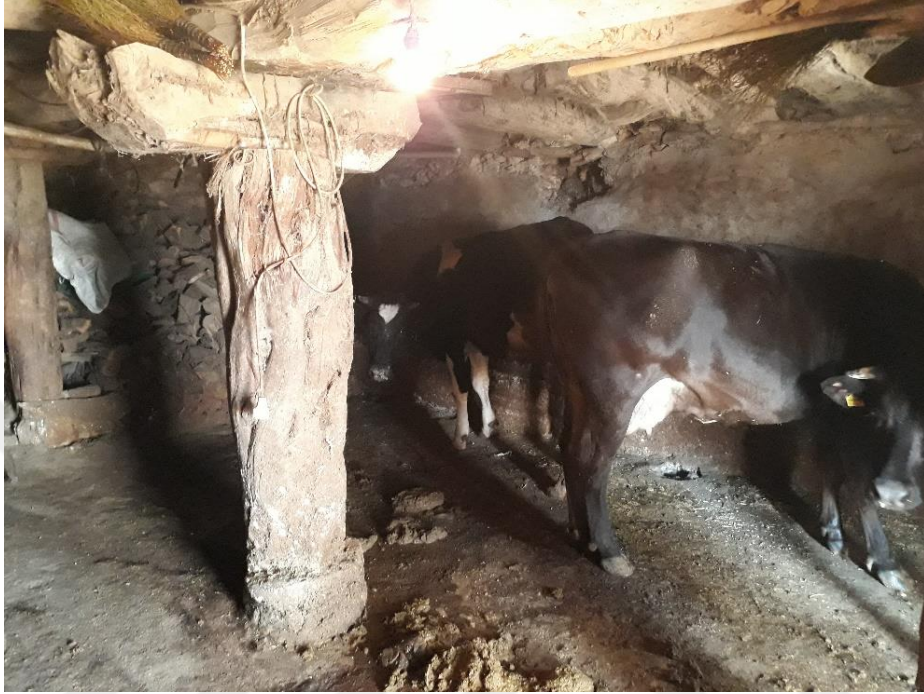
Şekil 4.28. Havalandırma ve doğal aydınlatmanın yetersiz olduğu bir işletme
