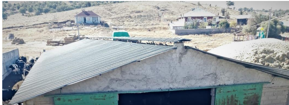
Şekil 4.30. Fener tipi havalandırma kullanan bir işletme
