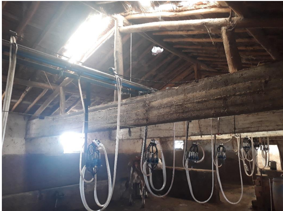
Şekil 4.16. Süt sağım ünitesini barınağın ortasına yerleştiren bir işletme
