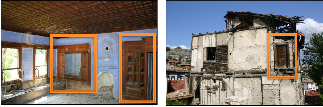
Şekil.108. Yapının Mevcut Halinden Alınıp Onarılarak Kullanılabilecek Elemanlar
