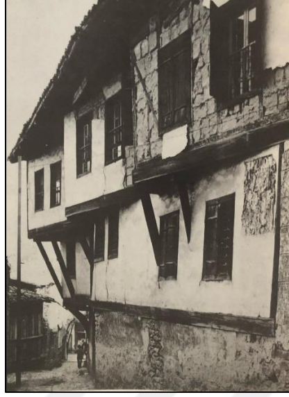
Şekil.38. Kerpicin Kılıcına Örülmesi (Günay, 1989)
