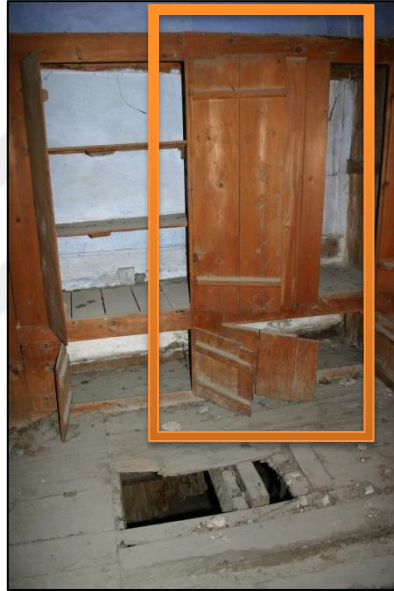
Şekil.109. Yapının Mevcut Halinden Alınıp Onarılarak Kullanılabilecek Elemanlar
