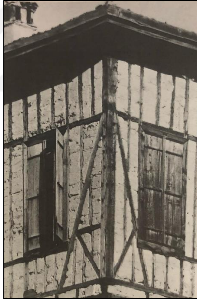
Şekil.39. Ahşap Çatkılar ve Harçla Örülmesi (Günay, 1989)
