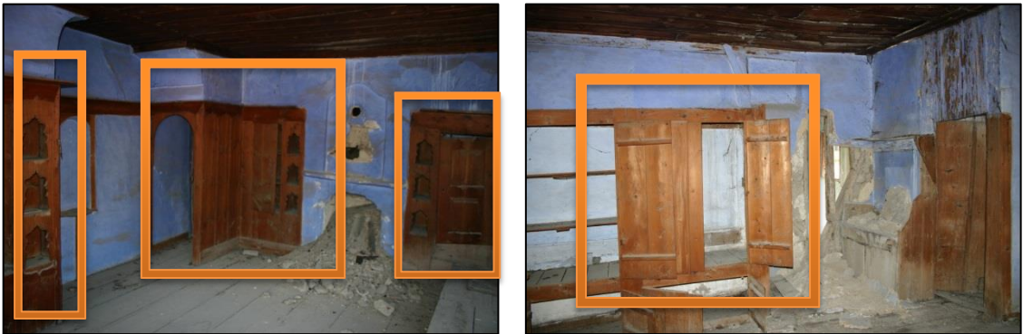
Şekil.107. Yapının Mevcut Halinden Alınıp Onarılarak Kullanılabilecek Elemanlar
