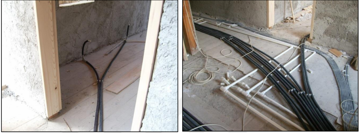
Şekil.114. İnşaat Aşamasından Fotoğraflar
