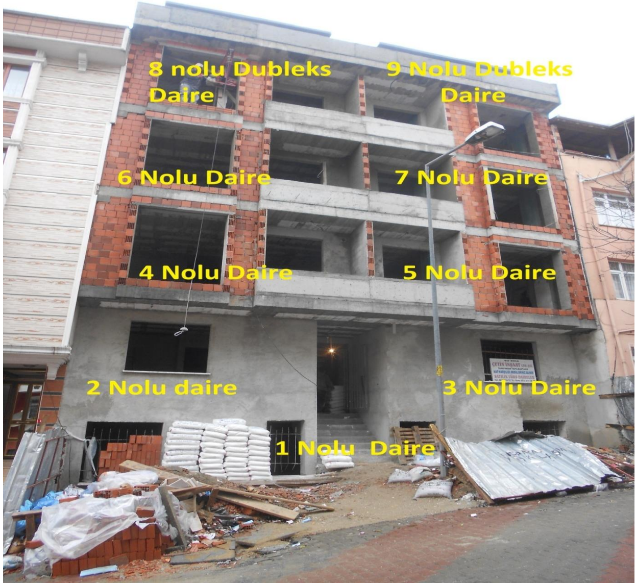
Şekil 8. C Binasının Ön Görünüşü
