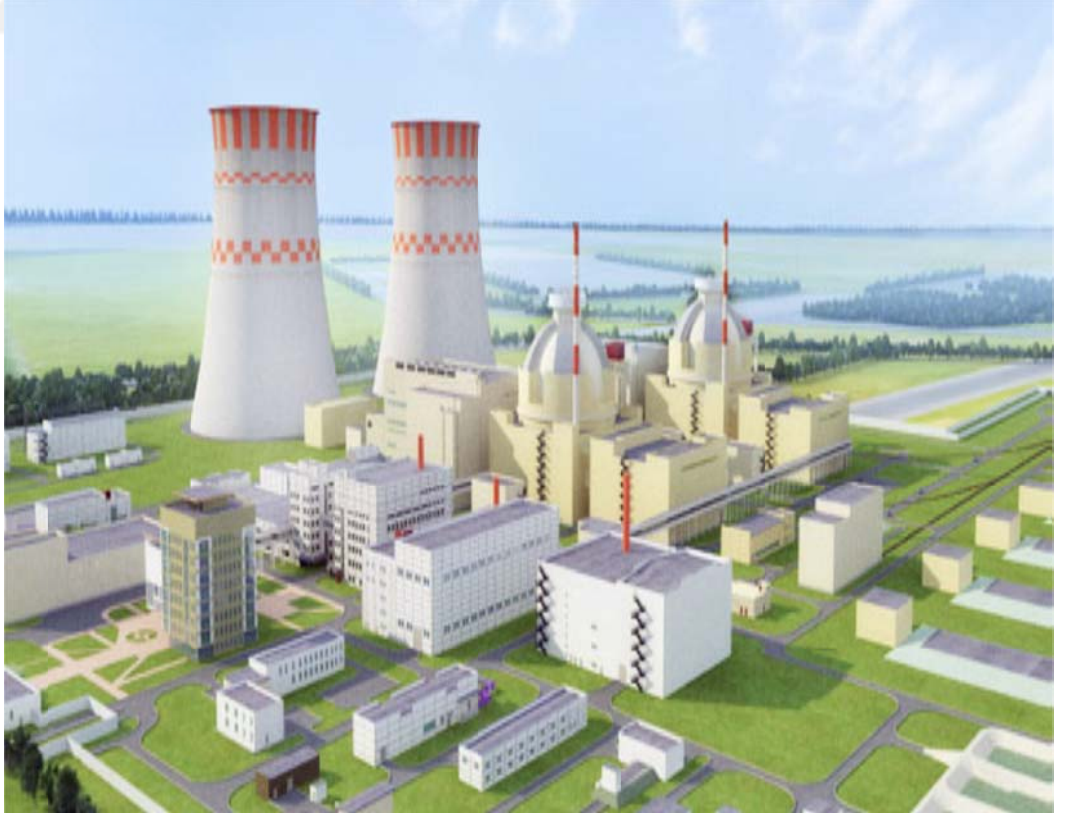
Şekil27: İnşa aşamasında olan VVER-1200 tipi Santrallerin 1 ve 2 nolu nükleer reaktörlerinin tasarım görünümü
