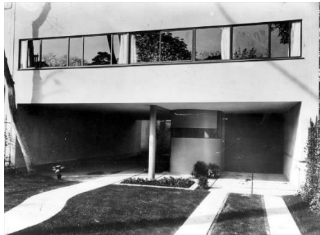
Şekil 3.96 Villa Cook Pilotilerin uygulandığı zemin kat(Foundation Le Corbusier, 2019)
