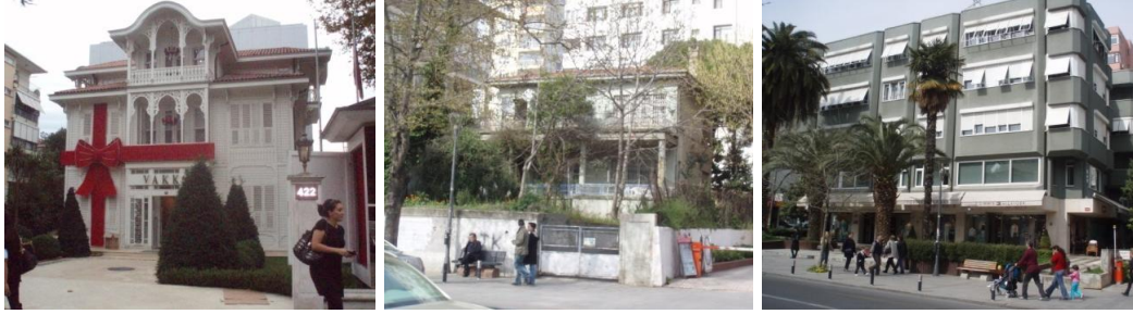
Şekil 4.18 : Sırasıyla cadde üzerindeki dönemsal yapılardan; ahşap köşk, iki katlı yazlık villa ve az katlı apartmanlaşma döneminden örnekler.
