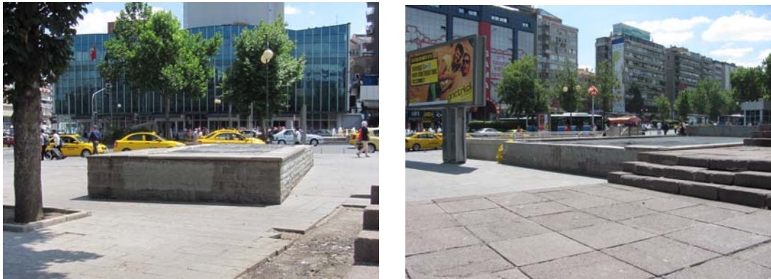
Resim 4.43. Hava bacaları, bozulmuş yer kaplamaları
