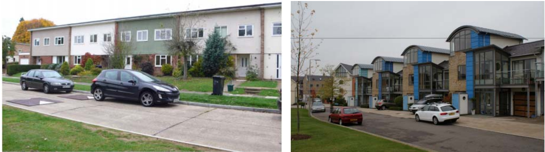
Şekil 46. Harlow' un Kimliğini Yansıtan Renk ve Malzemedeki Özgür Bırakılmış Eski Yapılar ve Benzer Mimari Yapıya Sahip Yeni Konut Alanı Örneği
