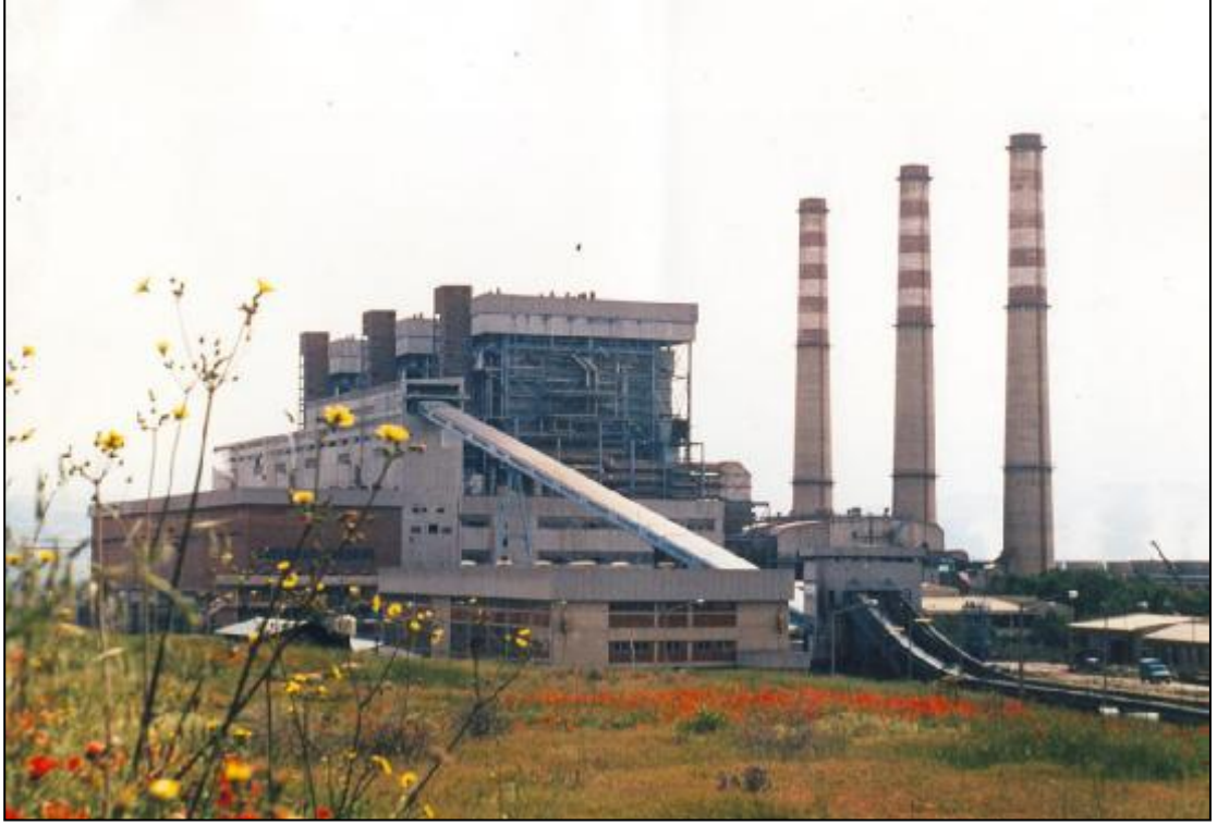
Şekil 2.20: Yatağan termik santrali (KSR, 2009)
