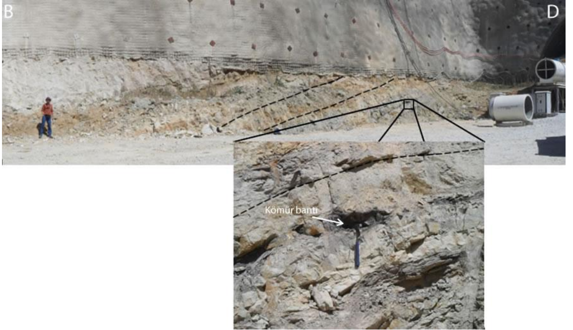
Şekil 4. 16: Bozüyük ilçe merkezi güneyi, İçköy mevki (Hızlı Tren 36 nolu tünel girişi), ÖSK 3 (EK-3) başlangıcı, tabanda killi kireçtaşı ile başlayan birim, kömür seviyesi, çakıltaşı ve kireçtaşı olarak devam etmekte, killi kireçtaşı üzerine kömür seviyesi gelmektedir.
