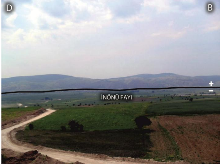
Şekil 4. 51: İnönü ilçe merkezi kuzeyinden İnönü Fayı'nın genel görünümü.
