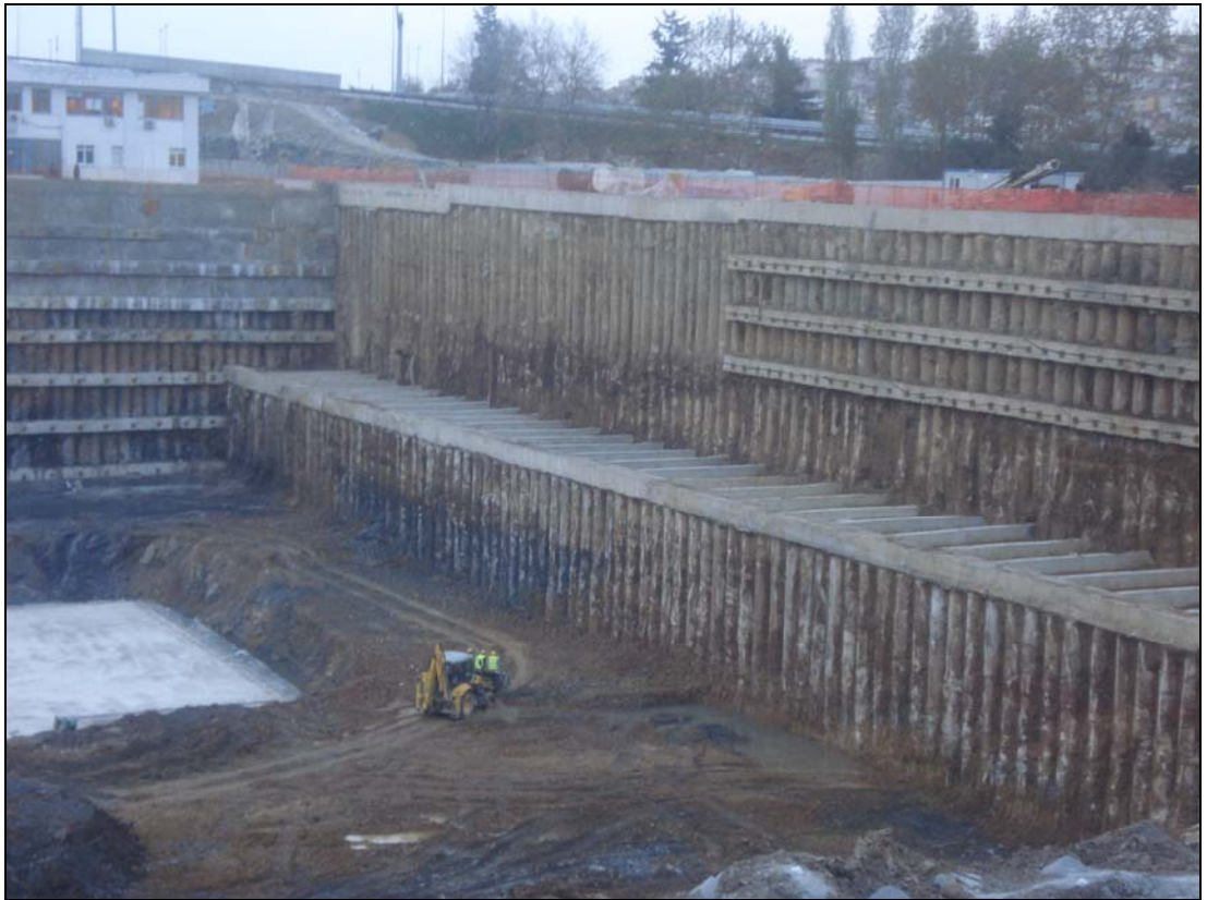
Şekil 5.18 : Güney cephesi kazı taban kotuna ulaşılması.
