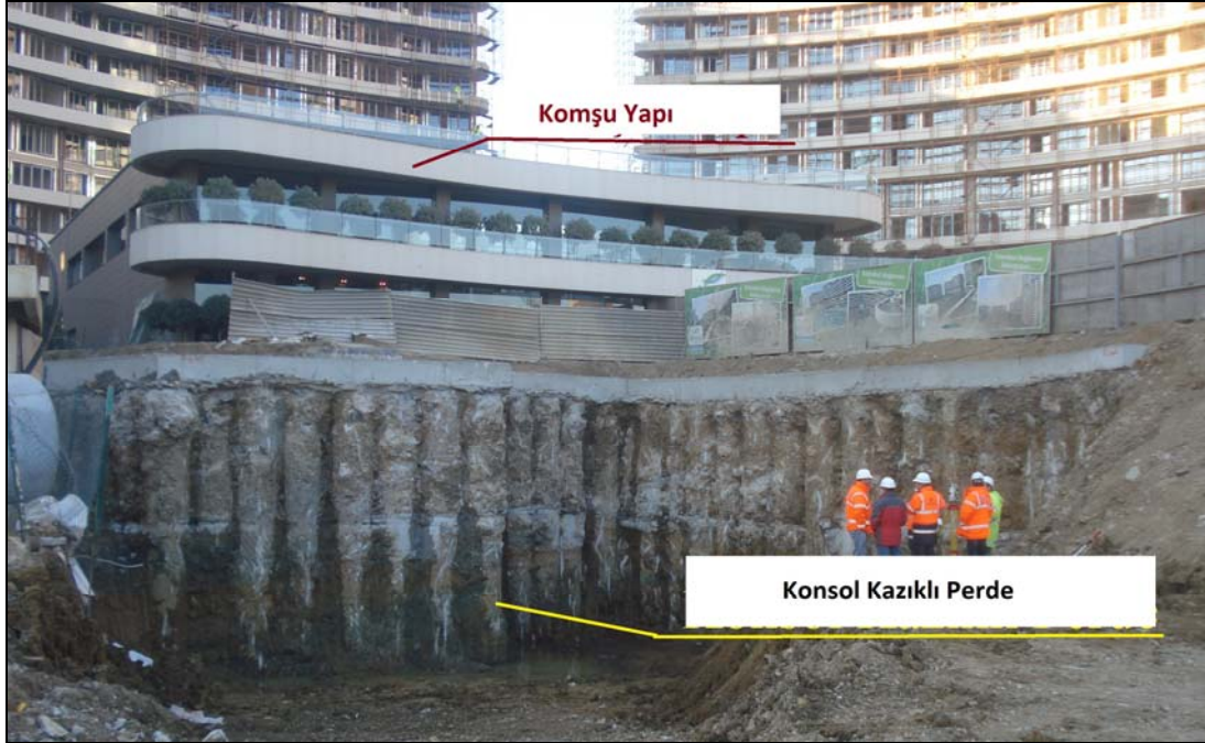
Şekil 2.3 : Konsol iksa perdeleri ile kazı metodu.
