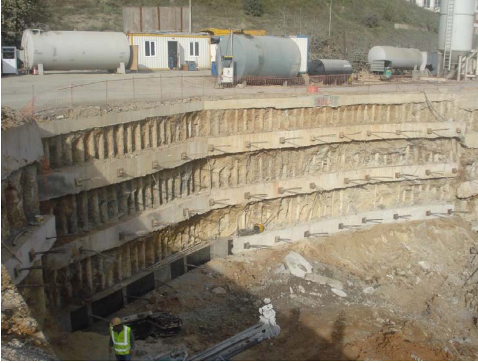
Şekil 4.3 : Mini kazık ve ankrajlı bir iksa sistemi.
