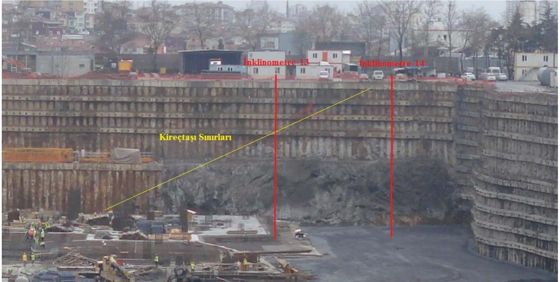
Şekil 5.26 : Metro cephesinde şevli kazının yapılması.
