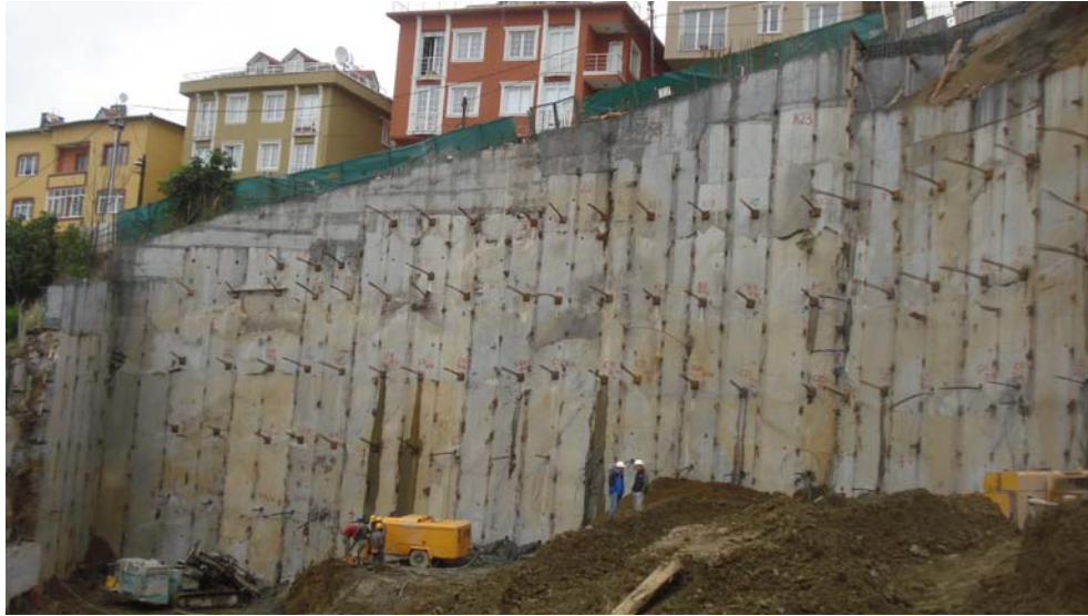
Şekil 4.4 : Kuyu tipi betonarme perdeler ile oluşturulmuş iksa sistemi.
