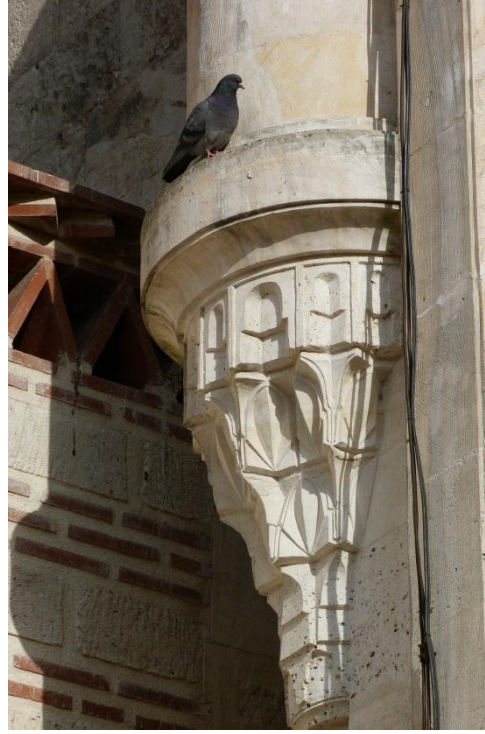
Resim 2.45. Eski Cami duvar üzerinden yükselen minare ayağı.
