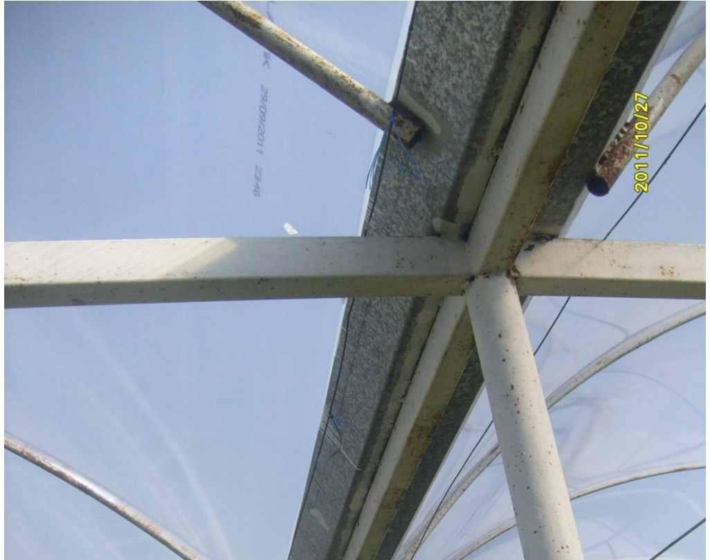
Şekil 4.19. Bir işletmenin yay çatılı borulu yüksek tünel sisteminde kolon-çatı makasının kaynak ile birleştirilmesi (Kuşlubahçe köyü, Merkez)
