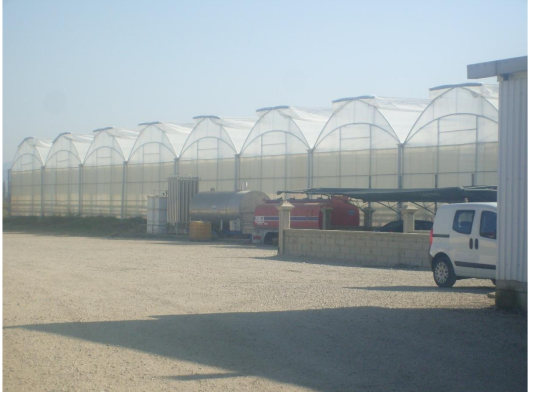
Şekil 4.9. Bir işletmeye ait modern sera yapısının dış görünüşü (Hasalan Köyü, Salihli)
