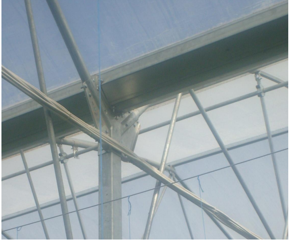
Şekil 4.20. Bir işletmenin gotik çatılı profil sistem serasında bulunanla sağlanan kolon-çatı makası bağlantısı (Hasalan köyü, Salihli)
