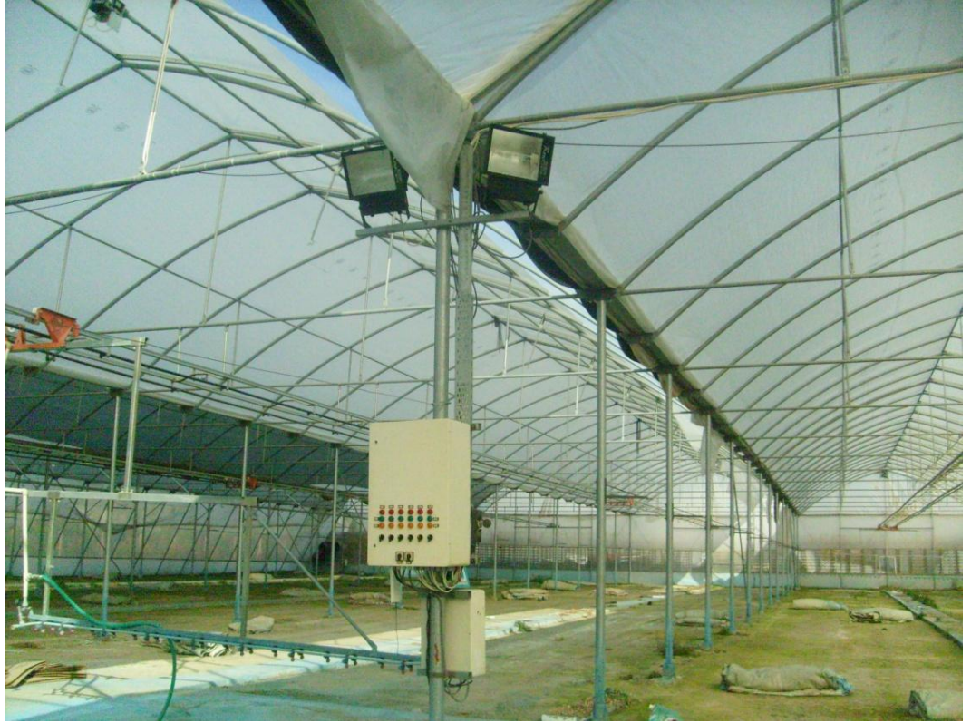
Şekil 4.32. Bir işletmeye ait serada halojen lambalarla aydınlatma (Akselendi Köyü, Akhisar)
