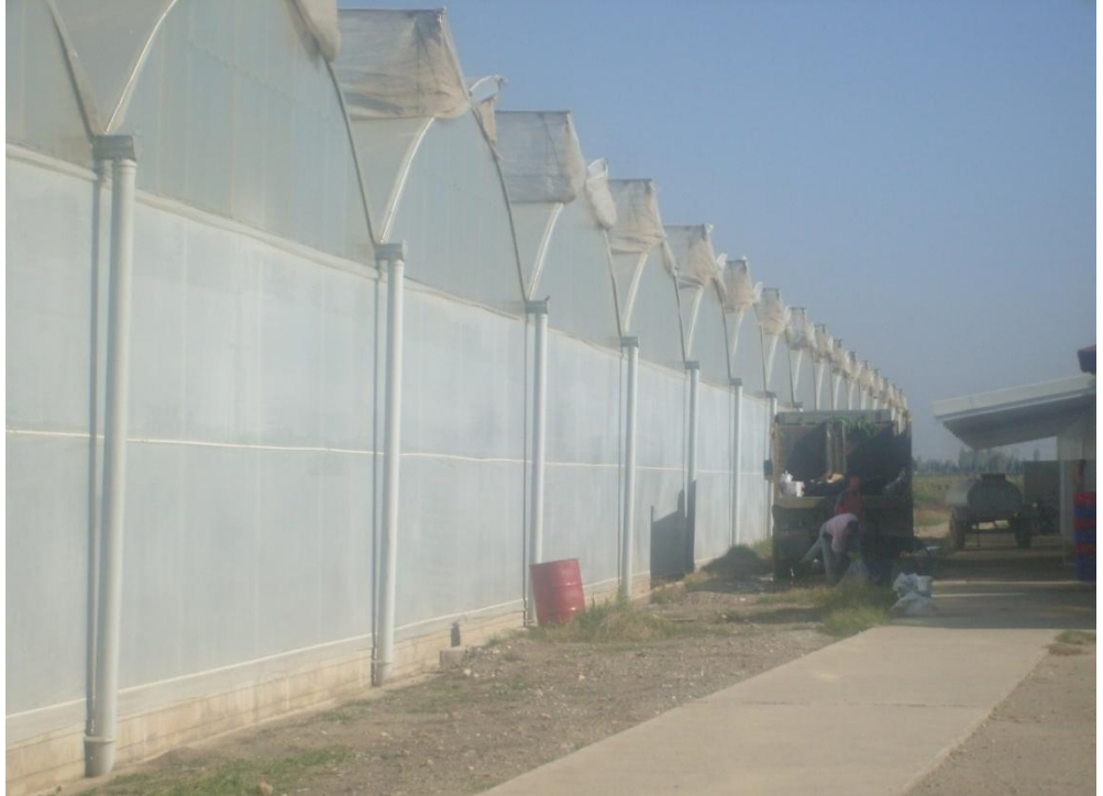
Şekil 4.21. Ticari tip bir işletmede yan yüzeyde sert plastik (PVC) ve çatıda PE (katkılı) kullanımı (Hasalan Köyü, Salihli).
