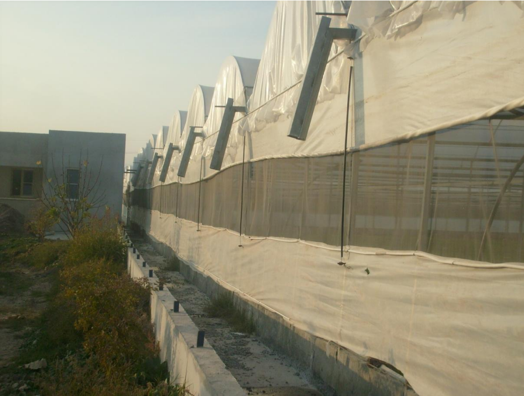
Şekil 4.36. Bir işletmeye ait yüksek tünelin dışında açık drenaj sisteminin görünüşü (Çamönü Köyü, Akhisar)
