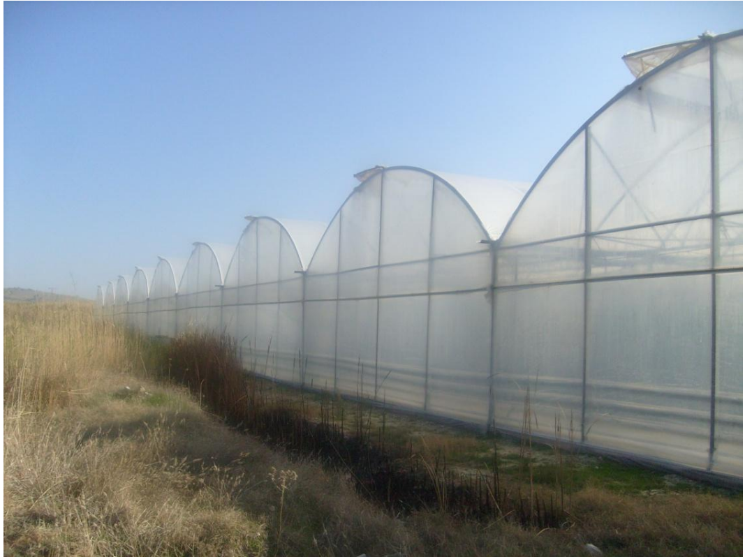
Şekil 4.12. Bir işletmeye ait blok seranın dış görünüşü (Cambazlı Köyü, Ahmetli)
