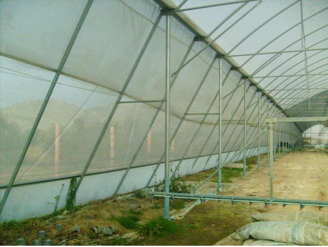
Şekil 4.16. Bir işletmede eğik kenarlı gotik çatılı seranın iç görünüşü (Akselendi köyü, Akhisar)
