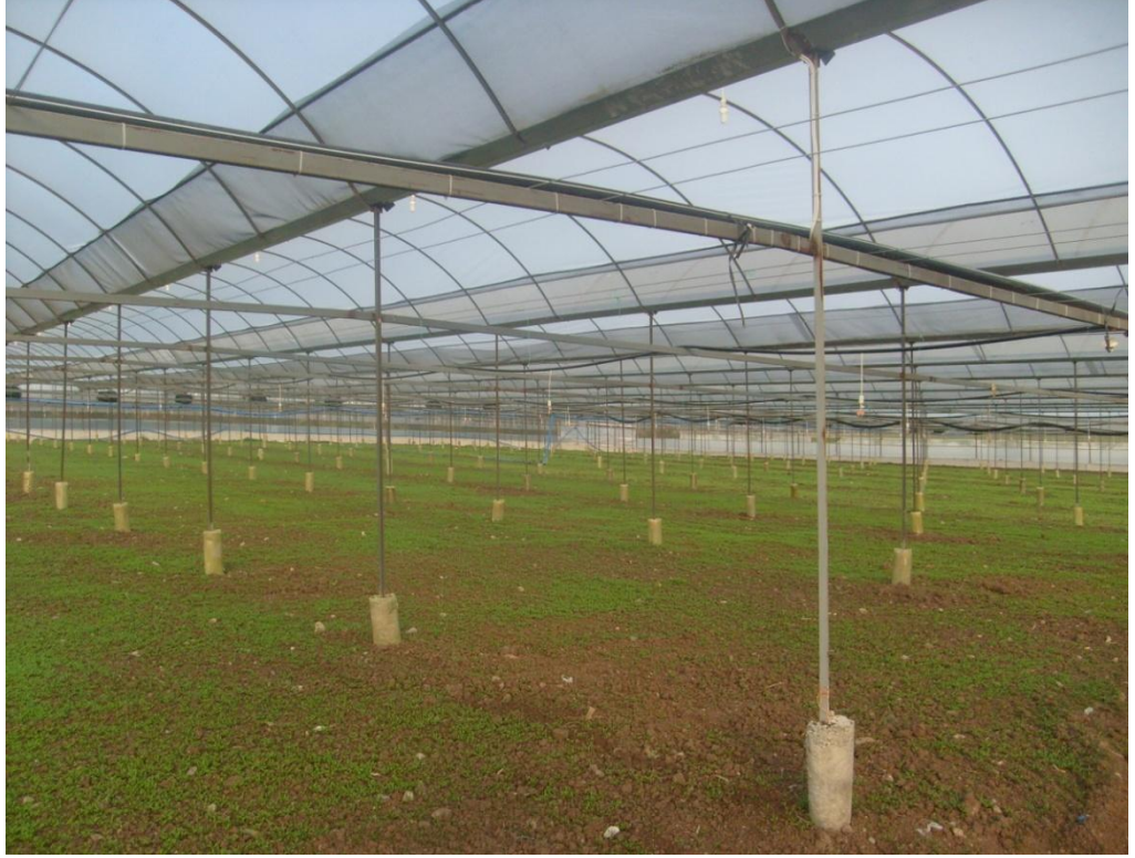
Şekil 4.18. Bir işletmeye ait yüksek tünelin kolon-zemin bağlantısında silindirik beton temelin görünüşü (Çamönü köyü, Akhisar)
