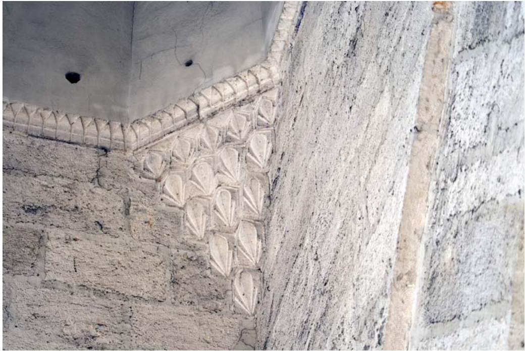
Fotoğraf 38. Konsol Diş Görünümü
