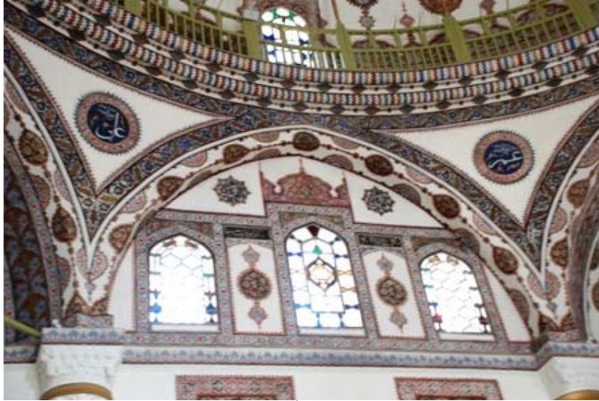
Fotoğraf 90. Nevşehirli Damat İbrahim Paşa Camii Kubbe Eteği
