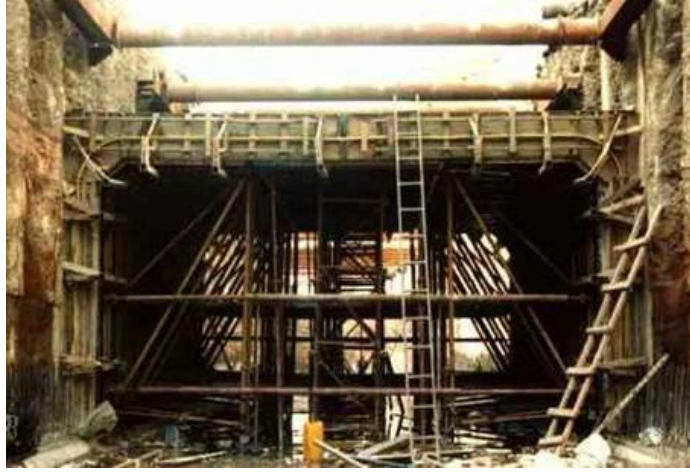
Şekil 4.5 : Aç-Kapa tünel çalışmasında tavanın kaplanması.
