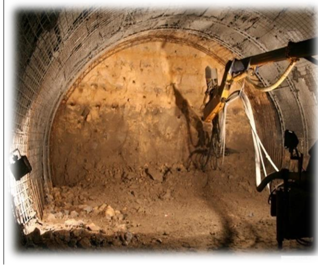
Şekil 4.3 : NATM ile tünel açılması.
