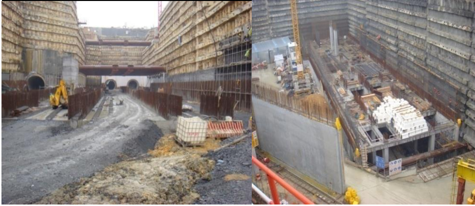
Şekil 4.4 : Kirazlı ve İkitelli İstasyonları aç-kapa tünel çalışması.
