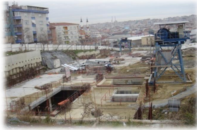
Şekil 4.6 : Otogar-Bağcılar-İkitelli metrosunda Yukardan-Aşağıya Yöntemi.
