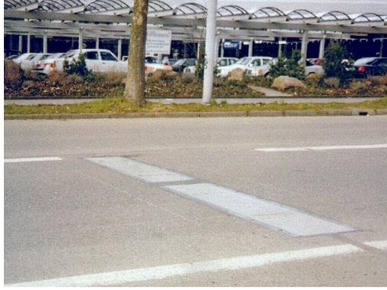
Şekil 2.1 WIM sistemi tartım cihazı ve yük plakası (Zag,2012)
