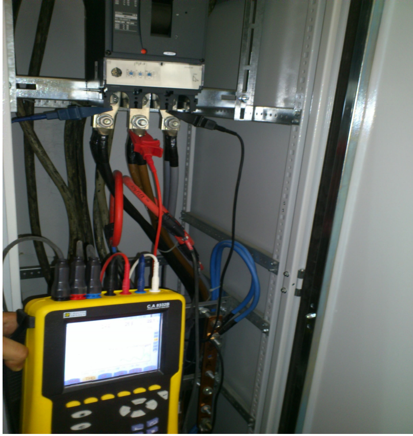
Resim 3.4 Enerji analizörü ile ölçüm yapılması
