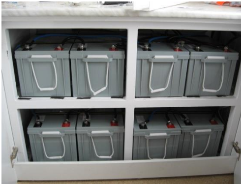
Şekil 2.10 Hibrit güç sisteminde yer alan akü grubu
