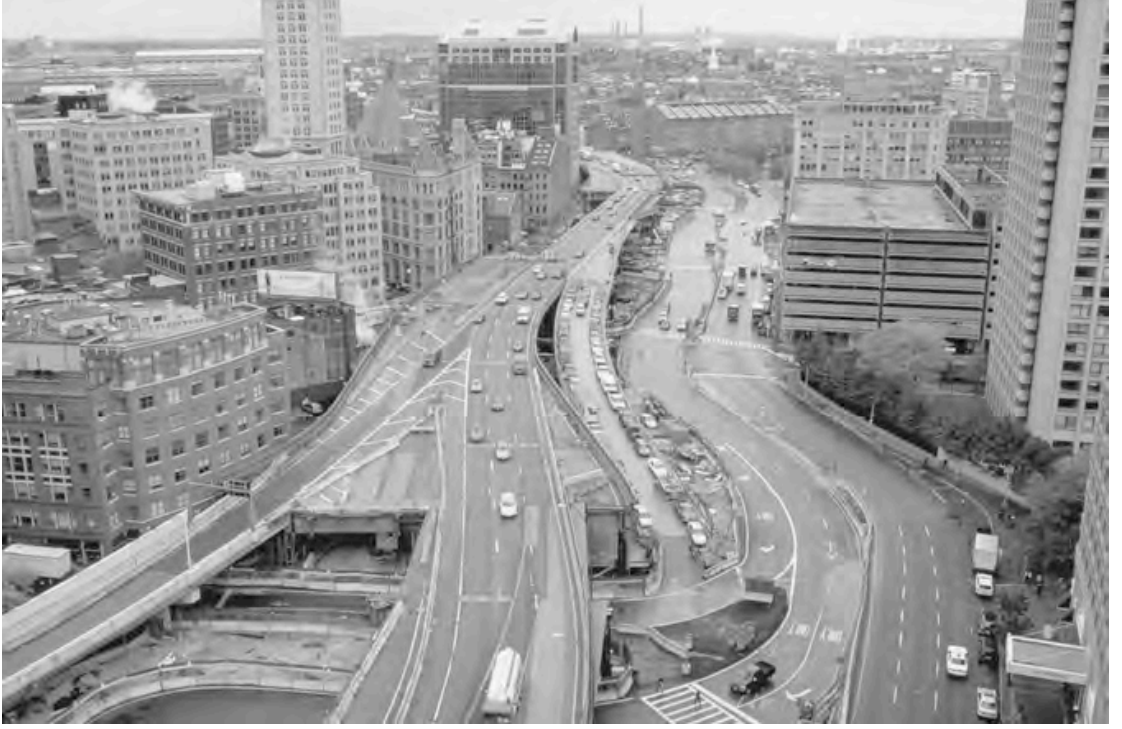
Şekil 4.2 : Büyük Kazı Projesi’nin Yapıldığı Karayolu. (Faga, 2006)
