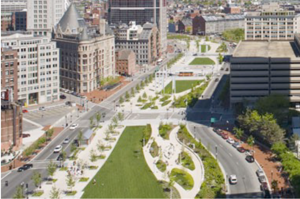
Şekil 4.7 : Projenin Uygulanmasının Ardından Wharf District Parkı. (Faga, 2006)
