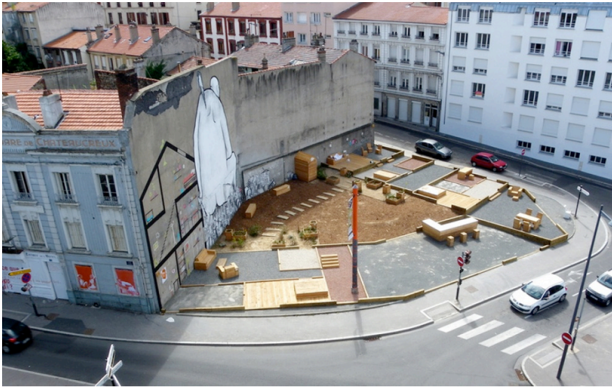
Şekil 4.16 : Meydanın Proje Tamamlandıktan Sonraki Durumu.
