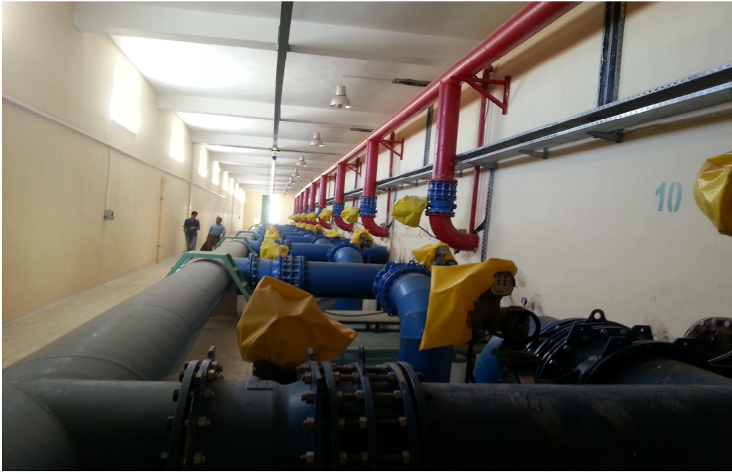
Resim 7. Kum Filtre Basınç Hattı ( Kırmızı Borular) ve Temiz Su Hattı
