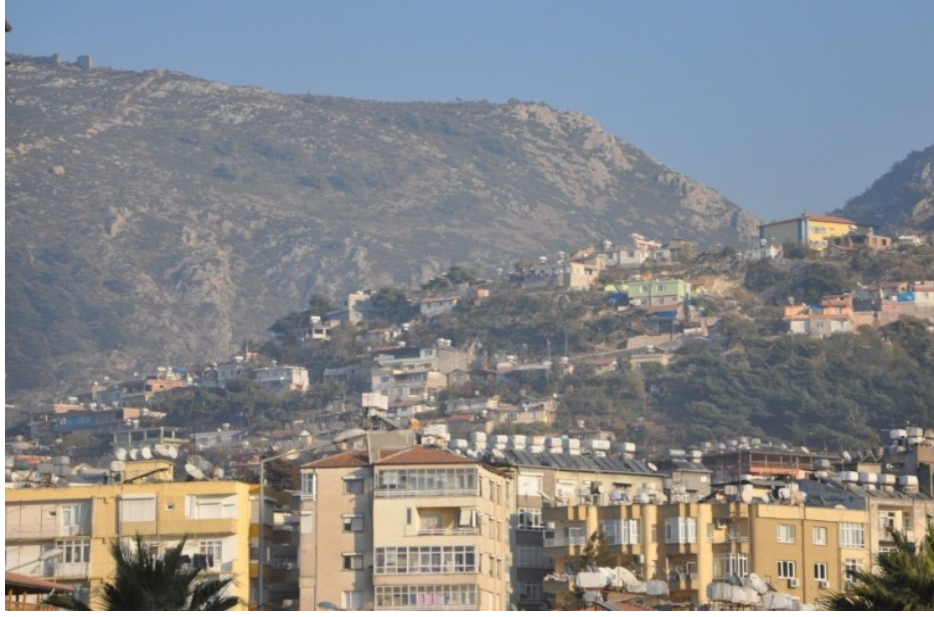
Foto 37. İnceleme alanında Zemin Hareketlerine Duyarlı Mahallelerden Bağrıyanık Mahallesi'nden Görünüş
