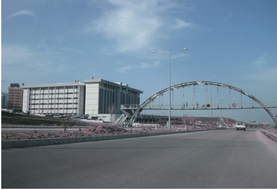
Foto 24. Mucavir Alana Yapılan Adliye Binası
