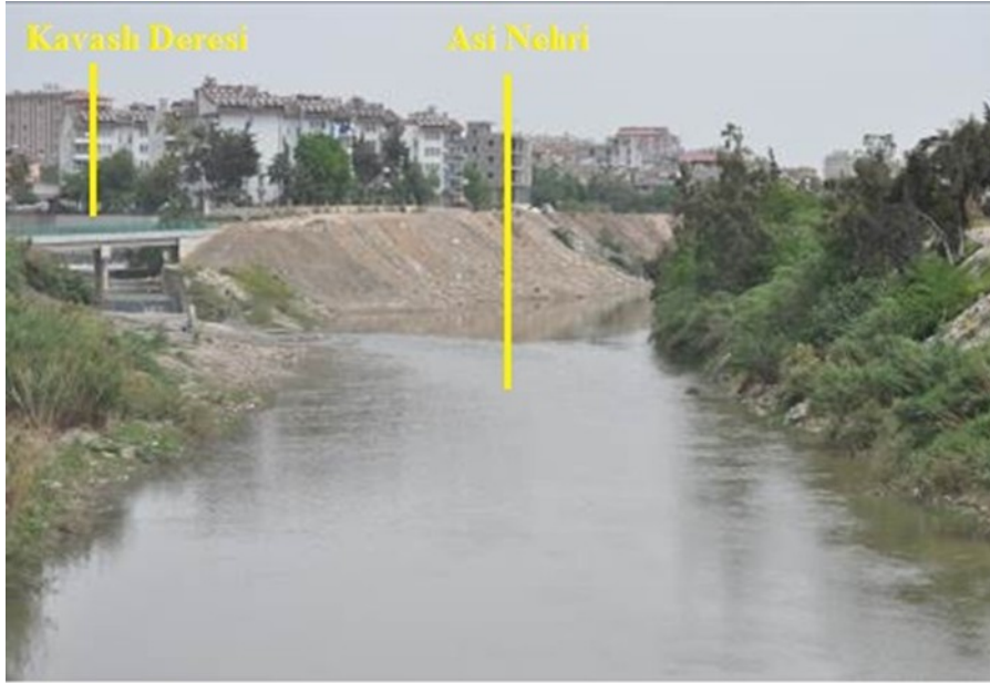
Foto 46. Kavashlı Deresinin Kesitinin Köprü Yapılarak, Asi Nehri'nin Yatak Kesitinin Yol Yapmak Amacıyla Daraltılması
