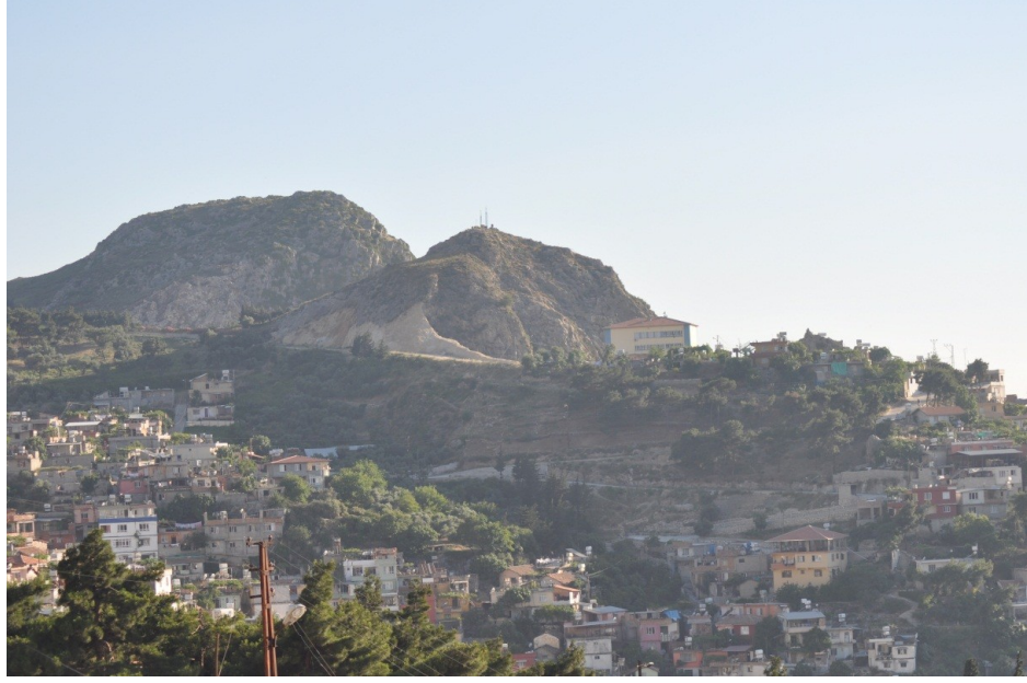
Foto 36. Bağrıyanık Mahallesinde Çeşitli Nedenlerle Yapılan Müdahaleler Sonucunda Zemin Hareketlerine Duyarlı Duruma Getirilen Alanlar
