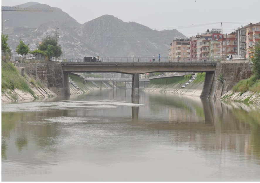
Foto 45. Asi Nehrinin Üstüne Yapılan Köprülerle Yatak Kesitinin Daraltılması
