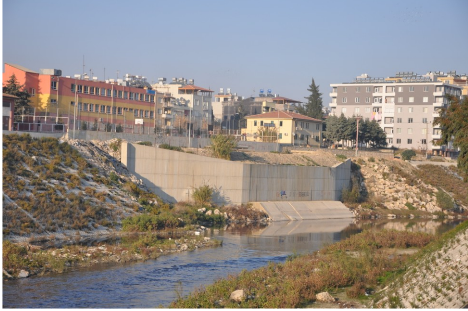
Foto 49. Asi Nehri Kenarına Yol Yapmak Amacıyla Yatak Kesitinin Daraltılması ve Taşkın Yatağına Okul Yapılması (Akdeniz Mahallesi)
