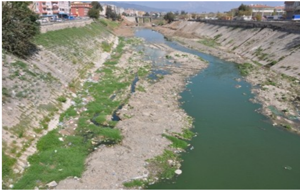
Foto 10. Asi Nehri'nin Akıttığı Su Miktarının Yaz Aylarındaki Durumu (Kanatlı Mahallesi)
