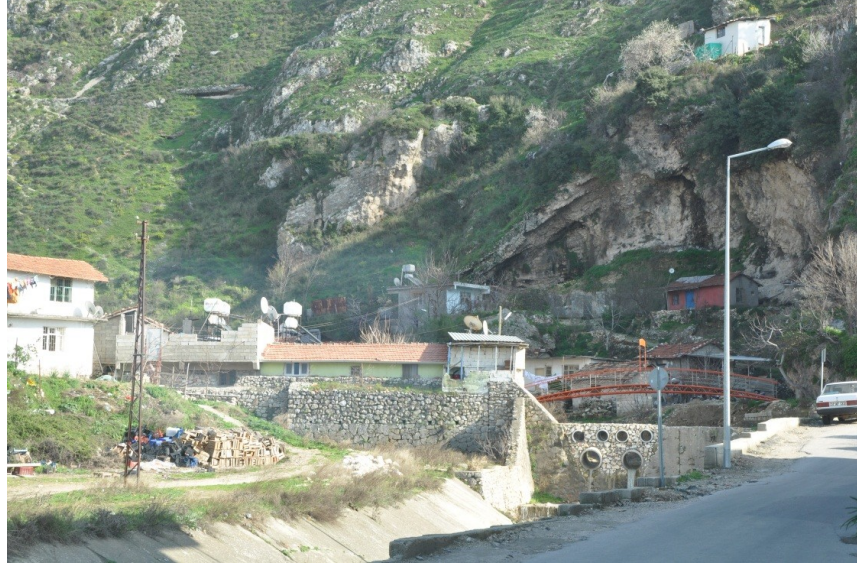
Foto 28. Hacı Kuriş Deresi Tarafından Taşınan Alüvyonların Asi Nehri Yatağına Taşınmaması İçin DSI Tarafından Yapılan Dehlizler (Hacı Ömer Alpagut Mahallesi)
