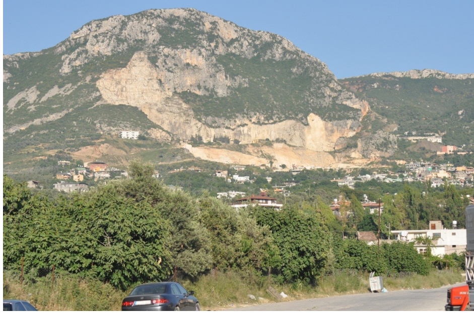
Foto 35. Aşağı Okçular Mahallesiinde Yamaç Eğiminin Bozulması Sonucu Oluşan Zemin Hareketine Duyarlı Alanlar.
