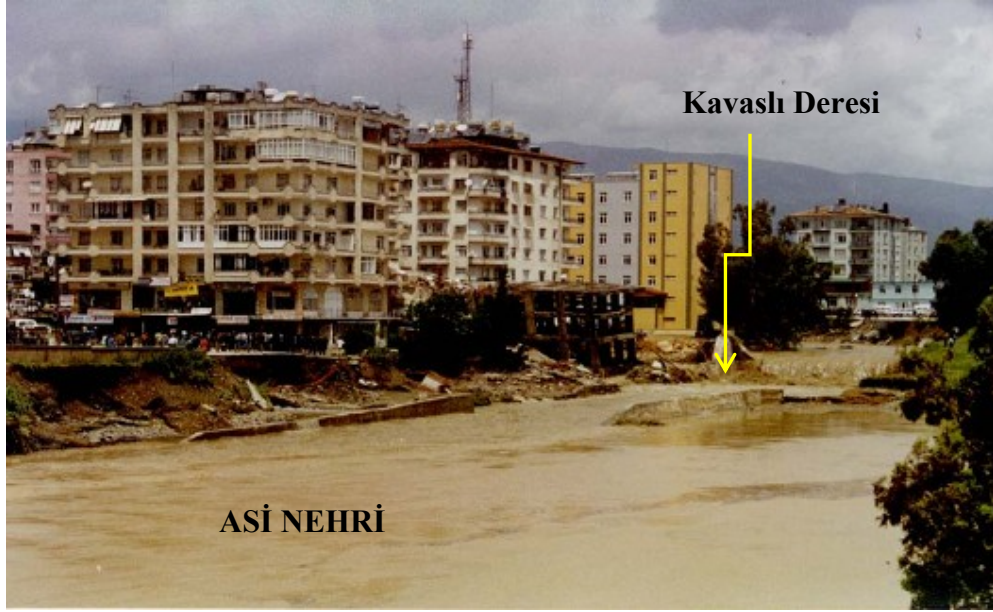
Foto 52. 09.05.2001 Tarihli Taşkında Asi Nehri ve Kavashli Deresi'nin Birleşme Alanında Yıkılan Bina (DSİ, 2007).
