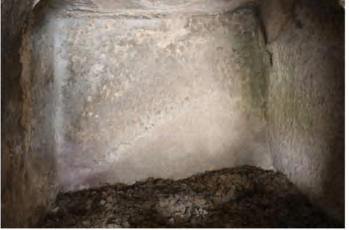
Fotoğraf No 9: Üzüm ezme havuzunun duvarında kalan sıva kalıntısı
