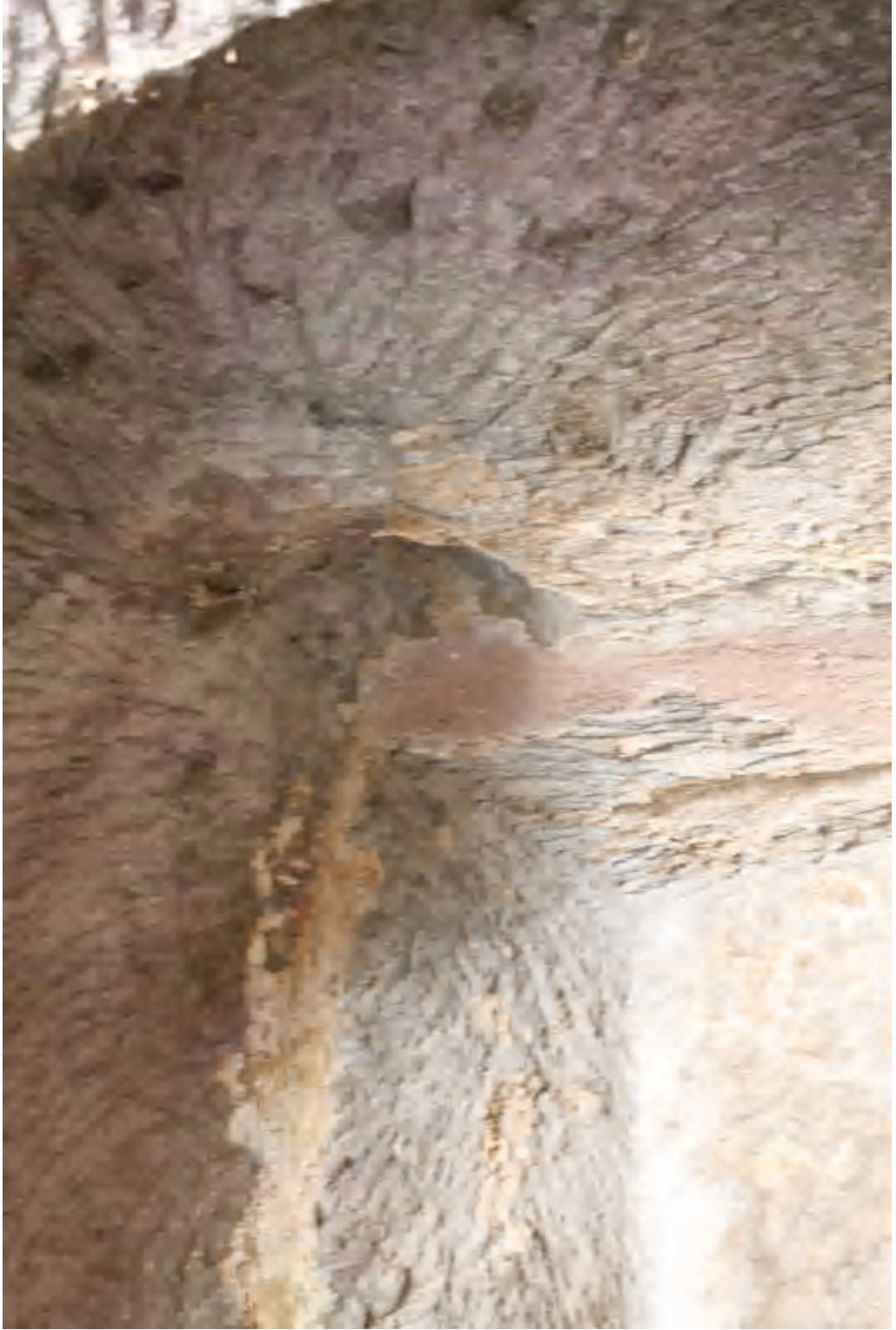
Fotoğraf No 8: Üzüm ezme havuzunun tavanındaki baca
