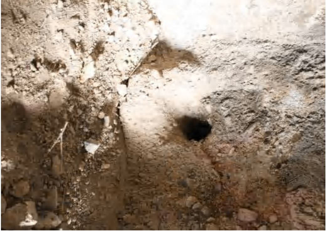
Fotoğraf No 36: Şıra Akıtma Kanalı
