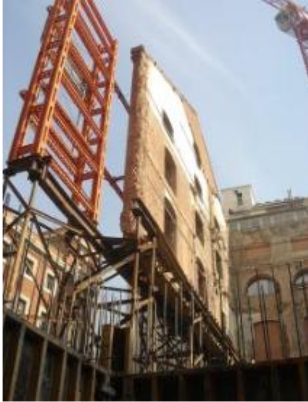
Resim 7.26. Bina yapım aşamasından detay [90].
