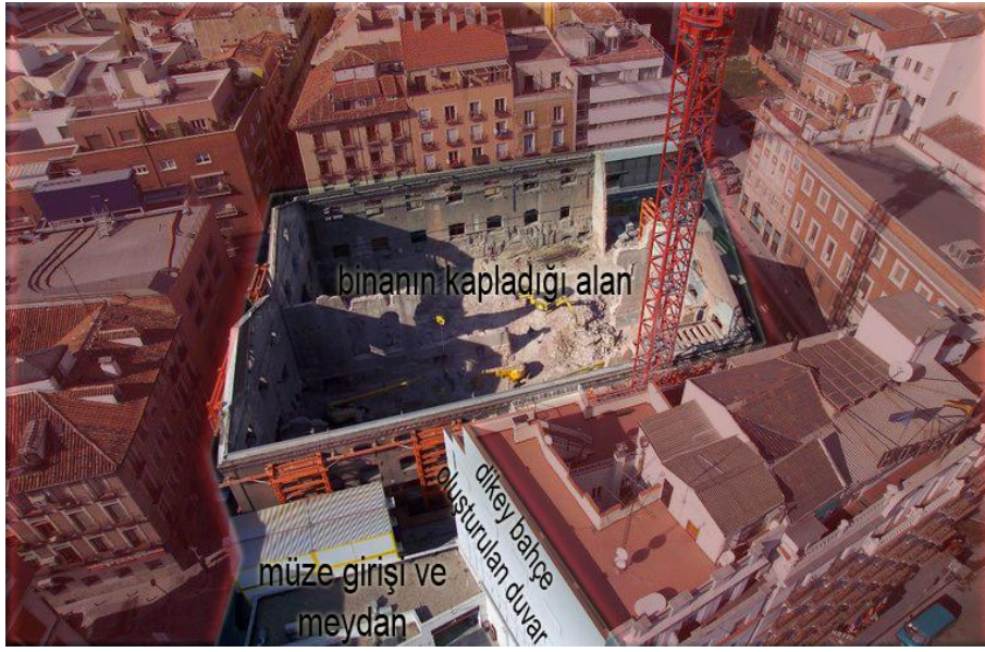
Resim 7.25. Bina yapım aşamasından genel bir fotoğraf [90].
