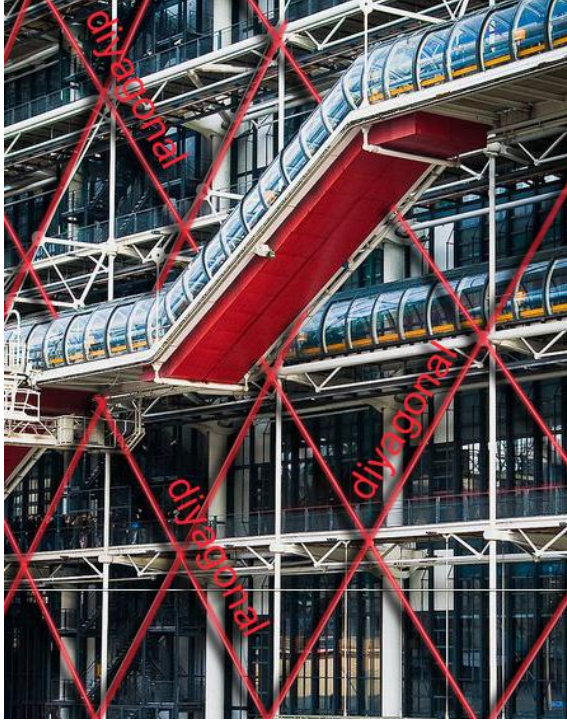
Şekil 6.9. Diyagonal çelik bağlantılar [49].
