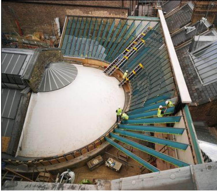
Resim 4.39. Daylight Galeri çatı yapım aşaması ve detayı [55].
