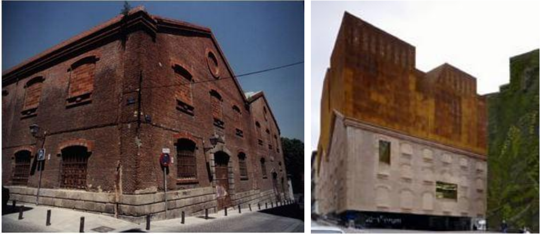
Resim 7.17. Elektrik istasyonu eski ve yeni hali [86].
