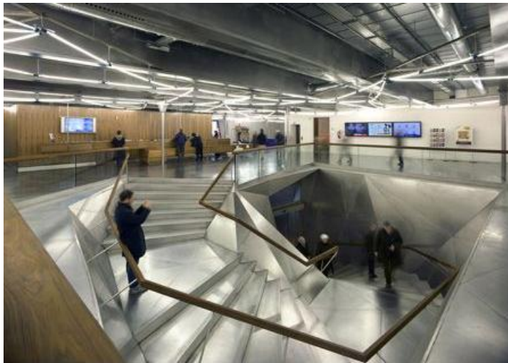
Resim 7.21. Üçgen metal parçalardan oluşan merdiven [87].
