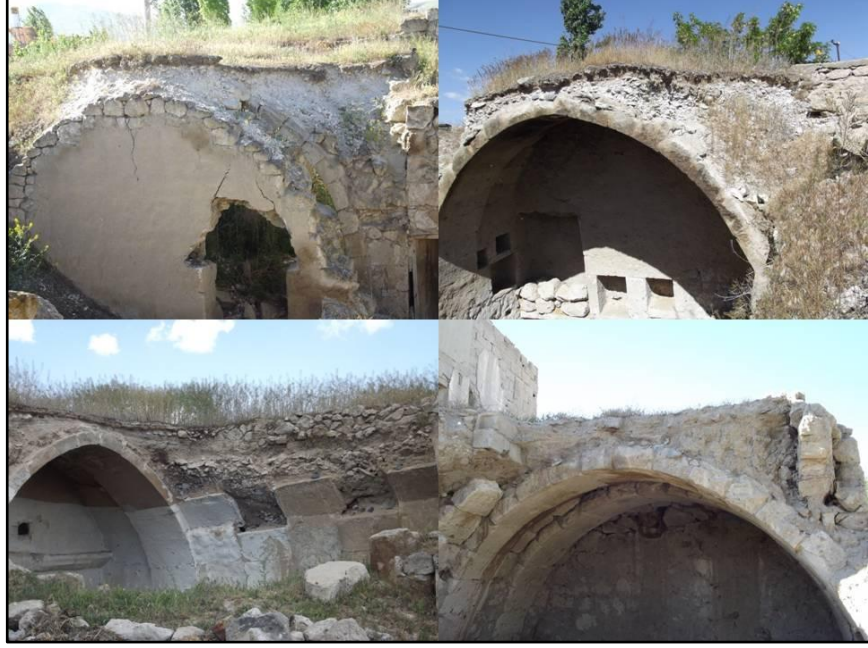
Fotoğraf 4.30. Üzeri Toprak Örtülü Taş Kemer Çatılı Meskenler
