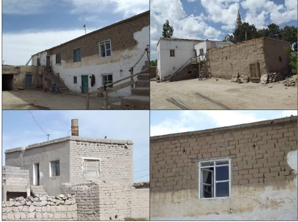
Fotoğraf 4.69. Kerpiç Meskenlerden Görünümler.
