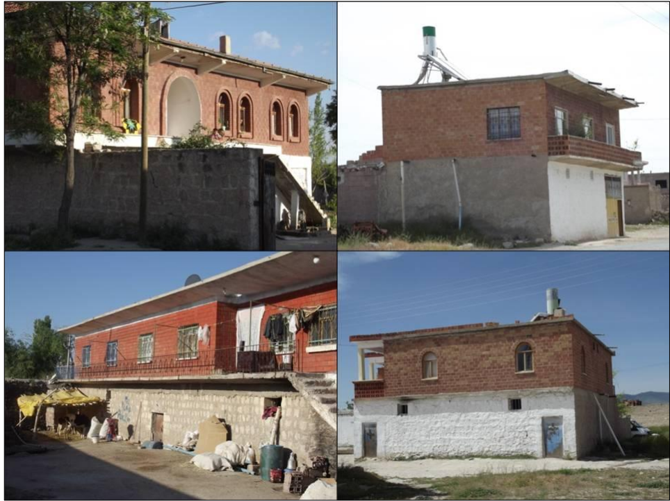
Fotoğraf 4.74. Tuğla Meskenlerden Görünümler.
