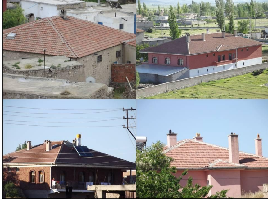
Fotoğraf 4.27. Kiremit Çatı Örtülü Meskenlerden Görünümler.
