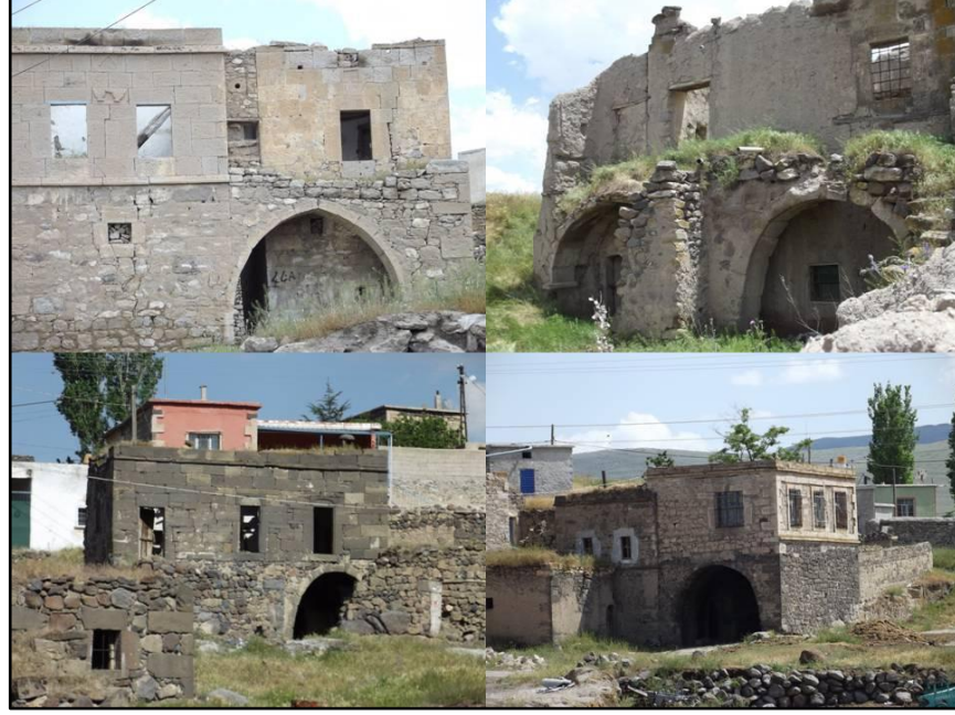
Fotoğraf 4.31. Zemin Katı Taş Kemerli Yapılan Meskenler
