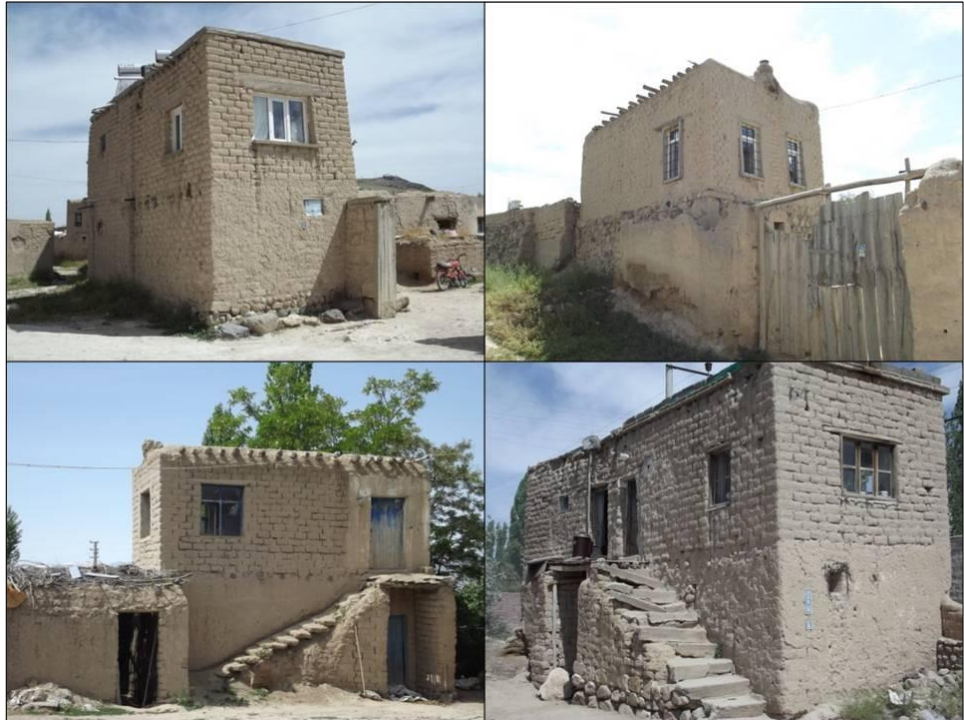
Fotoğraf 4.70. İki Katlı Kerpiç Meskenlerden Görünümler.
