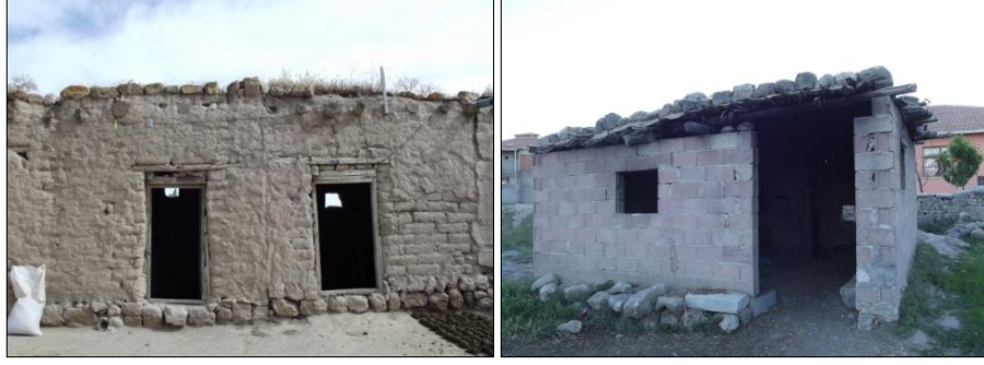
Fotoğraf 4.36. Kerpiç ve Briketten Yapılmış Tandır Evleri.
