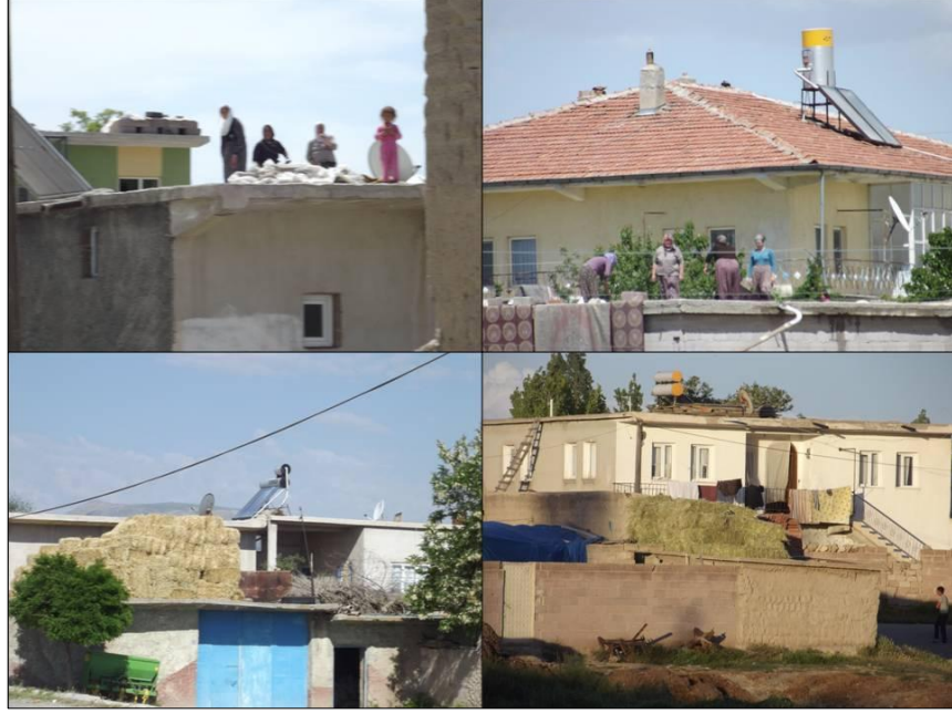
Fotoğraf 4.26. Çeşitli İşleve Sahip Beton Çatılı Meskenler.
