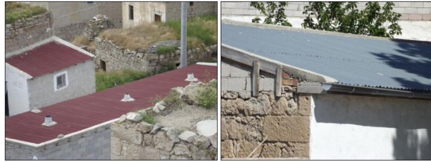
Fotoğraf 4.28. Sac Çatı Örtülü Meskenlerden Görünümler.
