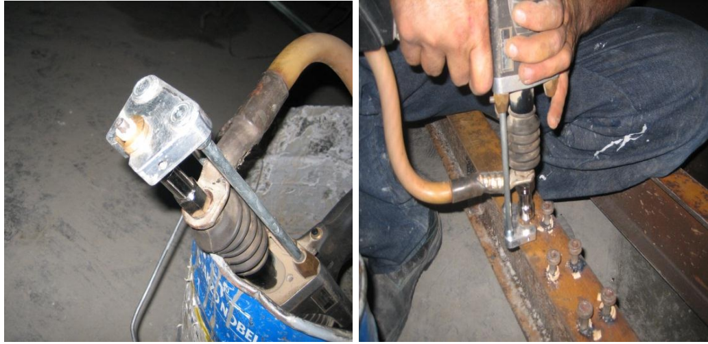
Şekil 4.12 : Saplamaların tabancaya yerleşimi ve kaynaklama işlemi.
