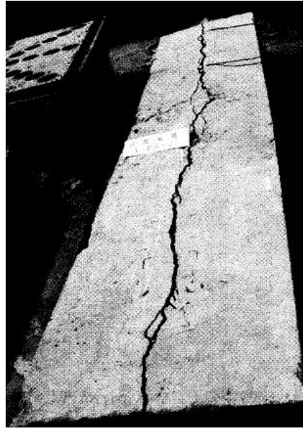
Şekil 2.24 : Statik yükleme deneyinden sonra numunede göçme hasarı (Richard ve diğ., 1997).
