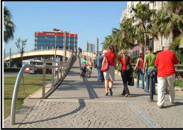
Şekil 2.59 Örnek üst geçit uygulaması (TS 12576, 2012).
