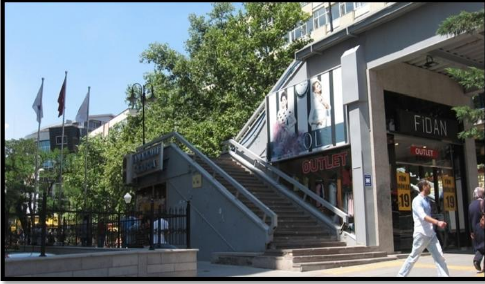
Şekil 6.29 Mevcut üst geçit merdiven altı görünüşü (Özgün, 2013).
