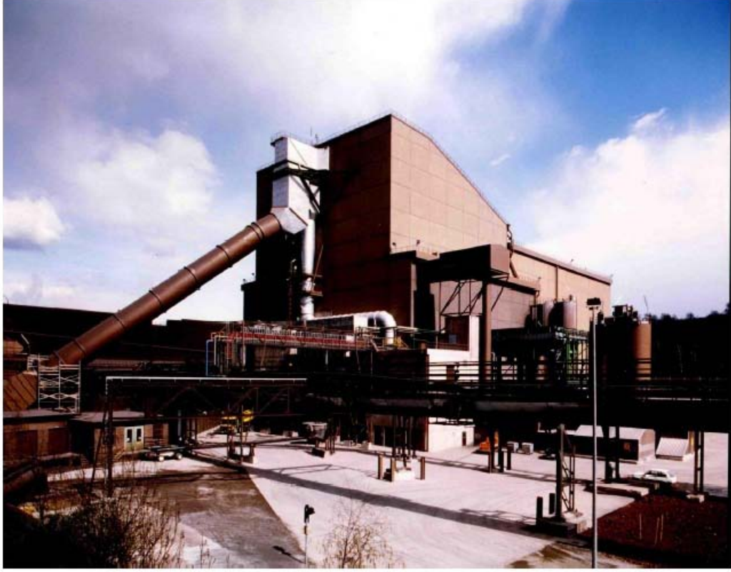
Şekil 4.7 : Elektrik ark fırınlı fabrika.
