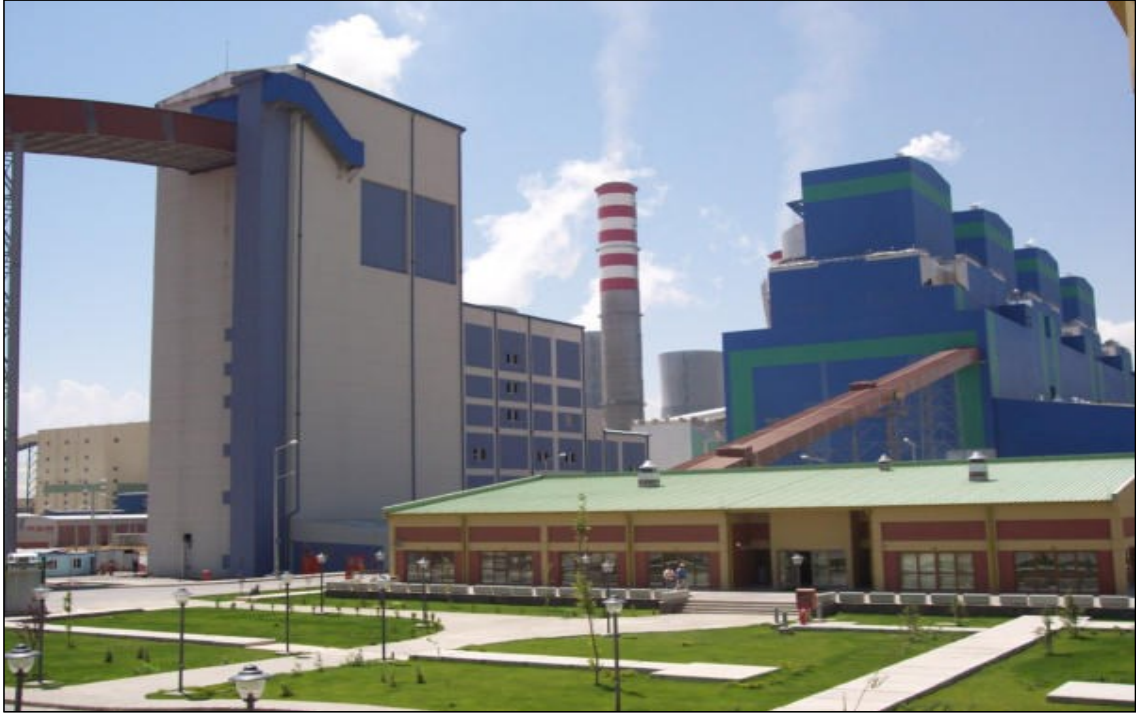
Şekil 3,6 Afşin-Elbistan B-Santralinin Dıştan Görünüşü
