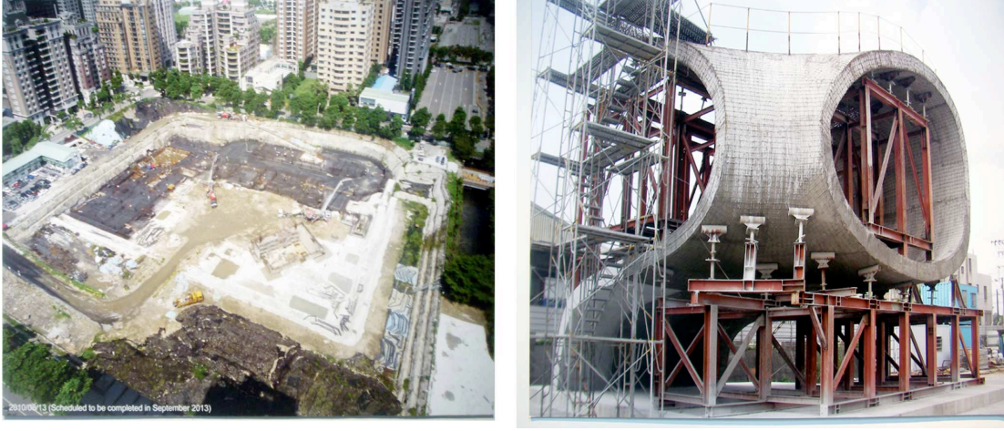
Şekil 4.27. : Şantiye fotoğrafı ve inşa öncesinde üretilen 1/1 ölçekli temsil. Görsel: Funda Uz Sönmez, 2010
