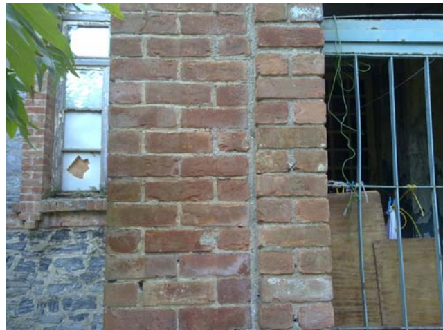
Şekil B.189: Tuđla yzeylerde tuzlanma
