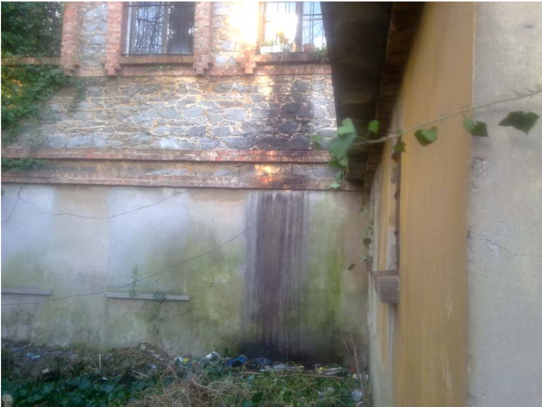
Şekil B.143 : Güney cephesindeki kapatılmış kapı ve pencere
