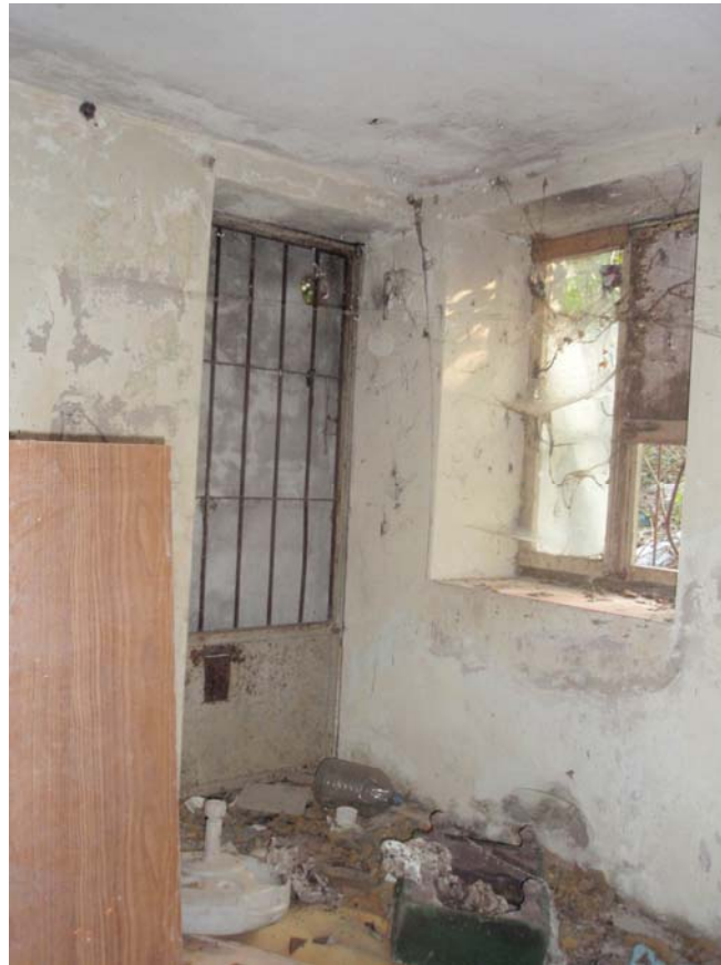
Şekil B.22 : Z04 (Dekor Odası) mekânının doğu duvarındaki kapatılmış kapı
