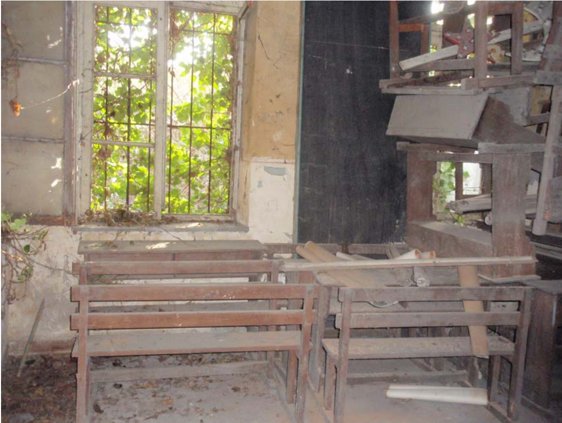
Şekil B.88 : 112 Mekânı (Derslik) güney duvarına bakış.
