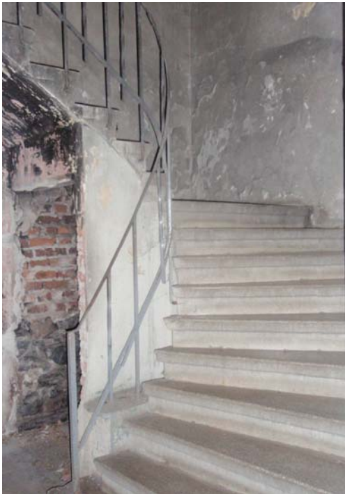
Şekil B.8: Zemin katı birinci kata bağlayan merdiven.
