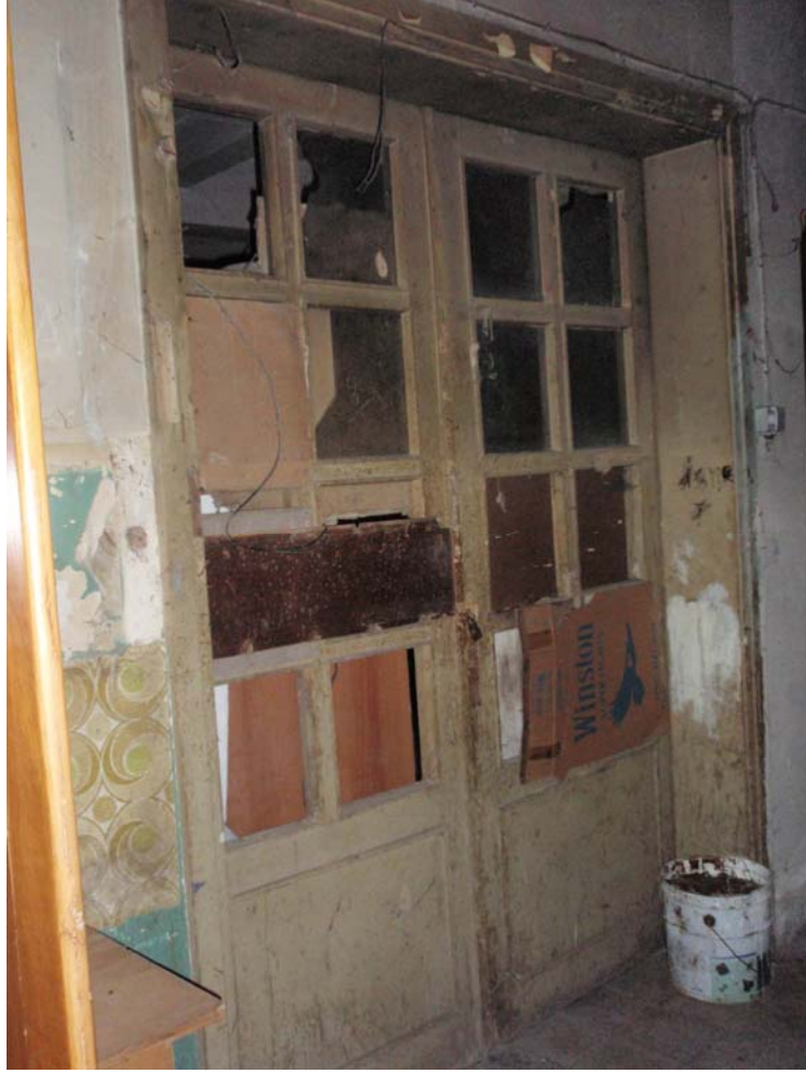
Şekil B.13: Z01 (Hol) mekânının batı duvarındaki kapı
