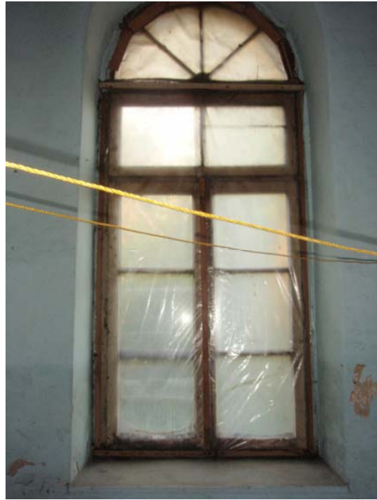
Şekil B.175 : Koruma amaçlı kapatılmış pencere
