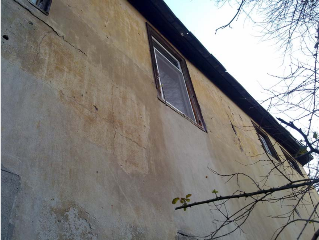
Şekil B.123 : Batı cephesi güney köşesine doğru bakış
