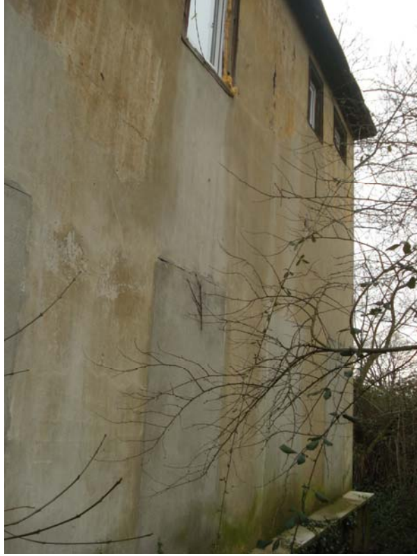
Şekil B.122 : Batı cephesi güney köşesine doğru bakış
