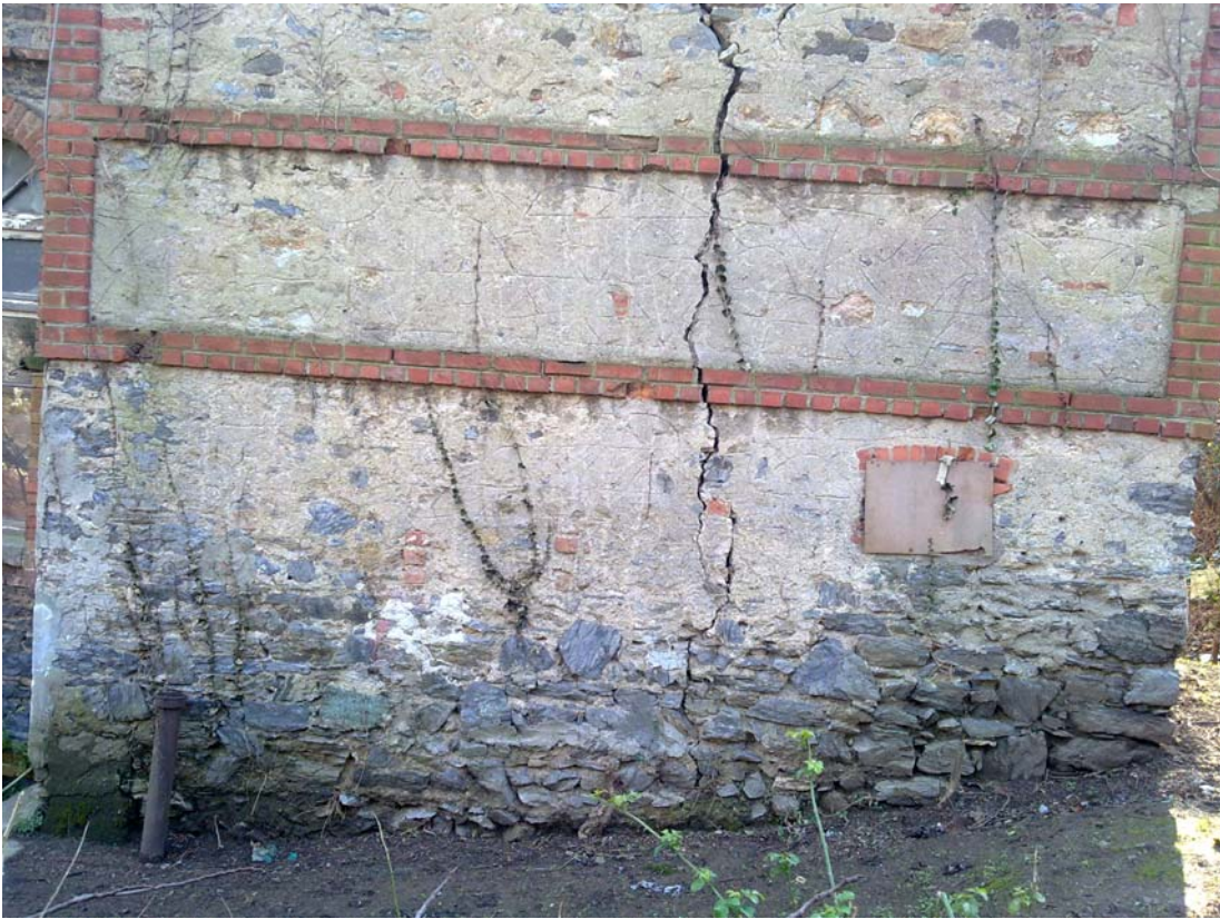
Şekil B.139 : Hizmetli biriminin kuzey cephesi
