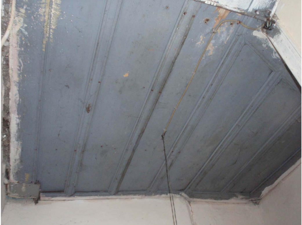
Şekil B.94 : 114 Mekânı (Giriş) ahşap tavan kaplaması
