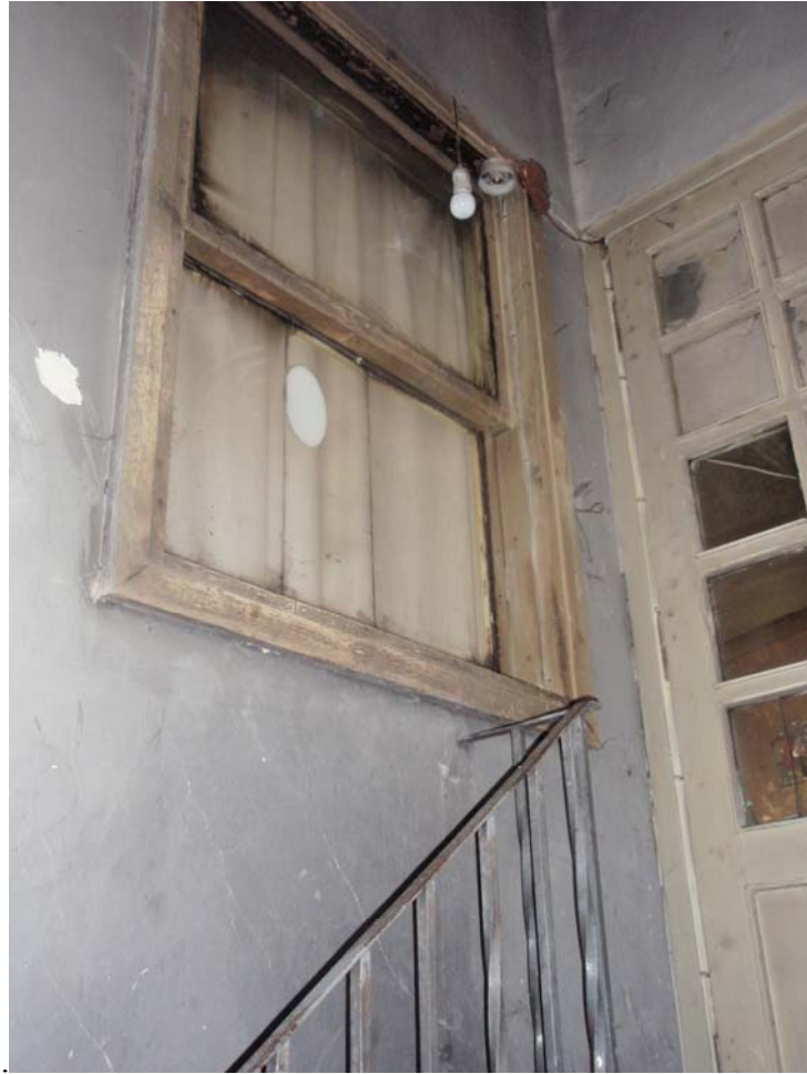
Şekil B.56 : 103 (Hol) mekânından merdiven boşluğuna açılan giyotin pencere
