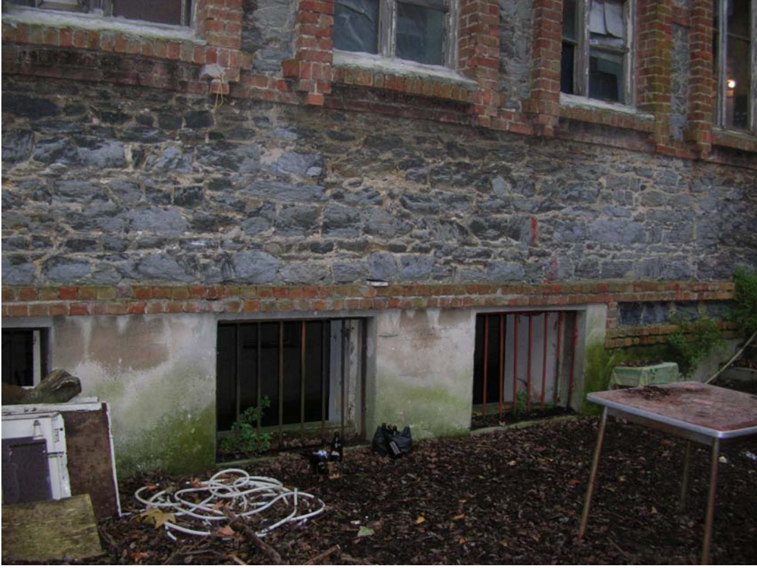
Şekil B.134 : Z02 mekânının kuzey cephesine bakan pencereleri
