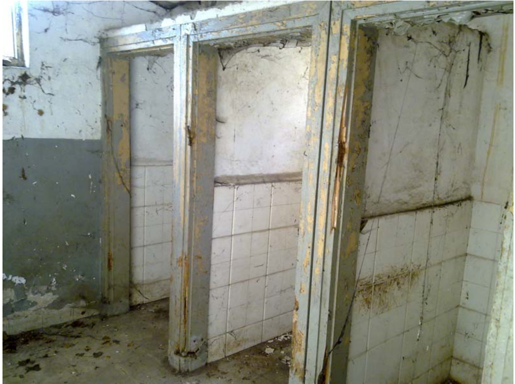
Şekil B.38 : Z08 Mekânı (Wc) batı duvarı tuvalet kabinleri.
