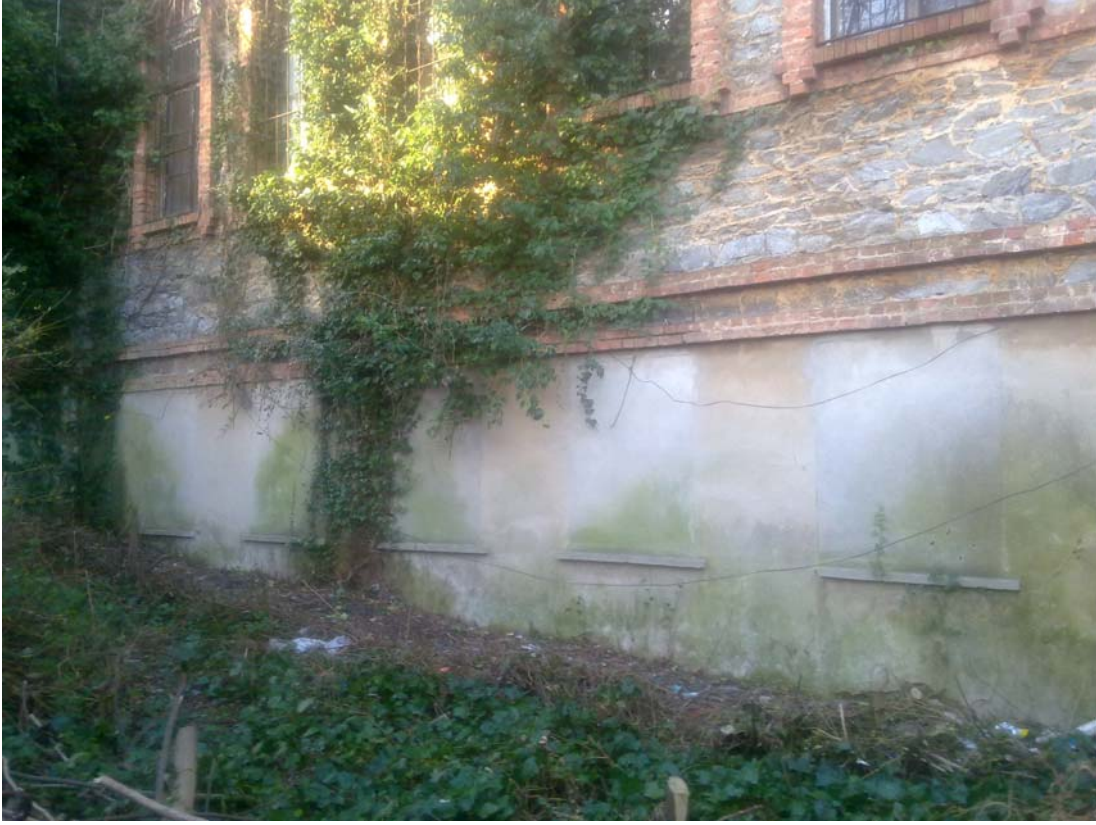
Şekil B.142 : Güney cephesindeki kapatılmış zemin kat pencereleri
