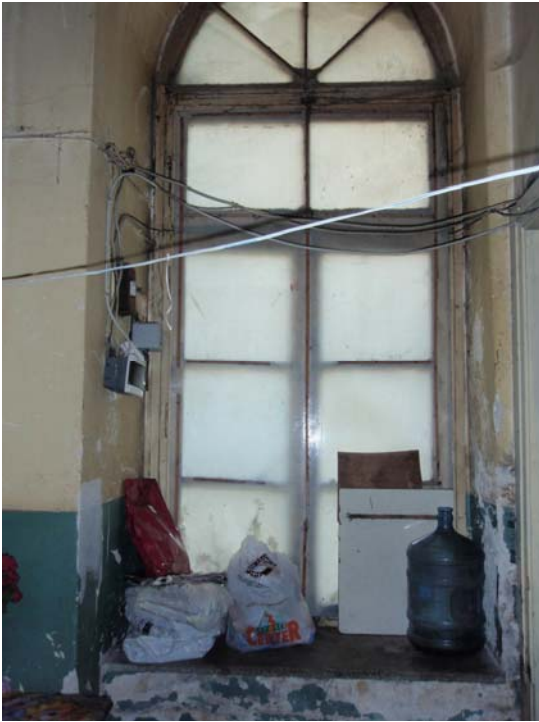
Şekil B.174 : Koruma amaçlı kapatılmış pencere
