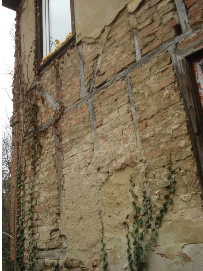
Şekil B.102 : 116 (Depo) mekânından girilen sökülmüş mekânın batı cephesinde görülen izi
