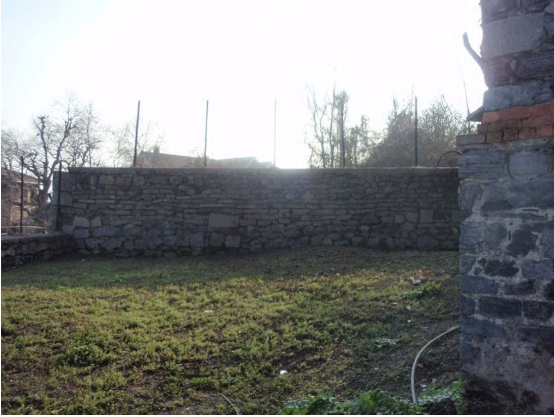
Şekil B.130 : Kuzey Cephesinde görülen moloz taş bahçe duvarı
