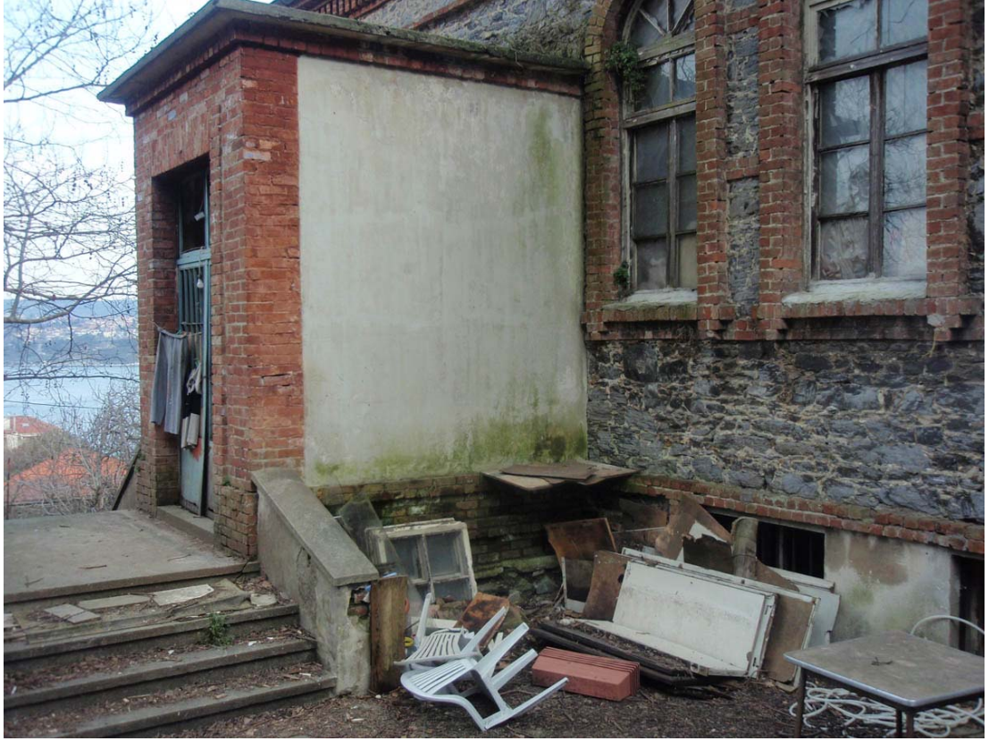
Şekil B.132 : 101 (Giriş) mekânına doğu yönünden giriş yapılan merdiven
