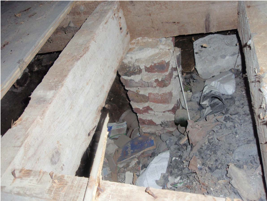
Şekil B.20 : Z03 mekânı (Sahne) taşıyıcıları.
