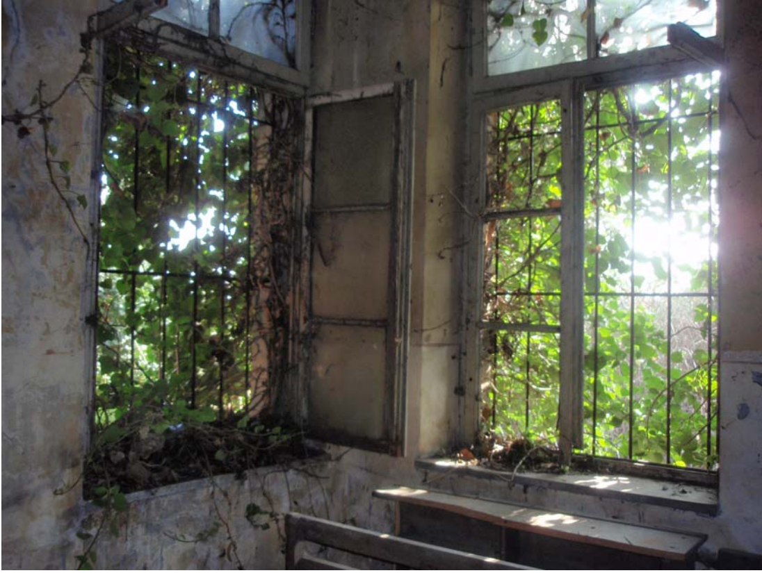
Şekil B.87 : 112 Mekânı (Derslik) doğu ve güney duvarına bakış
