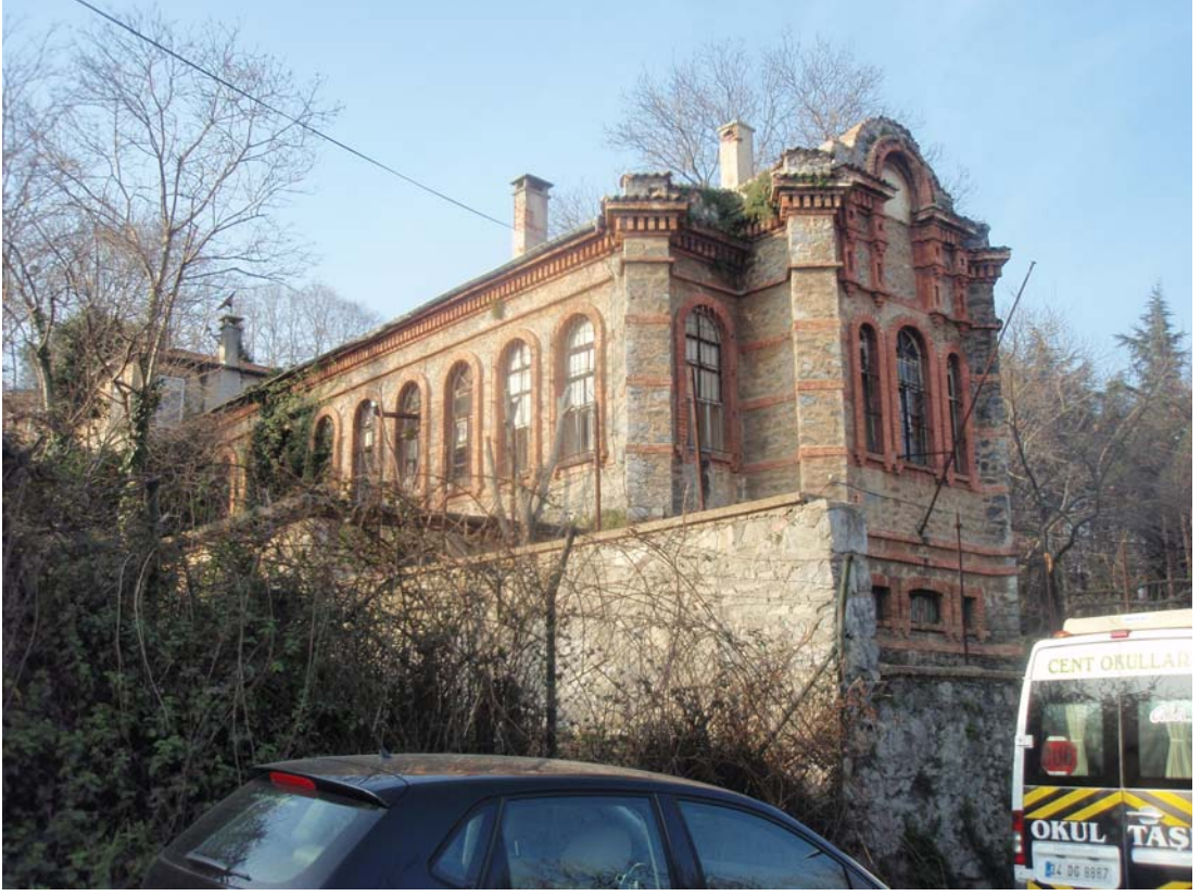
Şekil B.140 : Güney cephesi ve ön cepheye doğudan bakış
