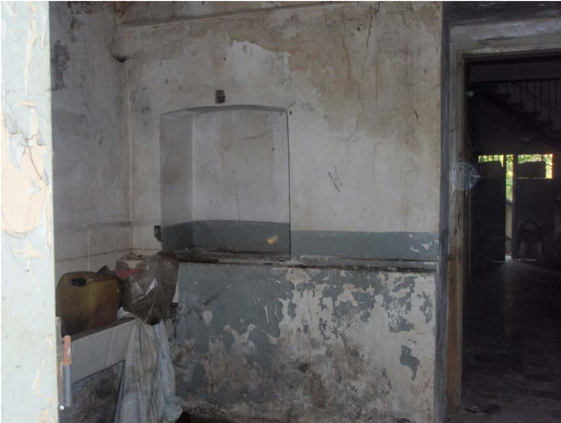
Şekil B.36 : Z08 Mekânı (Wc) kuzey duvarında bulunan niş.
