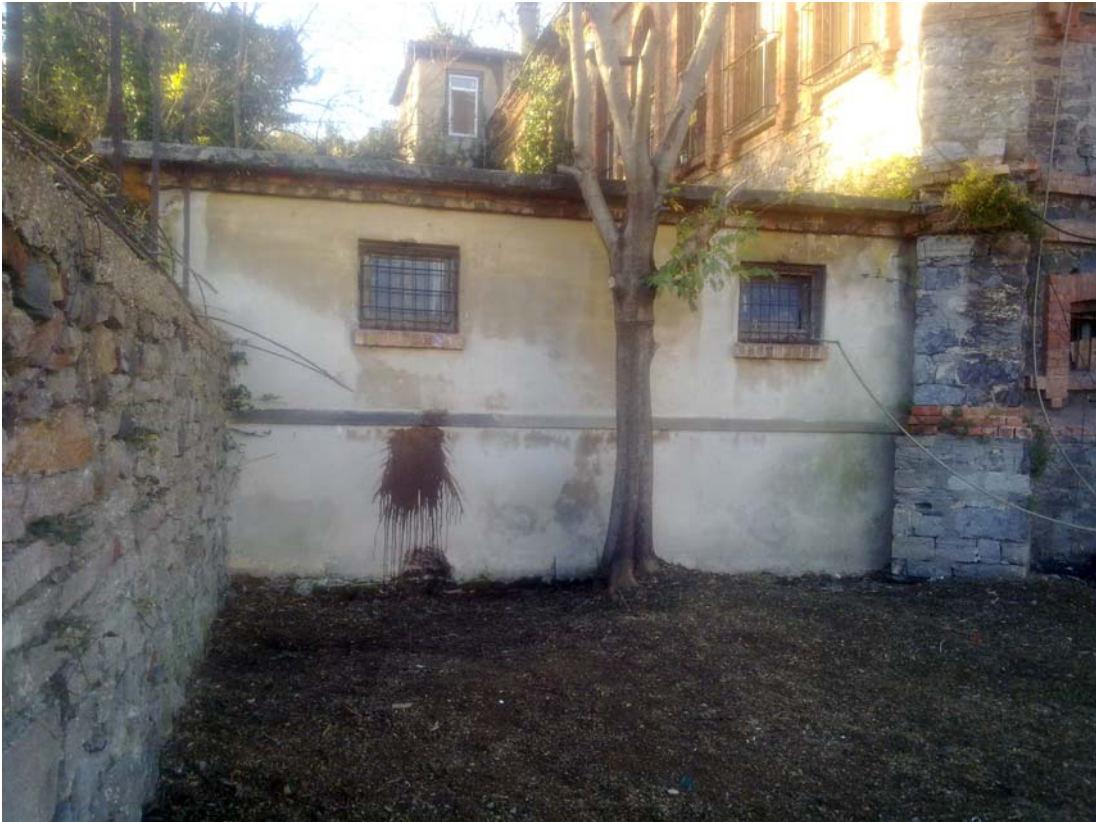
Şekil B.119 : Tuvalet birimlerinin doğu yönüne bakan cephesi
