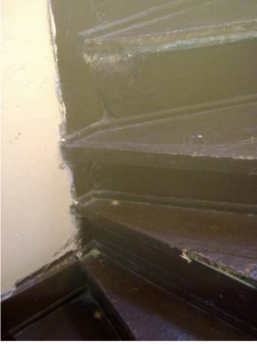
Şekil B.166 : İkinci kata çıkan merdiven detayı
