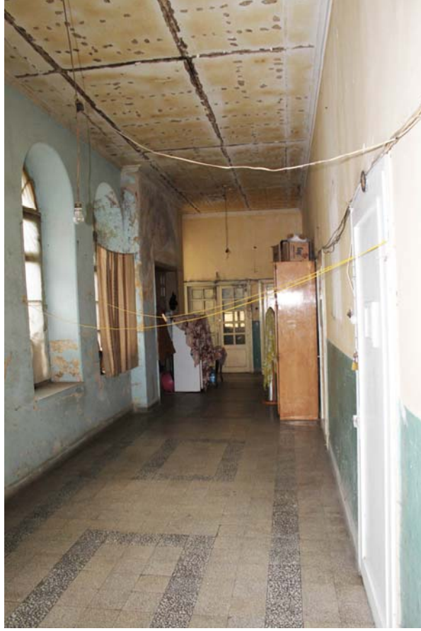
Şekil B.52 : 102 Mekânı (Hol) doğu duvarına bakış.
