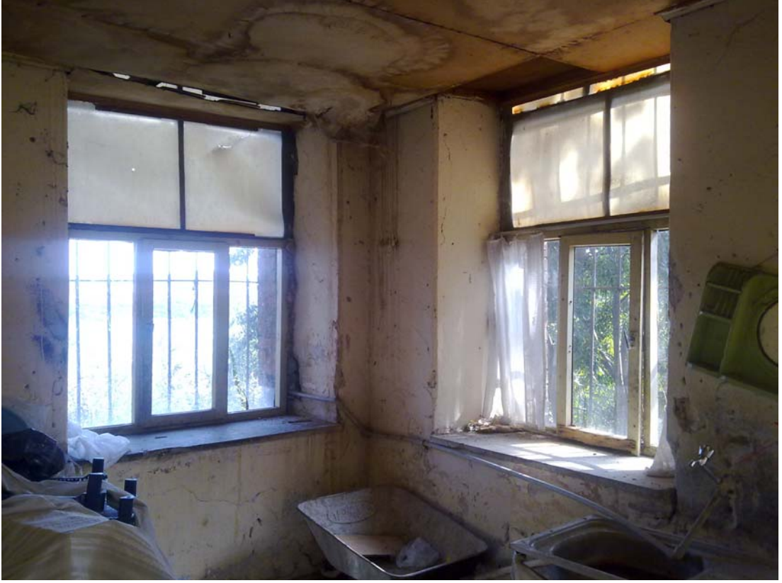
Şekil B.71 : 106 Mekânı (Müdür Odası) doğu ve güney duvarına bakış.
