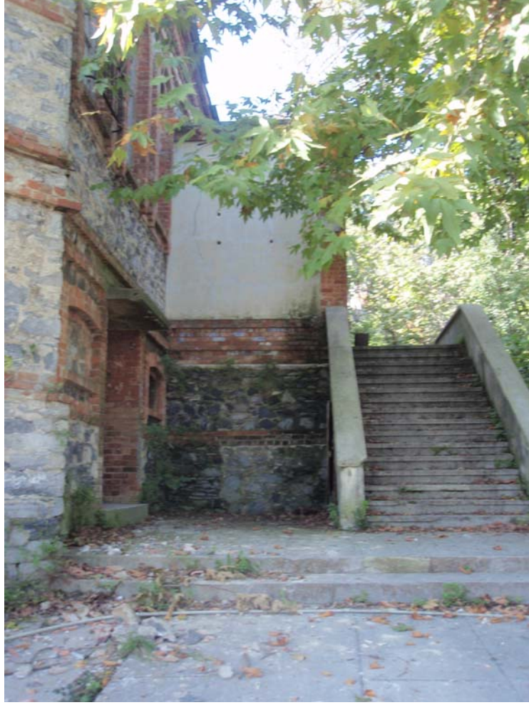
Şekil B.45 : Birinci kata dışarıdan, yapının kuzey cephesinden çıkan merdiven.
