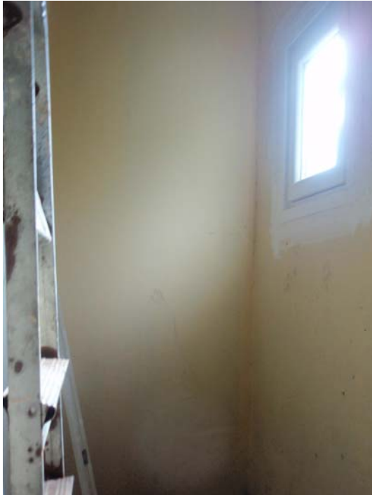
Şekil B.116 : 206 Mekânı (Depo) güney duvarına bakış.
