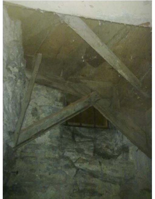
Şekil B.105 : 117 Mekânı (Depo) kuzey duvarına bakış.
