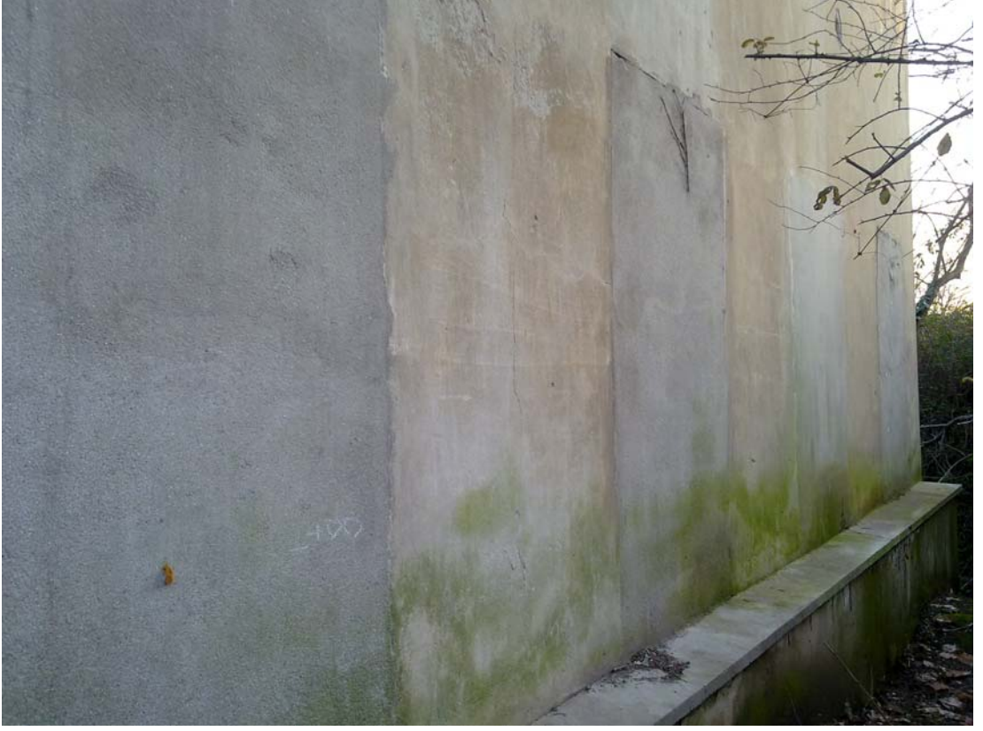
Şekil B.185 : Güney cephesinde bitkilenme
