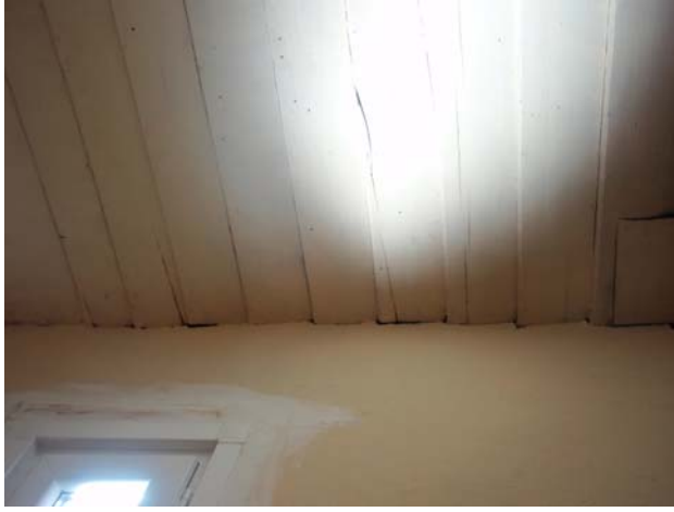
Şekil B.114 : 205 Mekânı (Depo) batı duvarına bakış.
