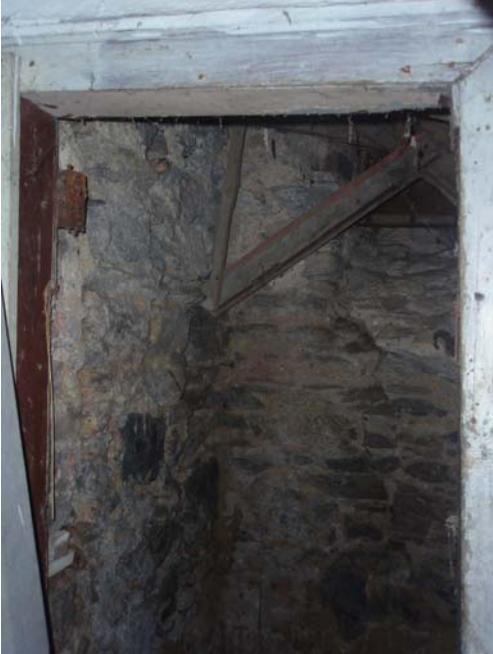
Şekil B.104 : 117 Mekânı (Depo) kuzey duvarına bakış.
