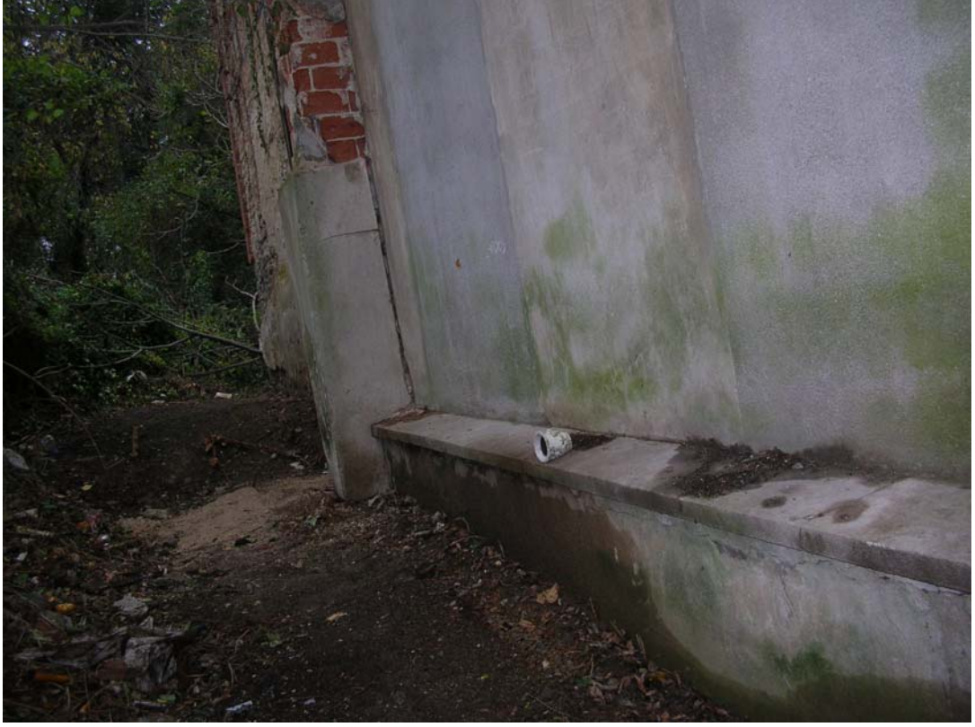
Şekil B.128 : Batı cephesi zemin kotu
