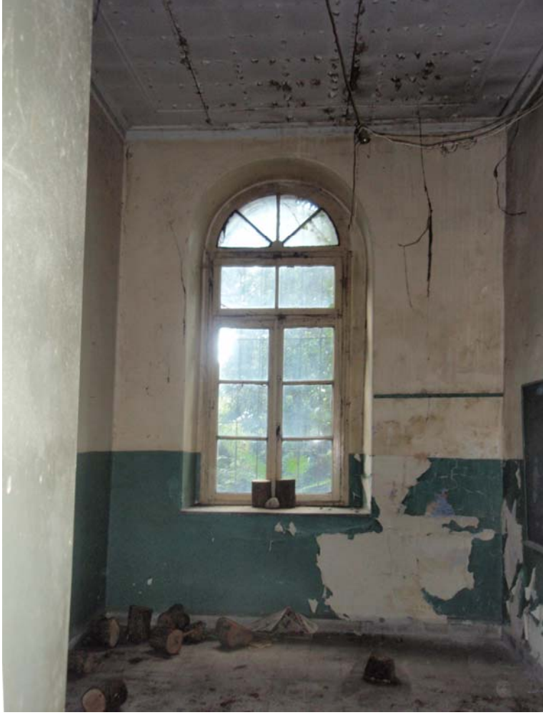
Şekil B.81 : 110 Mekânı (Derslik) güney duvarına bakış.
