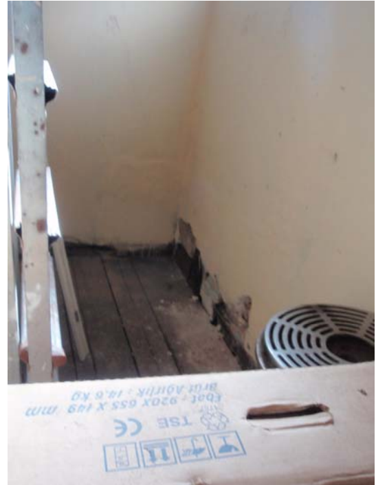
Şekil B.117 : 206 Mekânı (Depo) döşeme ve duvar birleşimi.
