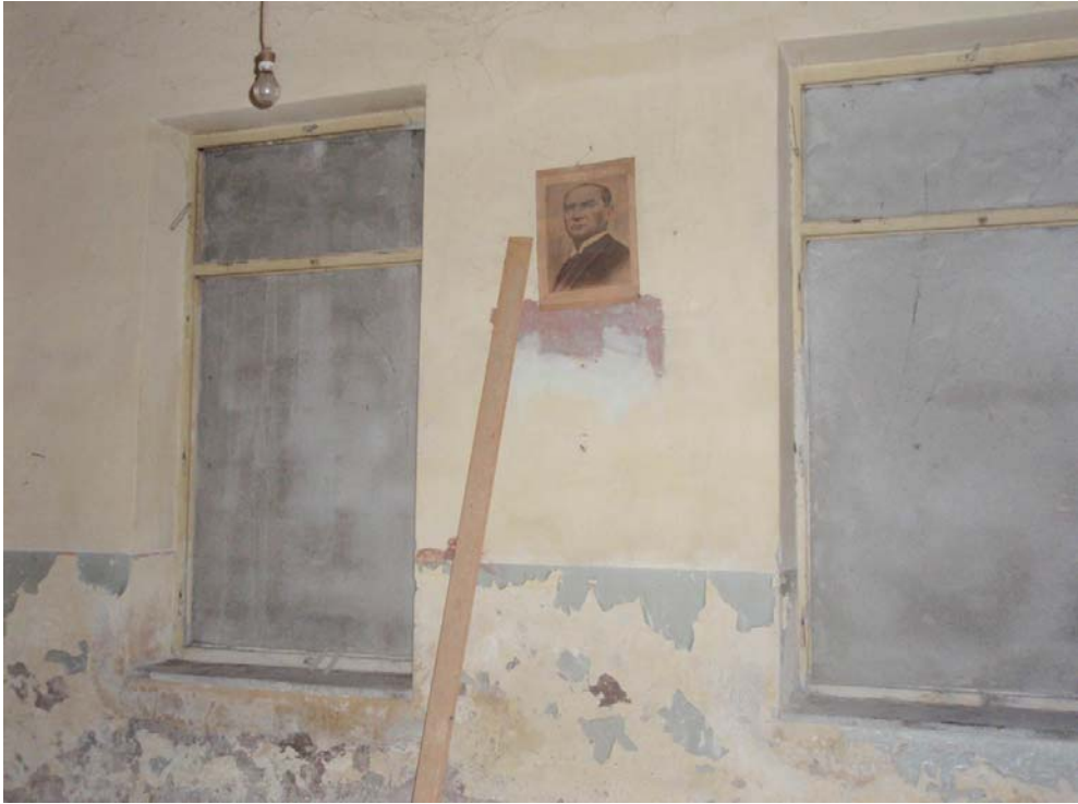
Şekil B.90 : 113 Mekânı (Derslik) batı duvarına bakış.
