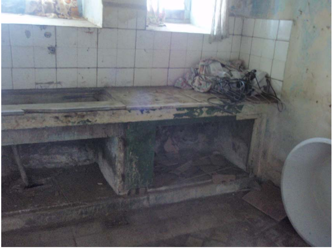
Şekil B.25 : Z05 Mekânı (Mutfak) doğu duvarına bakış.
