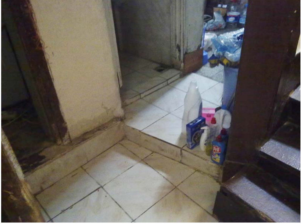
Şekil B.93 : 114 (Giriş) mekânına 102 (Hol) mekânından giriş ve seramik zemin kaplaması.
