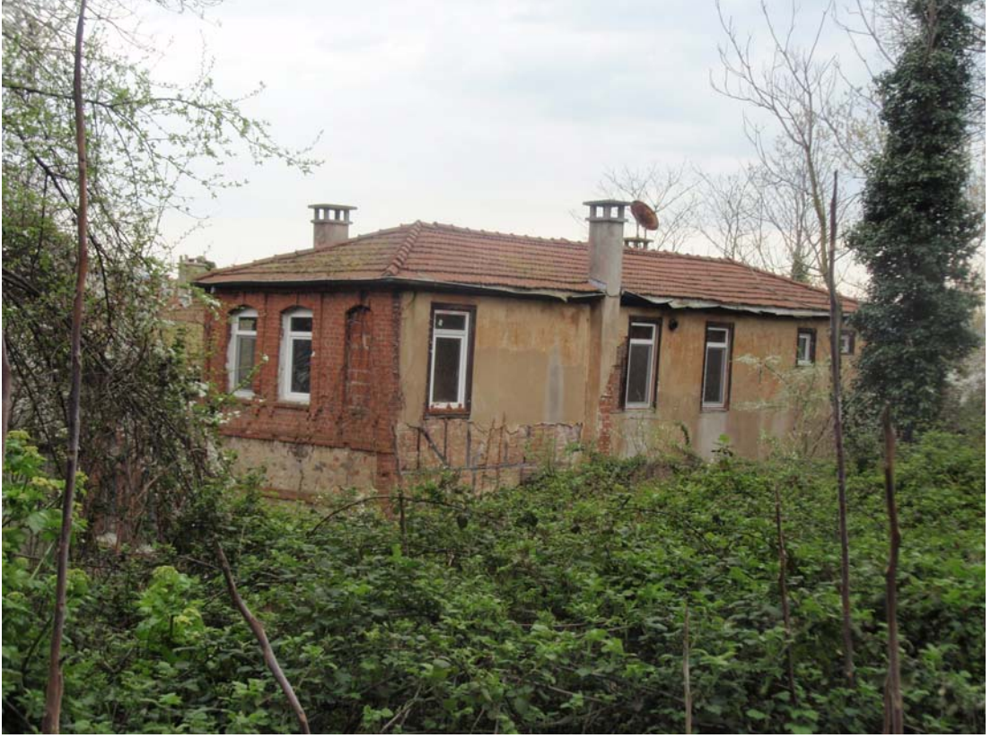
Şekil B.120 : Batı cephesine doğru bakış
