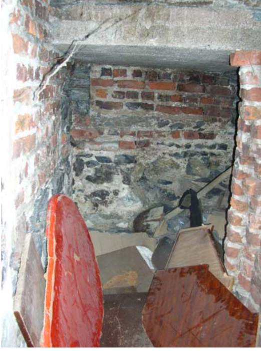
Şekil B.10: Merdiven altında kalan mekân
