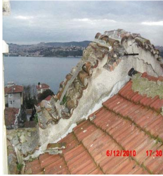
Şekil B.158 : Çatı detayı (Laki Vingas arşivi)
