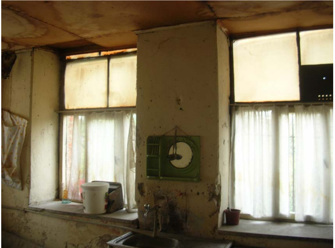
Şekil B.72 : 106 Mekânı (Müdür Odası) güney duvarına bakış.
