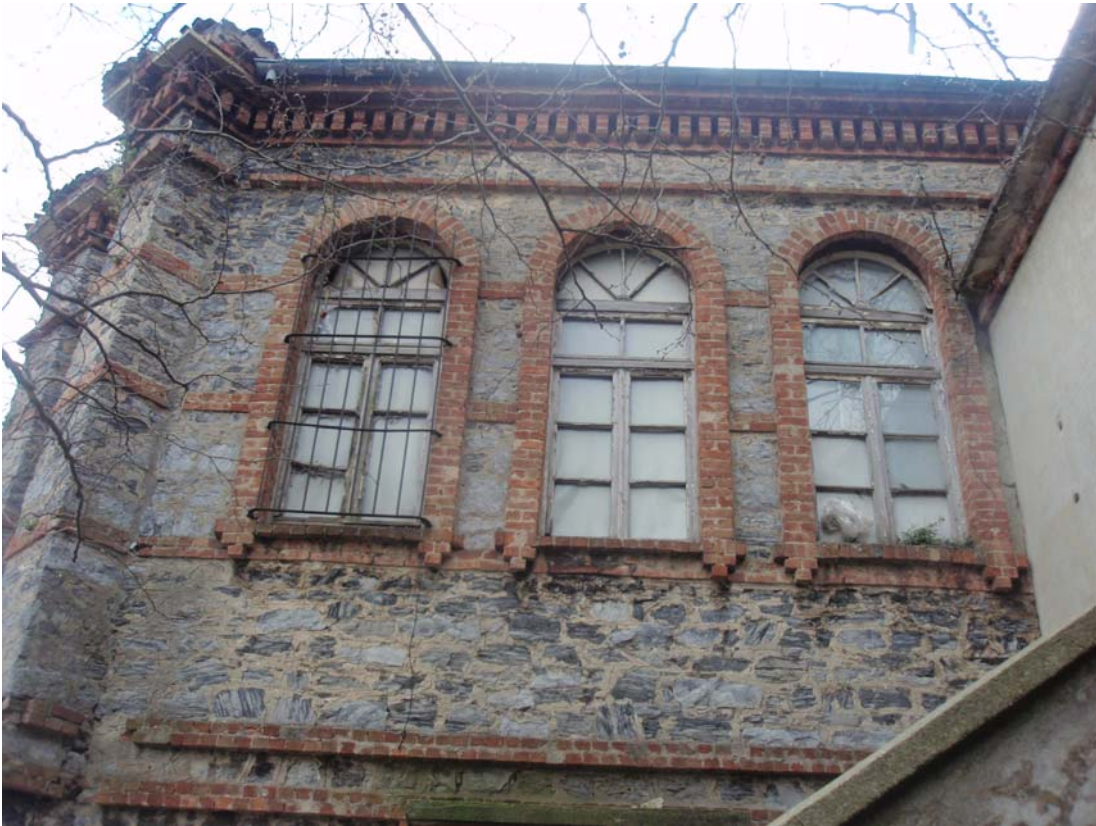
Şekil B.135 : Kuzey cephesinin batı köşesi
