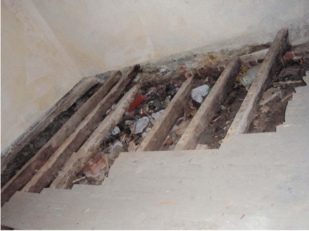
Şekil B.19: Z03 mekânı (Sahne) taşıyıcıları.
