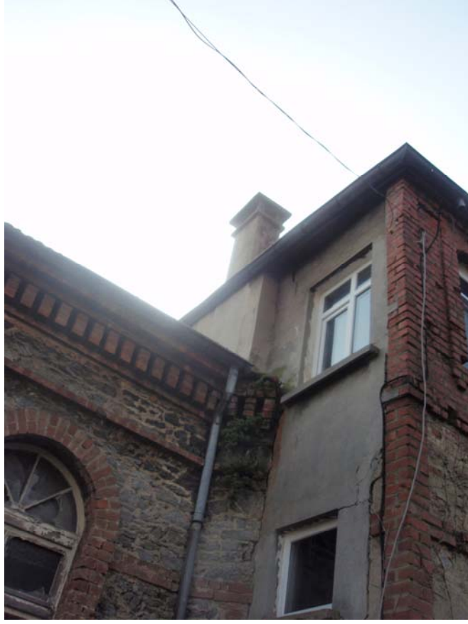
Şekil B.196 : 45 derecelik açı yapan duvarların kesintiye uğradığını gösterir detay
