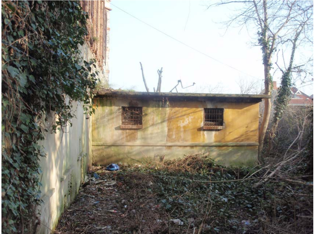
Şekil B.145 : Güney cephesinden tuvalet birimlerine bakış
