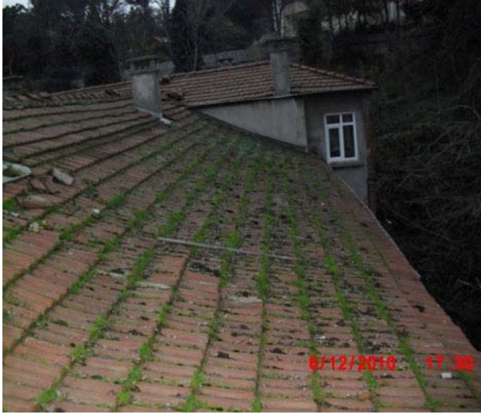
Şekil B.156 : Çatı detayı (Laki Vingas arşivi)
