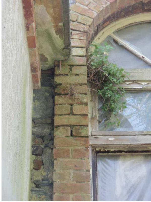
Şekil B.190: Derzlerde boşalma, bitki oluşumu ve çimentolu harç kullanımı
