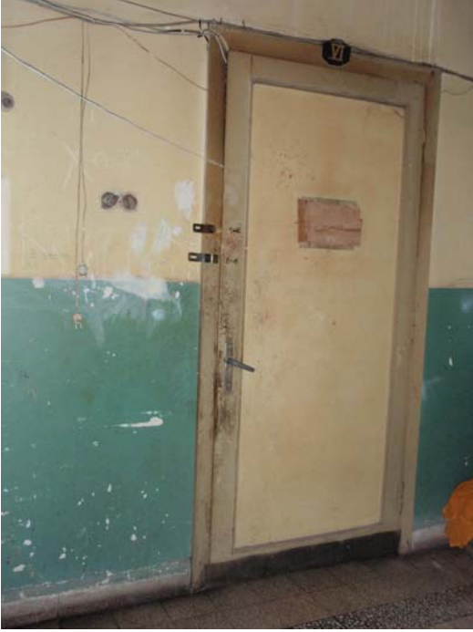
Şekil B.168 : 107 mekânının kapısı
