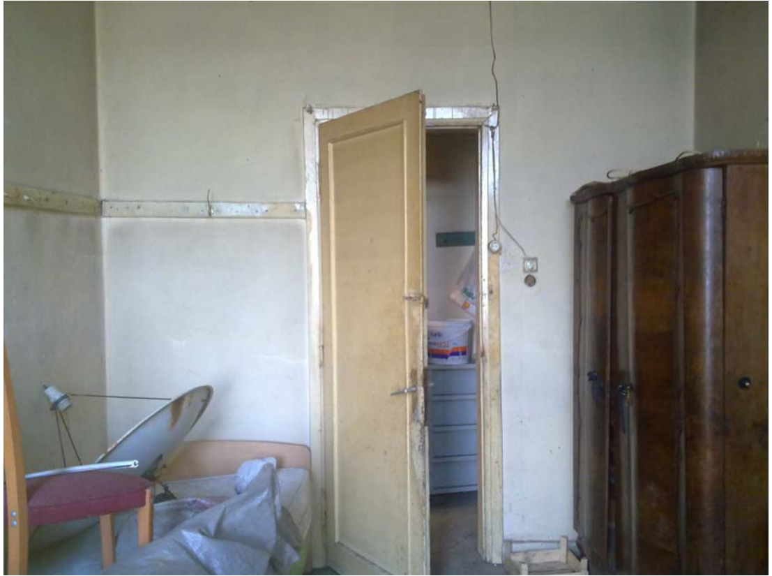
Şekil B.62 : 105 Mekânı (Öğretmenler Odası) batı duvarına bakış.
