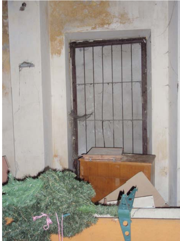
Şekil B.16: Z02 (Yemekhane ve Tiyatro Salonu) mekânında bulunan kapatılmış kapı
