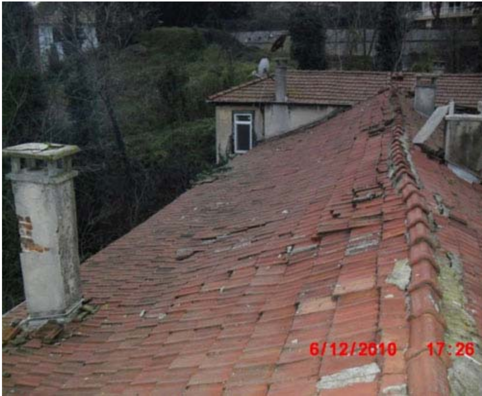
Şekil B.161 : Çatı detayı (Laki Vingas arşivi)
