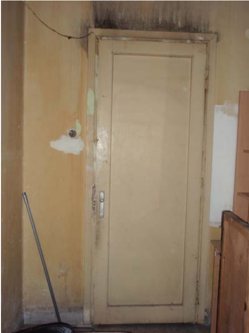
Şekil B.59 : 104 Mekânı (Gardrop) batı duvarına bakış.
