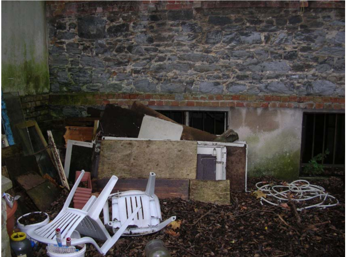
Şekil B.133 : Z02 mekânının kuzey cephesine bakan pencereleri
