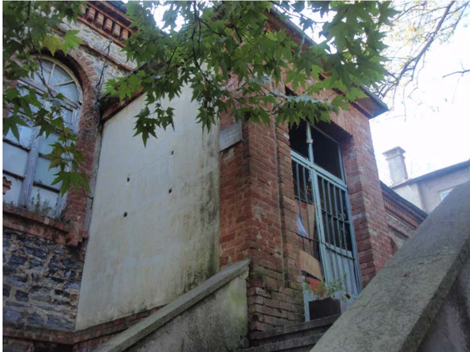
Şekil B.46 : 101 (Giriş) mekânına dışarıdan giriş sağlayan kapı
