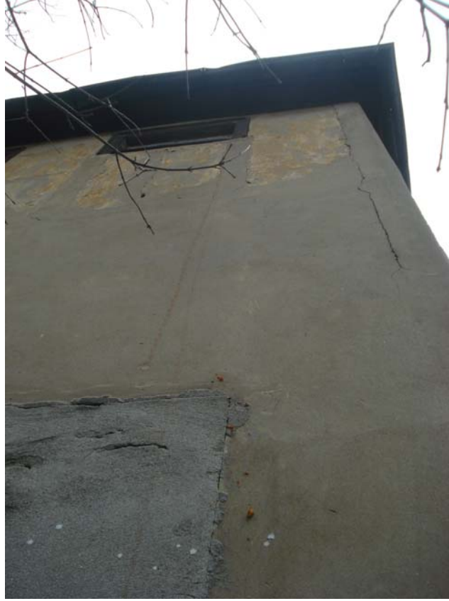
Şekil B.202 : II. Döneme ait pencere ve köşe tuğla elemanlarının izleri
