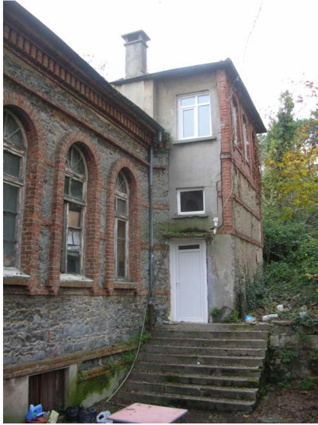
Şekil B.92 : 114 (Giriş) mekânına dışarıdan giriş kapısı.
