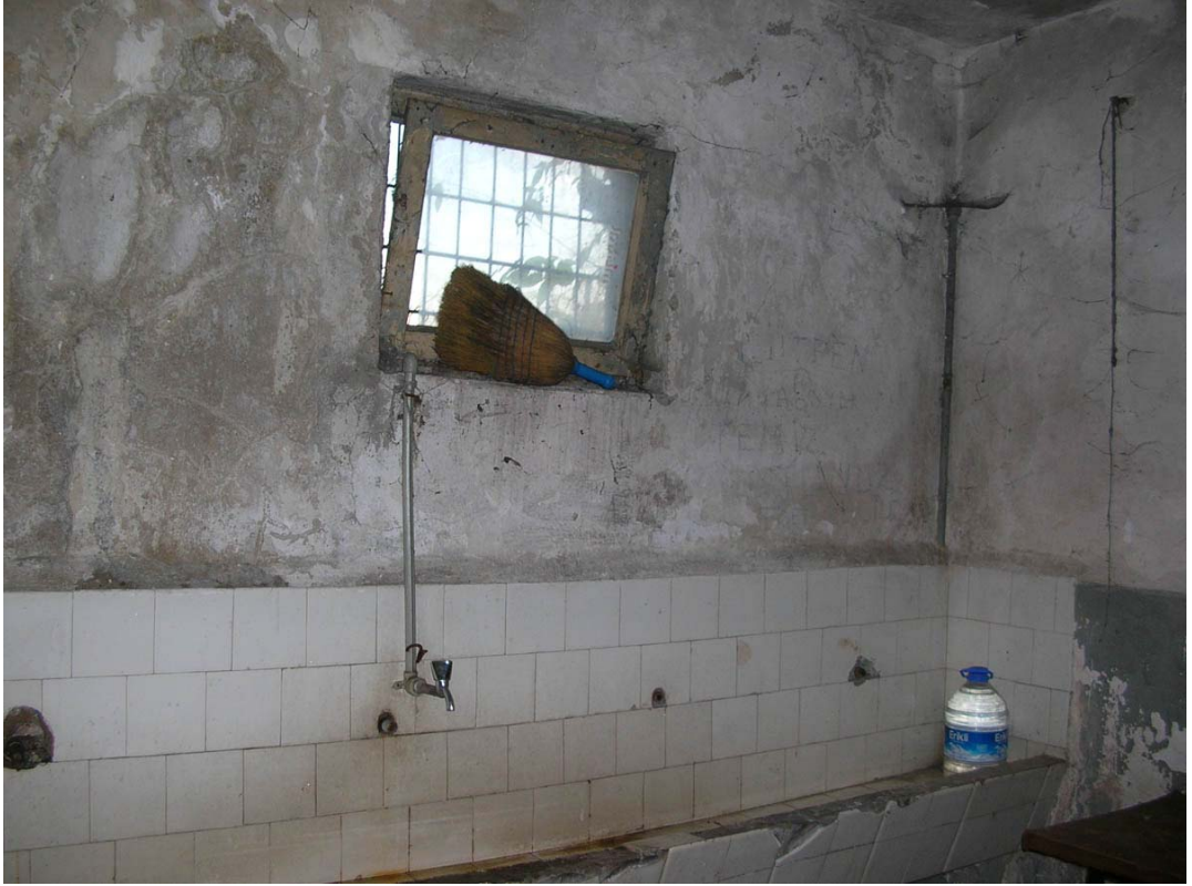
Şekil B.30: Mekânı (Wc) doğu duvarı el yıkama yerleri.
