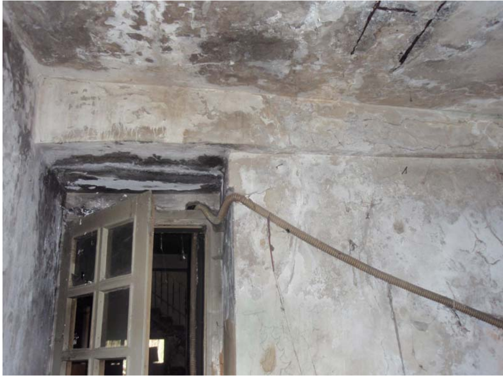
Şekil B.34 : Z07 (Wc) mekânının girişi ve tavanı.
