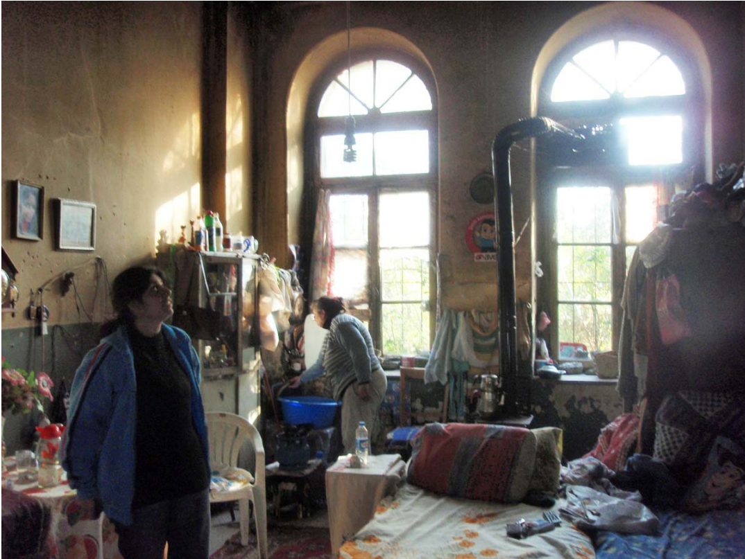
Şekil B.74 : 107 Mekânı (Derslik – Oturma Odası) güney duvarına bakış.
