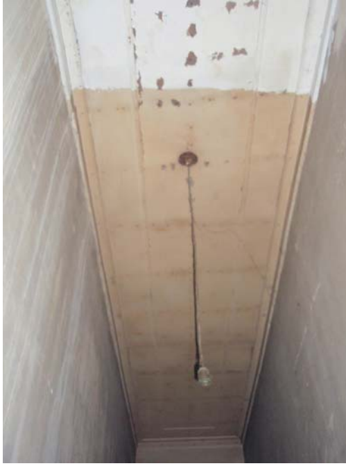
Şekil B.84 : 111 Mekânı (Hol) ahşap tavan kaplaması.
