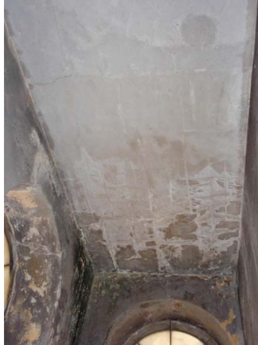
Şekil B.177 : Merdiven kovanında nem sorunları ve çiçeklenme
