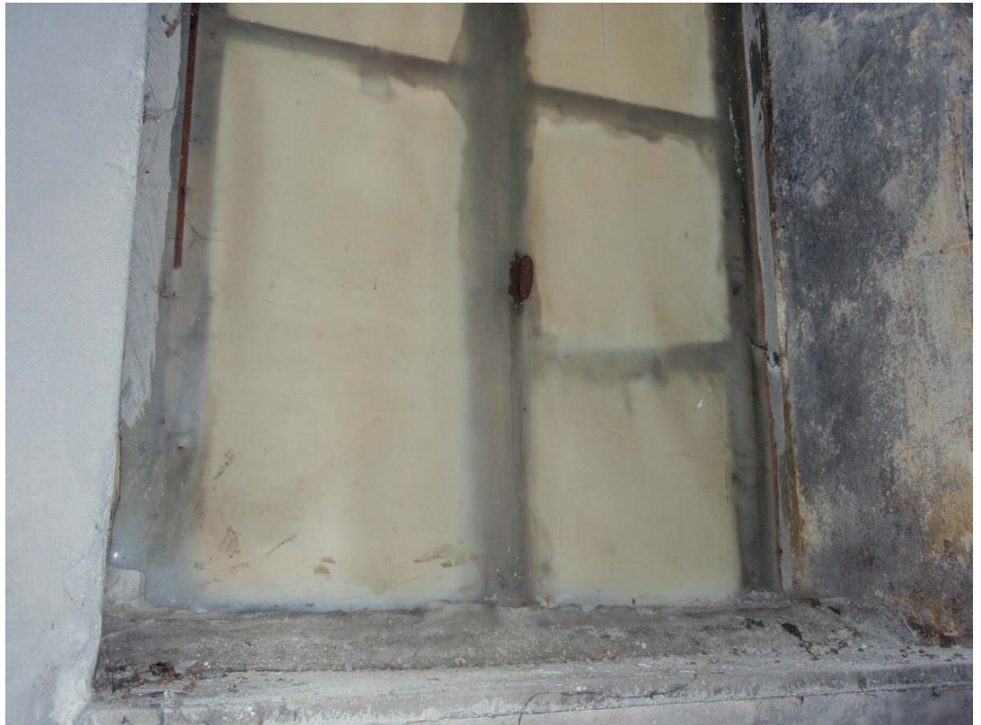
Şekil B.171 : Pencere denizliklerinde kullanılan çimentolu sıva ve koruyucu plastik örtü
