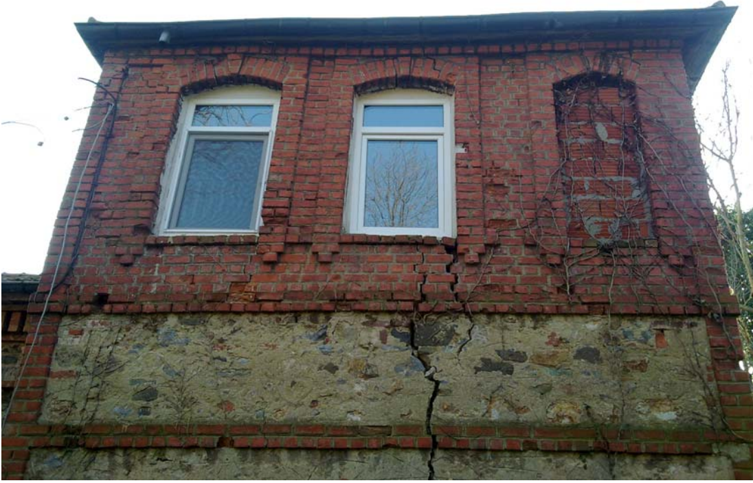
Şekil B.138 : Hizmetli biriminin kuzey cephesi
