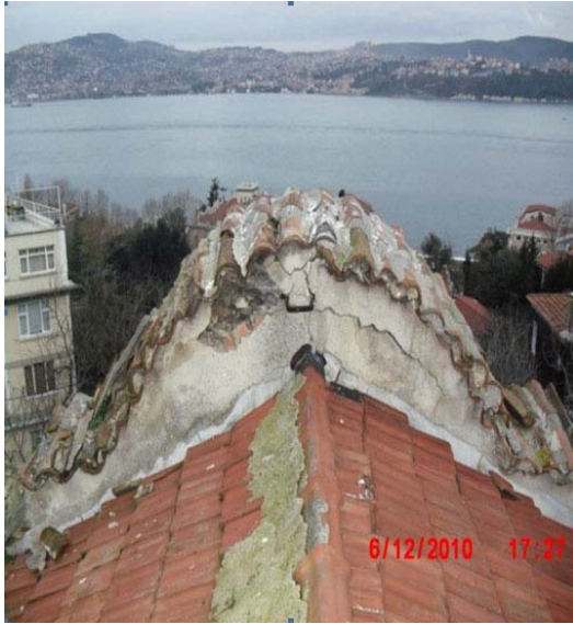
Şekil B.157 : Çatı detayı (Laki Vingas arşivi)
