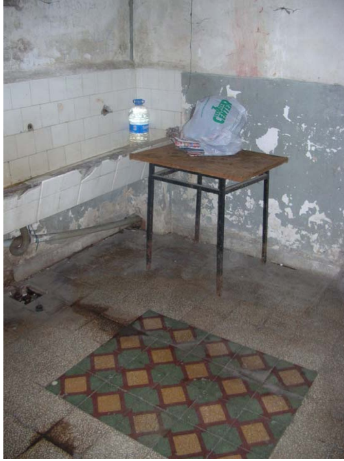
Şekil B.33 : Z07 (Wc) mekânının karo mozaik kaplaması.
