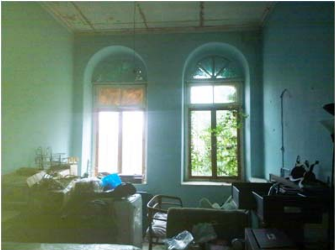
Şekil B.76 : 108 Mekânı (Derslik) güney duvarına bakış.
