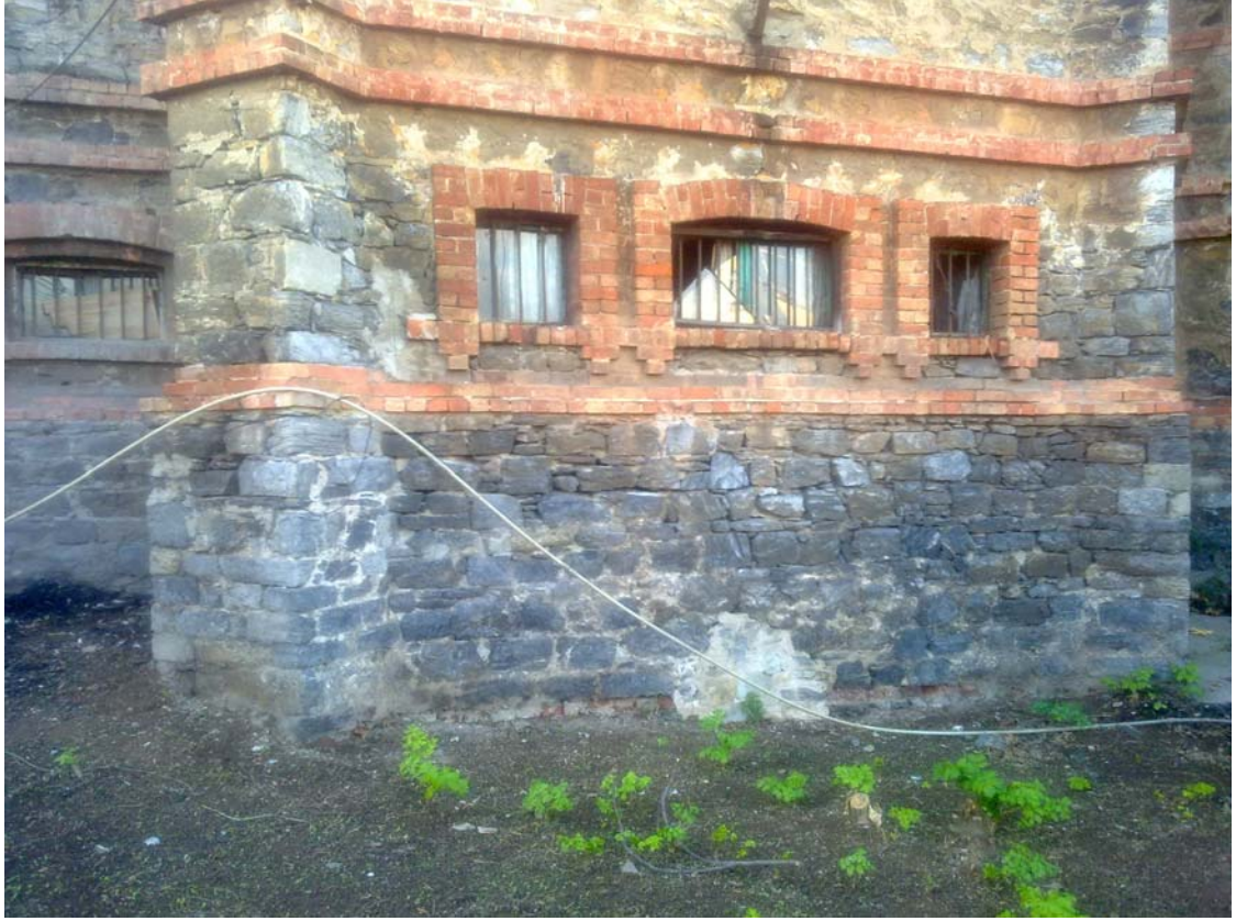
Şekil B.198 : Duvarın zeminle birleştiği yerde bulunan dolgu ve bir kat tuğla silme
