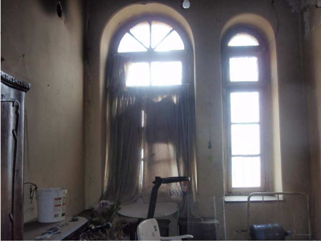
Şekil B.63 : 105 Mekânı (Öğretmenler Odası) doğu duvarına bakış.
