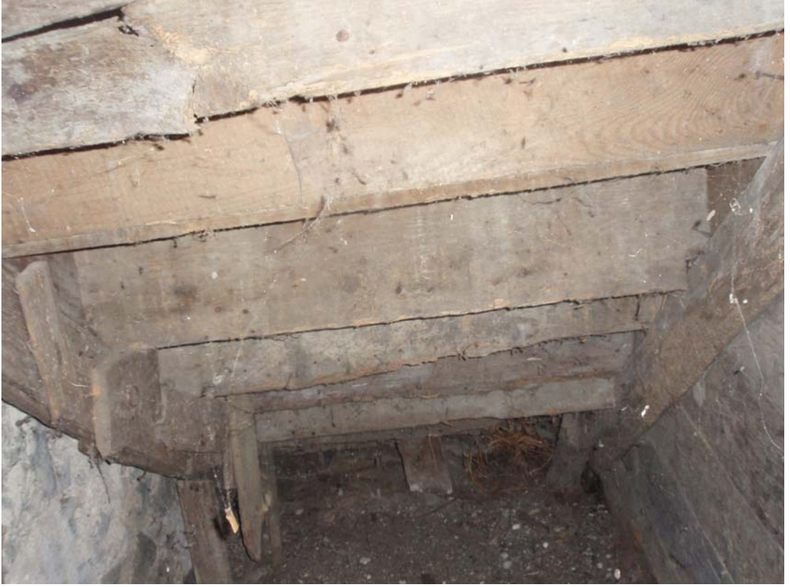
Şekil B.103 : 117 (Depo) mekânında görülen merdiven konstrüksiyonu.
