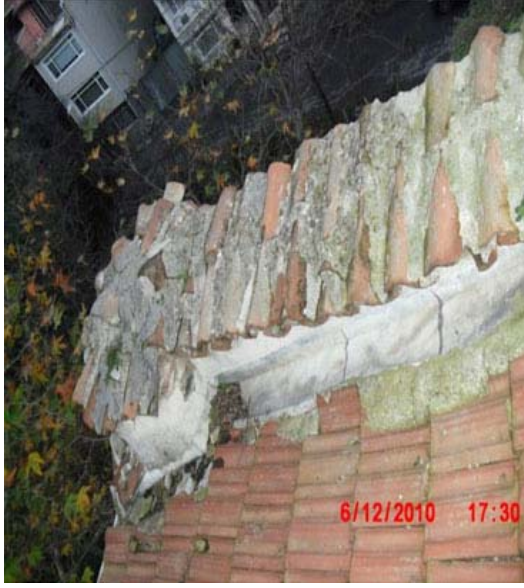
Şekil B.159 : Çatı detayı (Laki Vingas arşivi)
