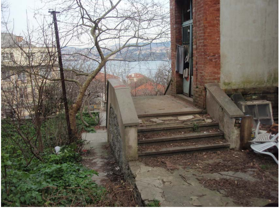
Şekil B.164 : Merdiven ve yanındaki rampa görünüşü
