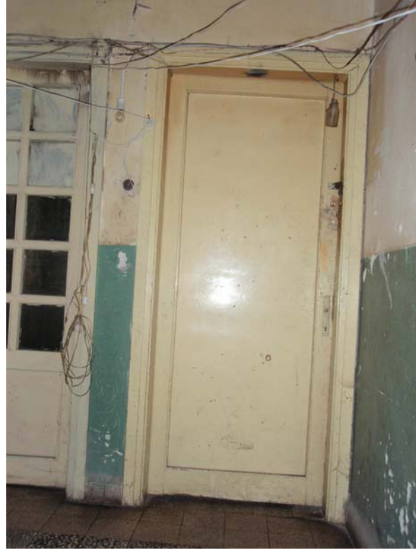
Şekil B.53 : 102 Mekânı (Hol) doğu duvarına bakış.
