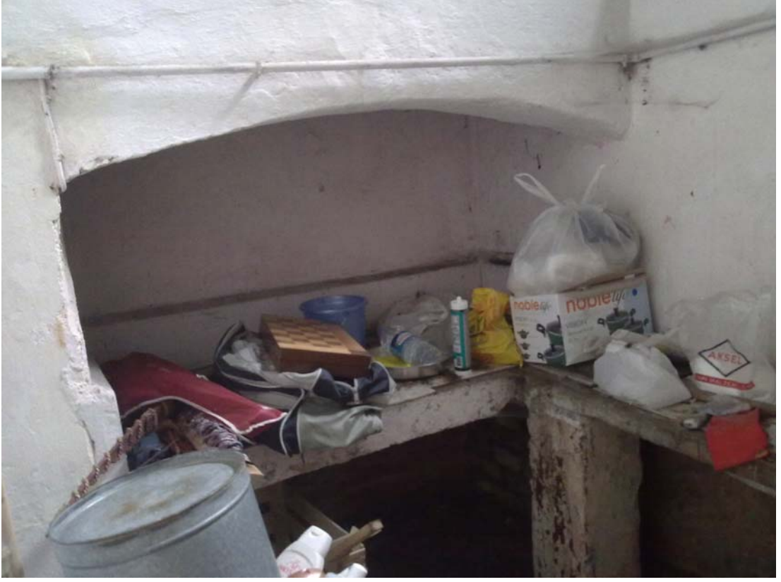
Şekil B.98 : 116 Mekânı (Depo) güney ve batı duvarına bakış.
