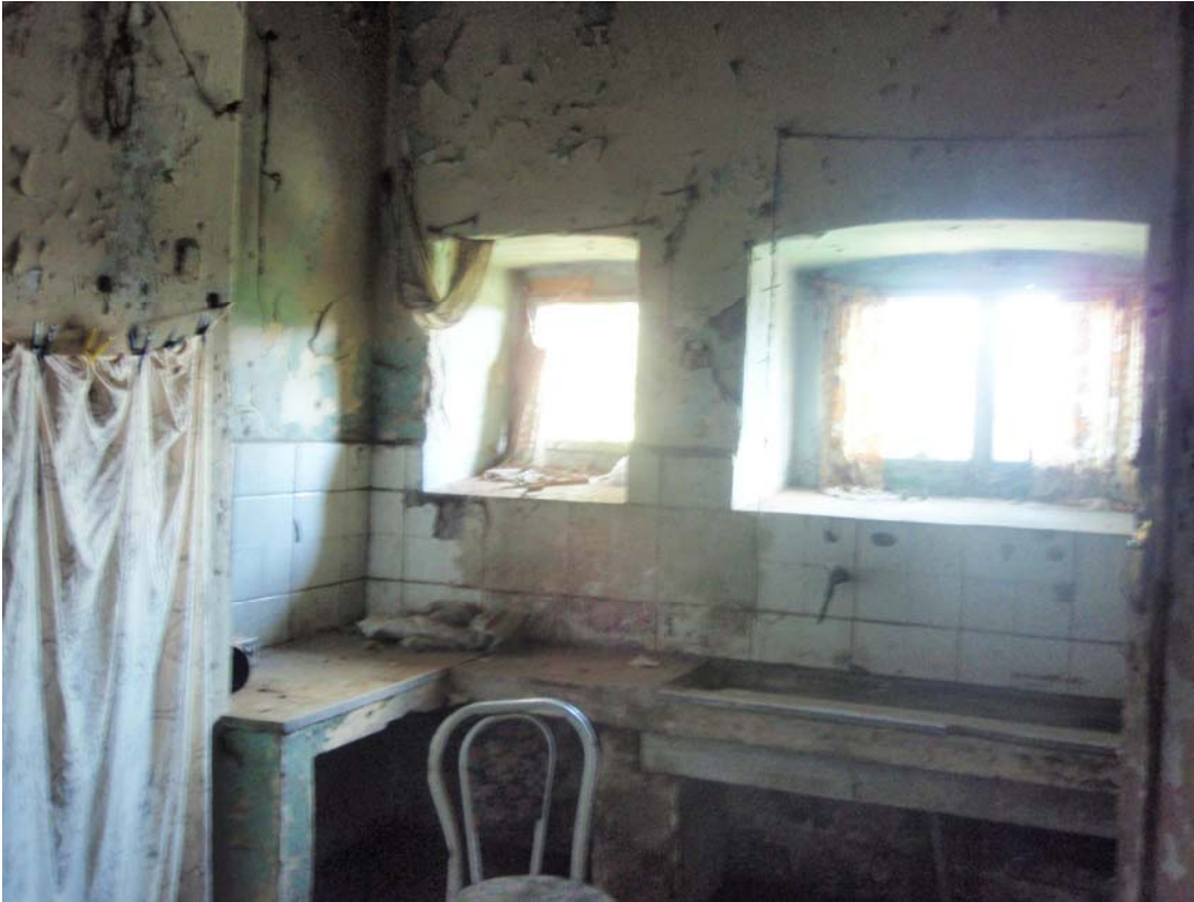
Şekil B.24 : Z05 Mekânı (Mutfak) doğu ve kuzey duvarlarındaki tezgah.
