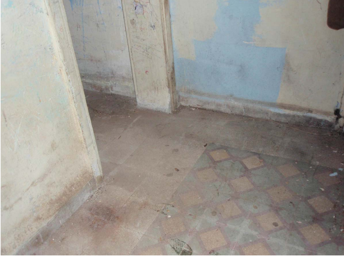
Şekil B.27 : Z05 (Mutfak) mekânının karo mozaik kaplaması.
