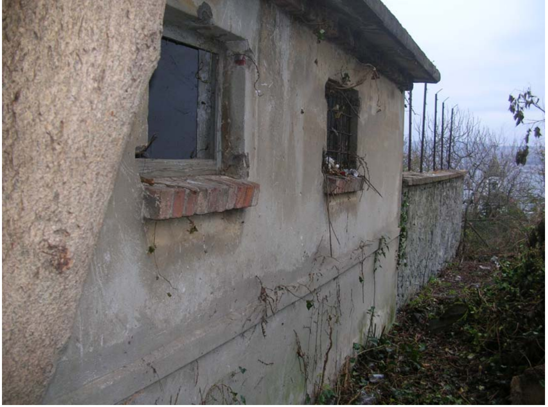
Şekil B.144 : Tuvaletlerin güney cephesi
