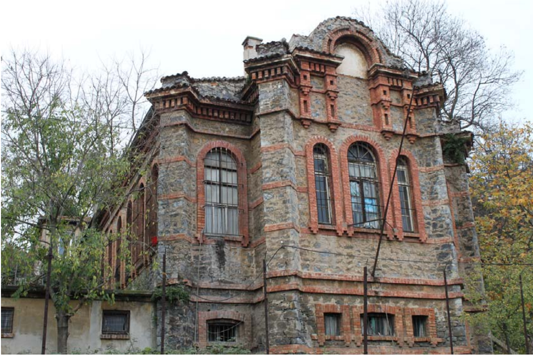
Şekil B.118 : Doğu Cephesi (ön cephe)
