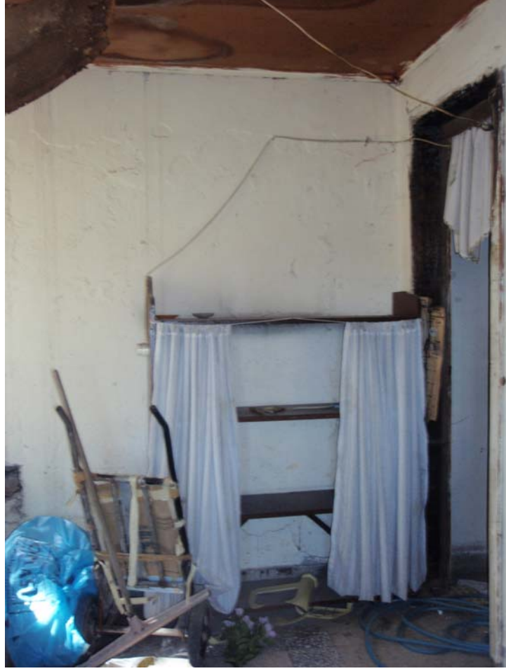
Şekil B.66 : 106 Mekânı (Müdür Odası) batı duvarına bakış.
