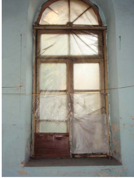
Şekil B.173 : Koruma amaçlı kapatılmış pencere
