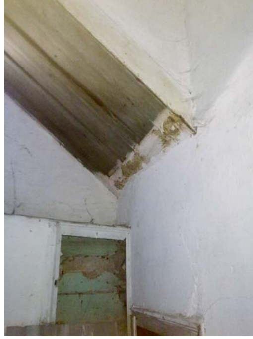
Şekil B.101 : 116 (Depo) mekânında bulunan kapatılmış kapı.
