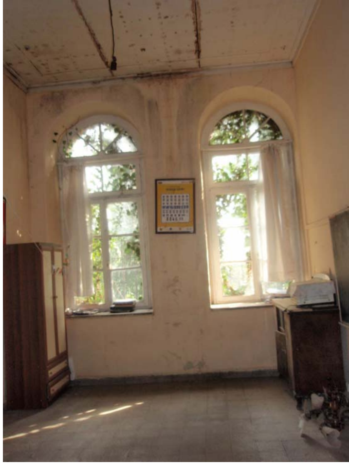
Şekil B.79 : 109 Mekânı (Derslik) güney duvarına bakış.
