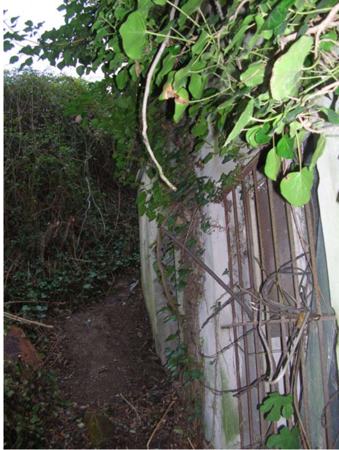
Şekil B.150 : Hizmetli birimi güney duvarı
