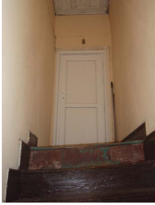
Şekil B.167 : İkinci kata çıkan merdiven detayı
