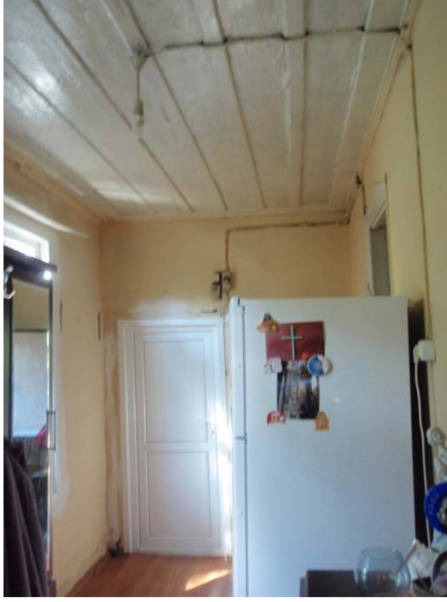
Şekil B.106 : 201 Mekâkı (Hol) kuzey duvarına bakış
