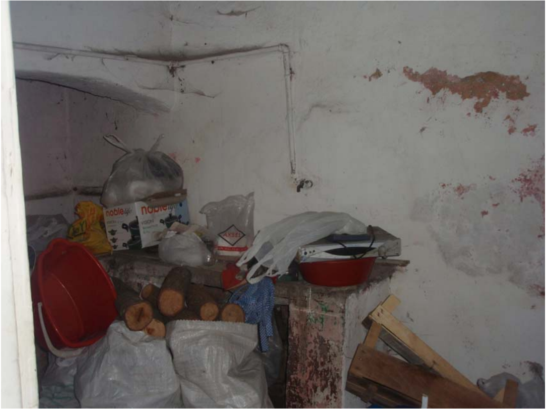
Şekil B.99 : 116 Mekânı (Depo) batı duvarına bakış.
