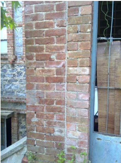
Şekil B.188 : Tuđla yzeylerde tuzlanma
