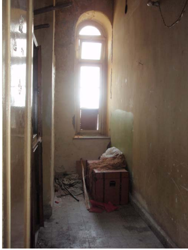
Şekil B.61 : 104 Mekânı (Gardrop) doğu duvarına bakış.
