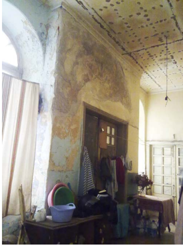
Şekil B.50 : 102 (Hol) mekânına geçiş sağlayan kapılar.
