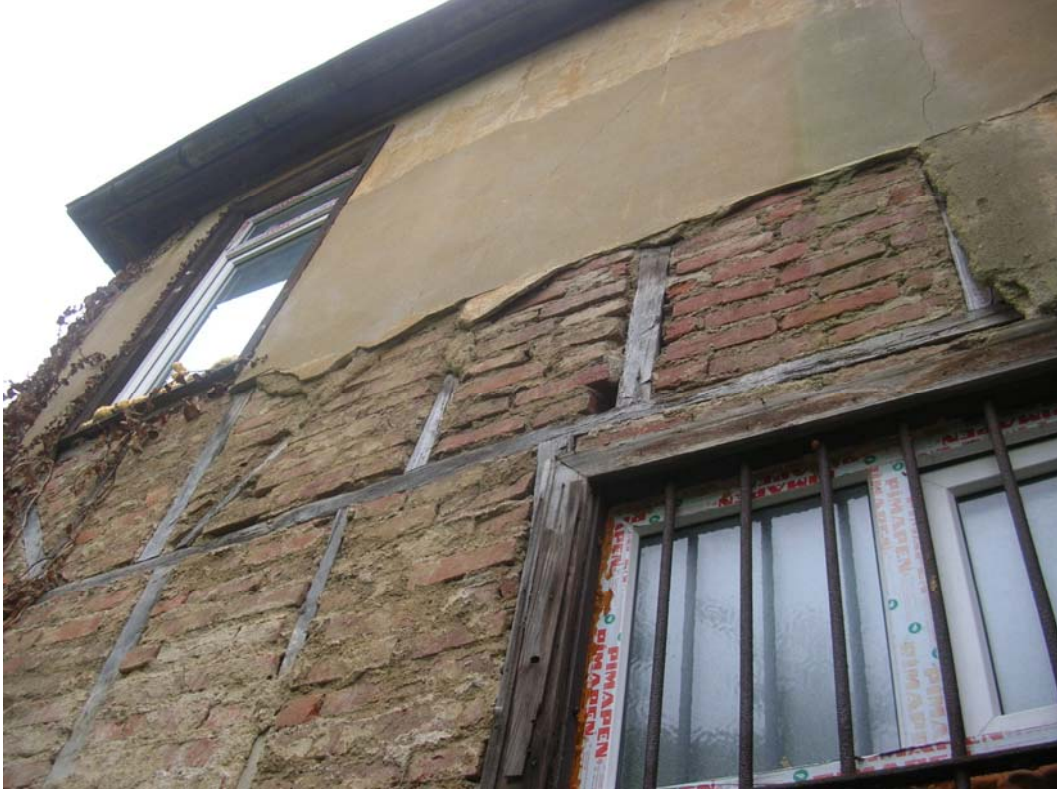
Şekil B.126 : Batı cephesi kuzey köşesine doğru bakış
