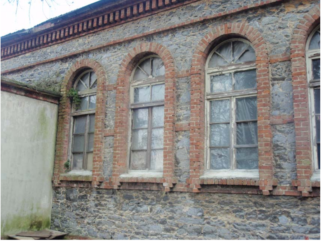
Şekil B.136 : 101 (Hol) mekânının kuzey cephesi
