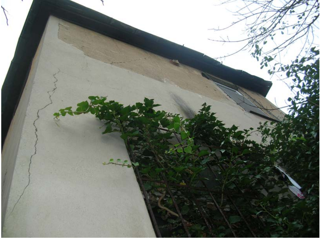
Şekil B.149 : Hizmetli birimi güney duvarı
