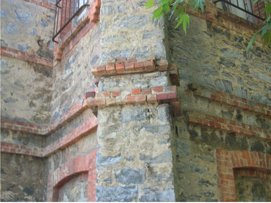
Şekil B.192 : Tuğlalarda kopmalar ve yüzey kirliliği
