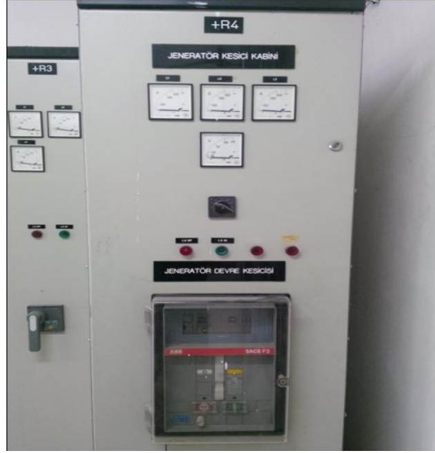
Şekil 5.9 : Dizel generatör kesici kabini.
