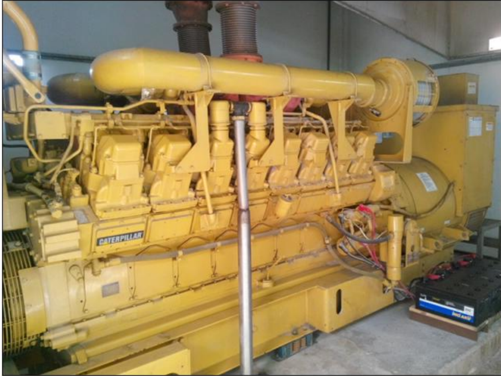
Şekil 5.6 : Dizel generatör.
